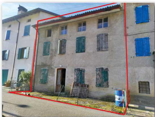
01. VEDUTA IMMOBILE DA EST
