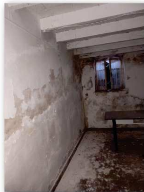
08. INFILTRAZIONI METEORICHE
