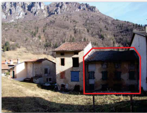
05. VEDUTA IMMOBILE DA OVEST
