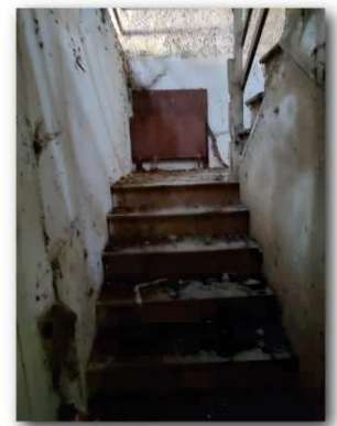
24. ACCESSO ALLA SOFFITTA
