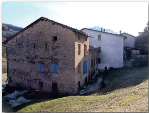
04. VEDUTA DAL RETRO (NORD-OVEST)
