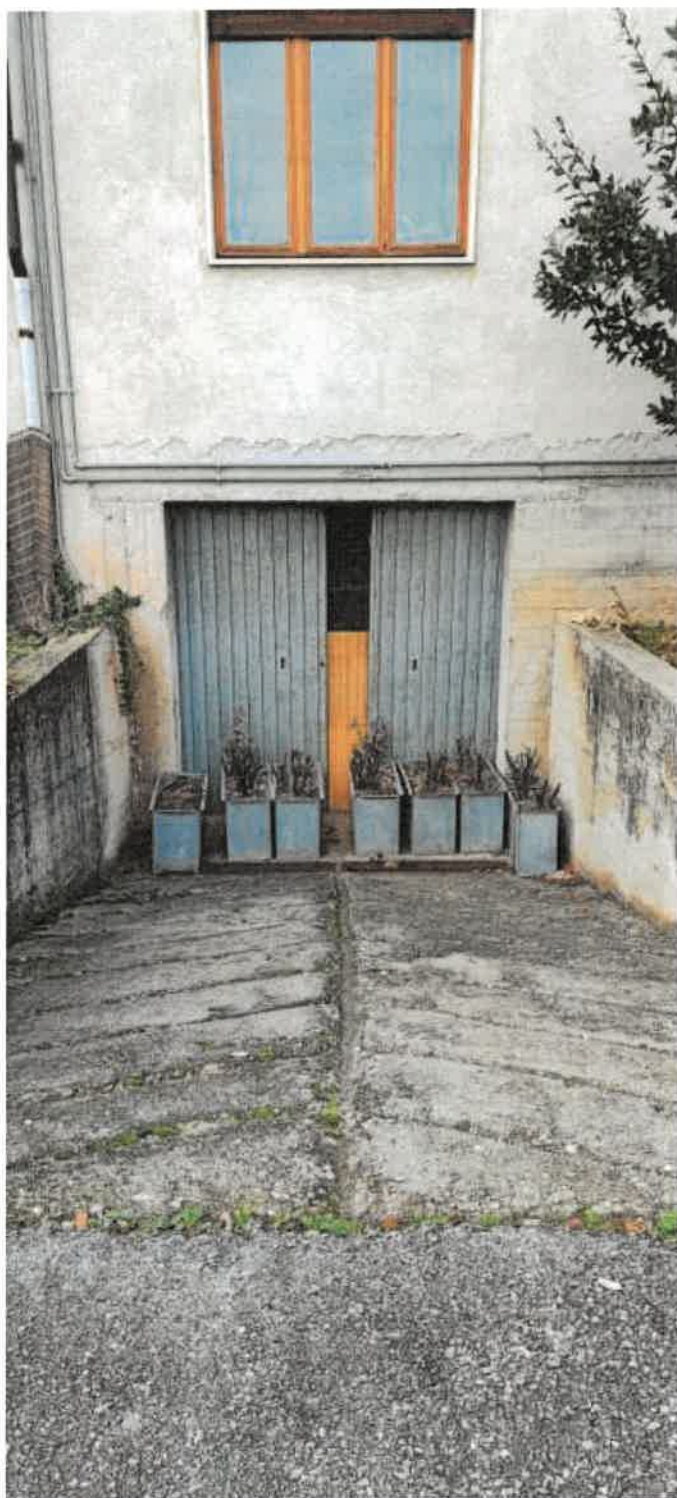
Rampa di accesso garage
