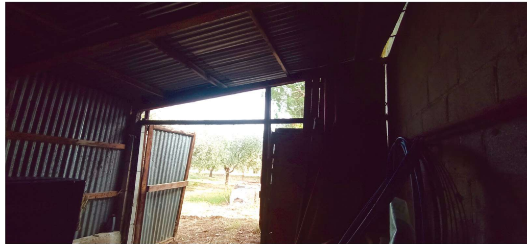
Manufatto autocostruito - vista interna
