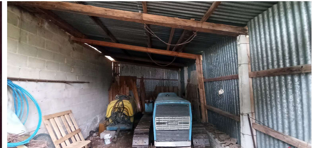
Manufatto autocostruito - vista interna
