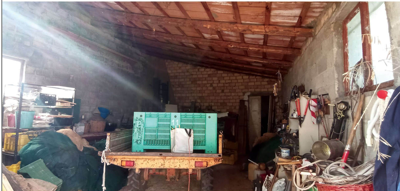
Magazzino/rimessa agricola e manufatto annesso - viste interne - primo ambiente
