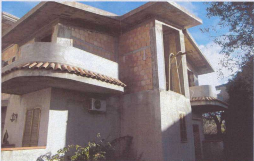
FOTO N°4 VISTA DI INSIEME (LATO EST)
