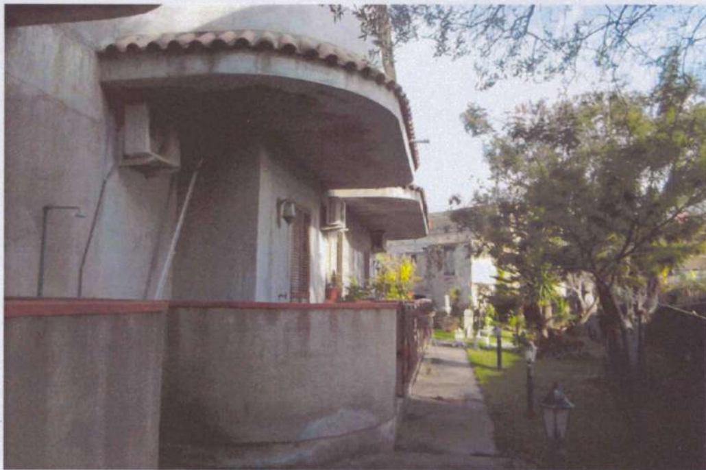
FOTO N°5 PROSPETTO (LATO SUD)
