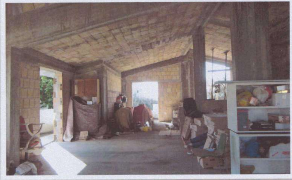
FOTO N°15 VISTE INTERNE ALL'UNITA' IMMOBILIARE AL PRIMO PIANO
