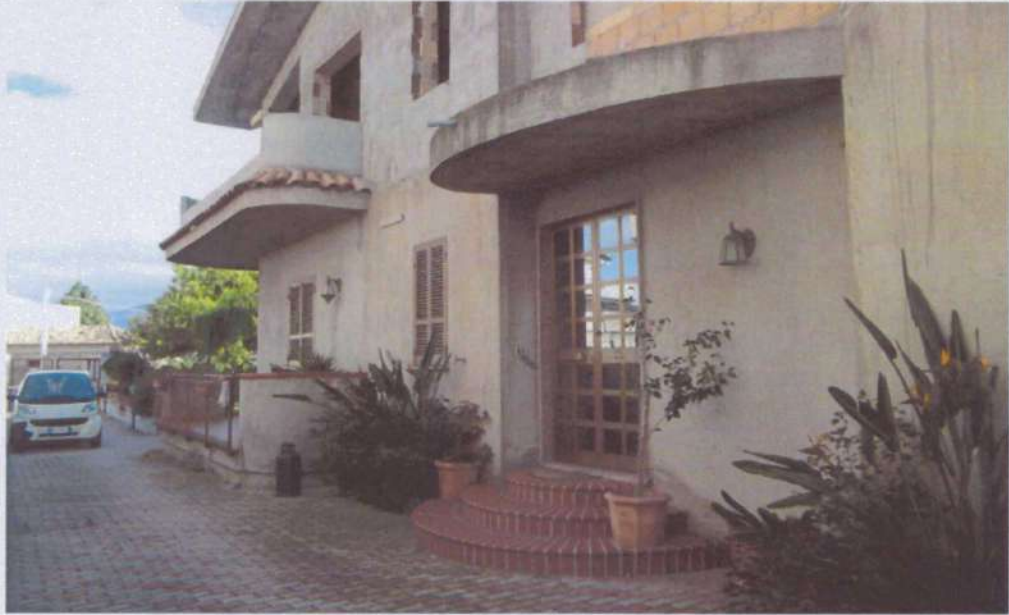
FOTO N°3 INGRESSO PRINCIPALE (LATO NORD)
