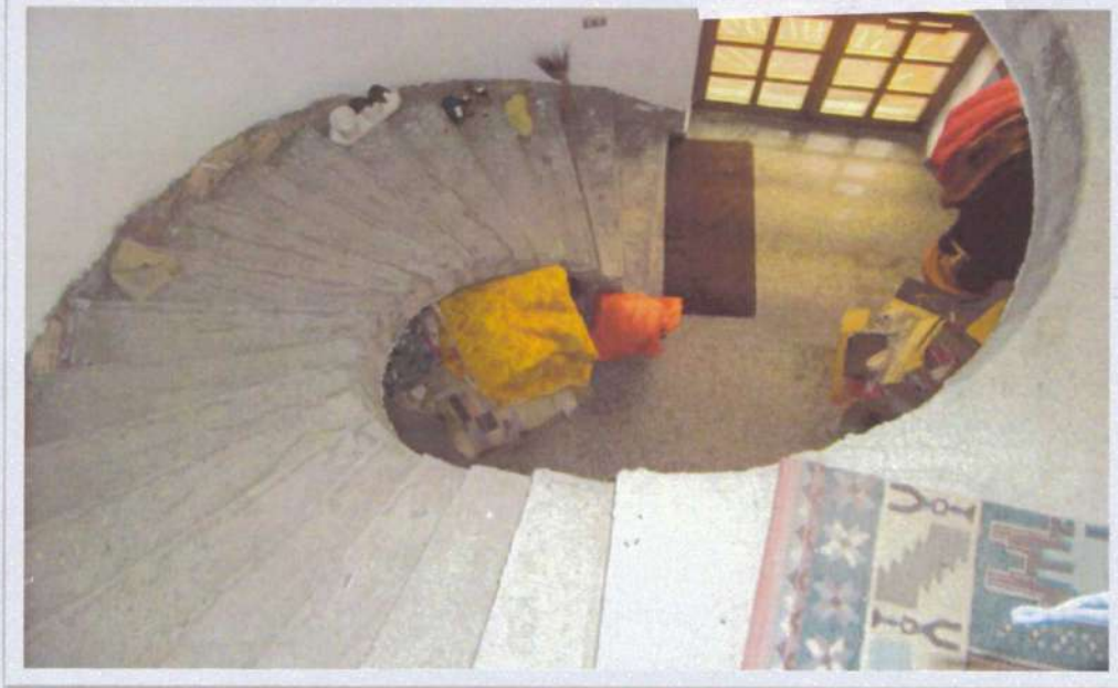
FOTO N°13 VANO SCALA DI ACCESSO AL PRIMO PIANO
