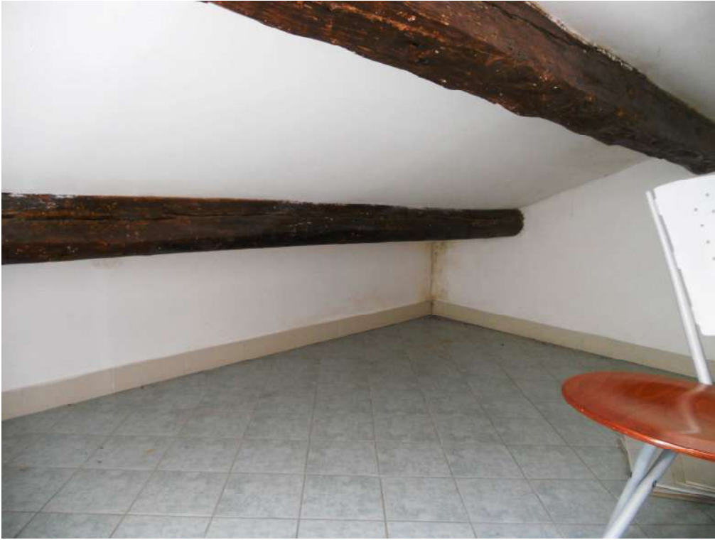
Foto n. 9 – Foto del ripostiglio.
