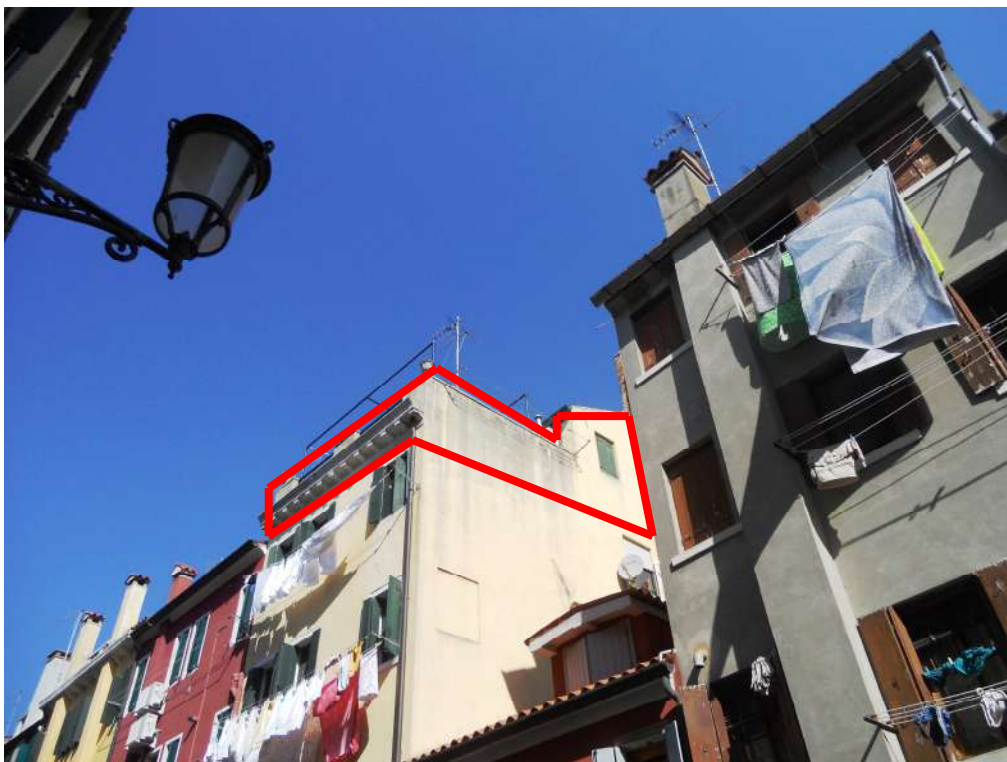
Foto n. 12 – Vista da sud-est.
