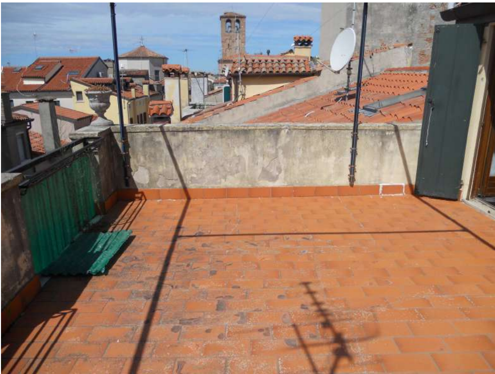
Foto n. 10 – Foto della terrazza.
