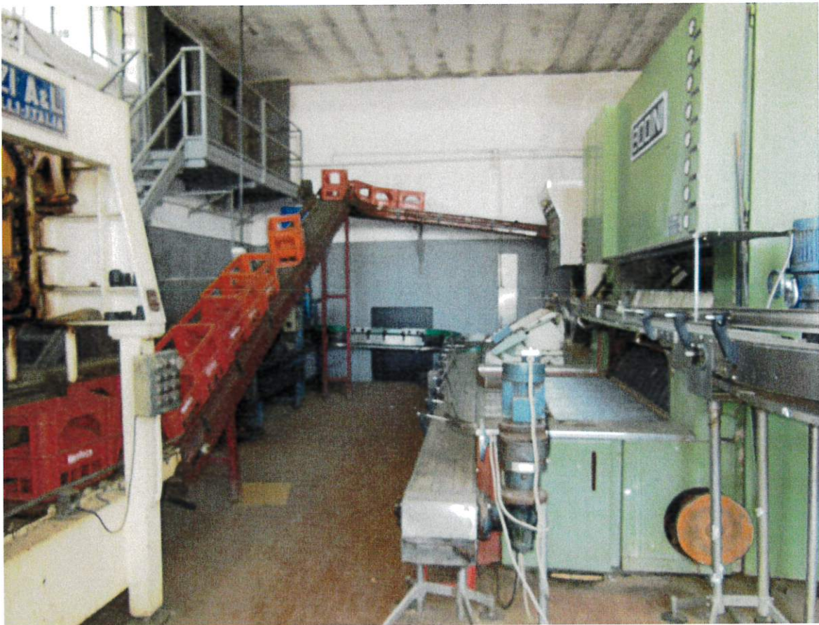
Foto 14: zona lavaggio bottiglie e accesso ai locali tecnici
