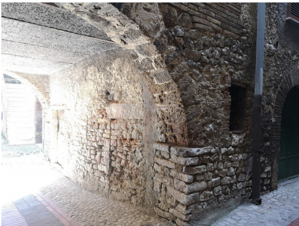
Foto n. 13 - Prospetto magazzino via Degli Archi n. 30
