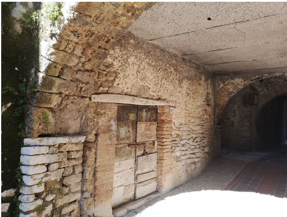
Foto n. 12 - Prospetto magazzino via Degli Archi n. 30
