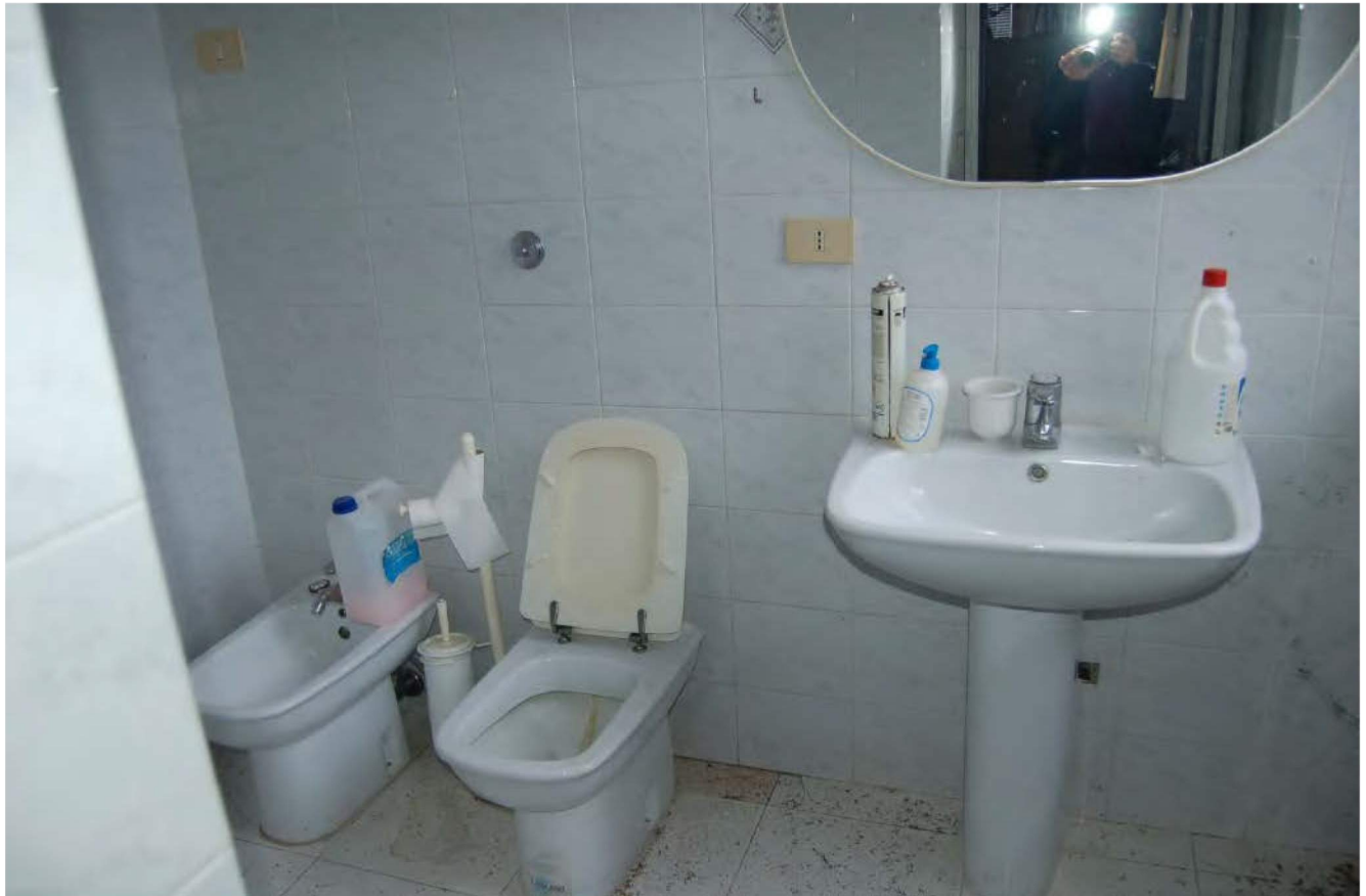
Foto 44 - Vista del bagno ad uso esclusivo dell'ufficio posto al piano primo della zona espositiva A1
