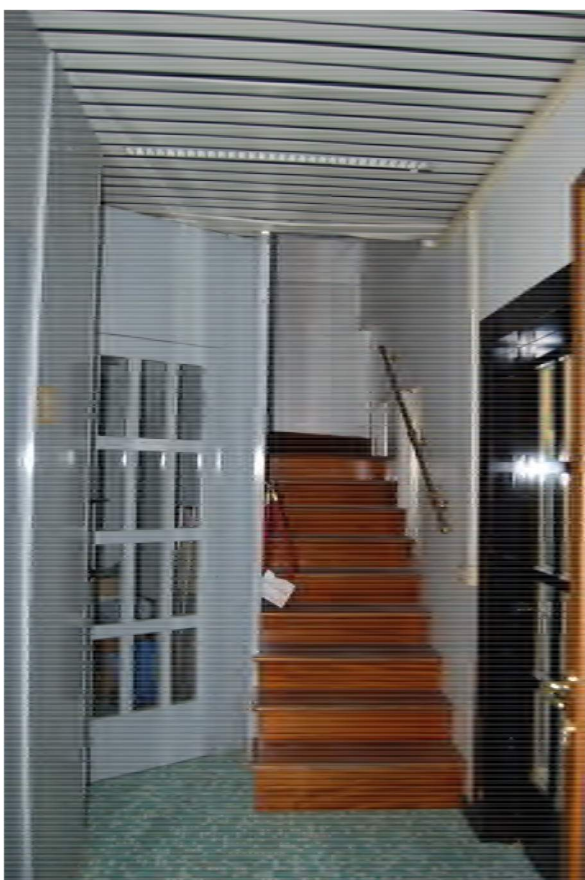
Foto 34 – Vista della scala di collegamento tra il piano terra e gli uffici posti al piano primo
