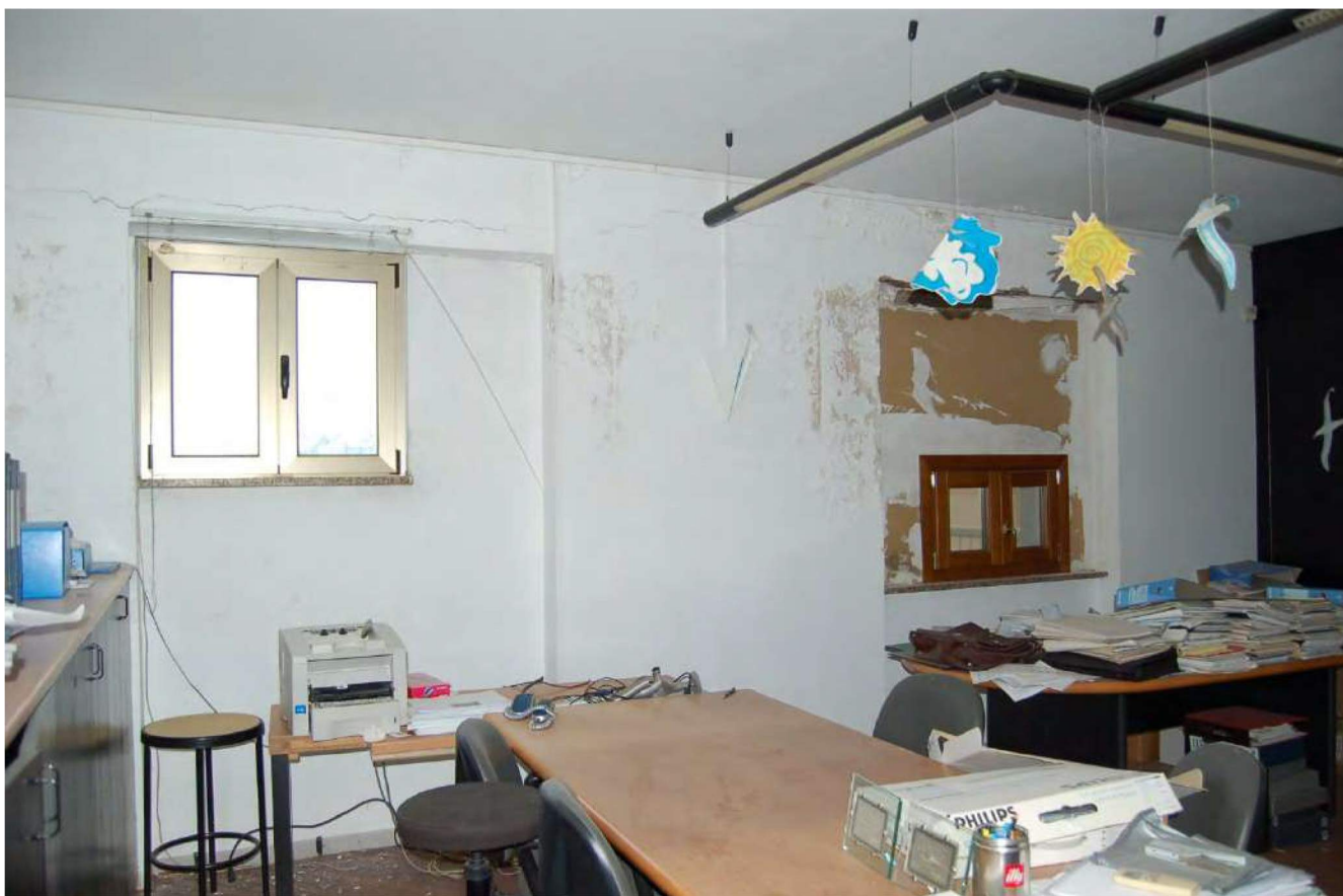
Foto 38 - Vista interna dell'ufficio posto al piano primo della zona espositiva A1
