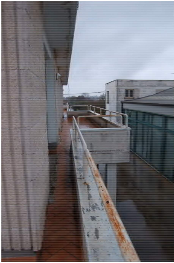
Foto 149- Piano Primo_ percorso di collegamento tra le due terrazze fronte principale
