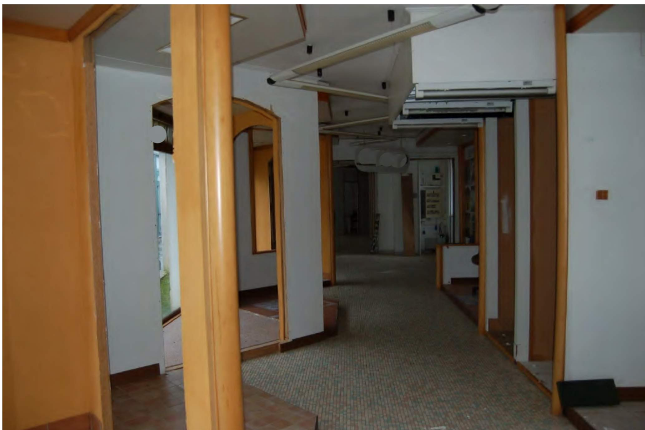
Foto 136 - Piano Terra_Vista della sala mostra
