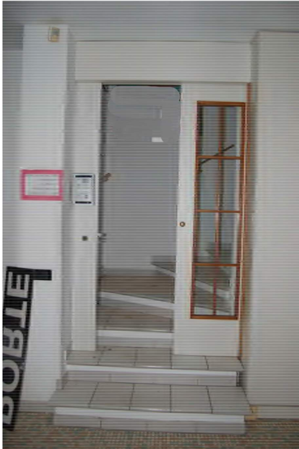
Foto 141- Scala di collegamento primo piano
