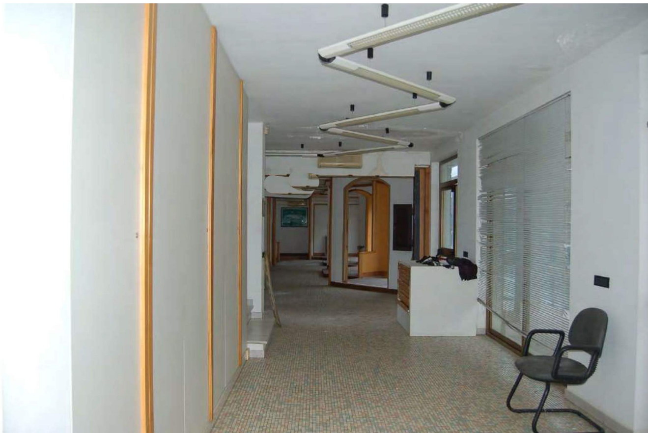
Foto 134 - Piano Terra_Vista dell'ingresso
