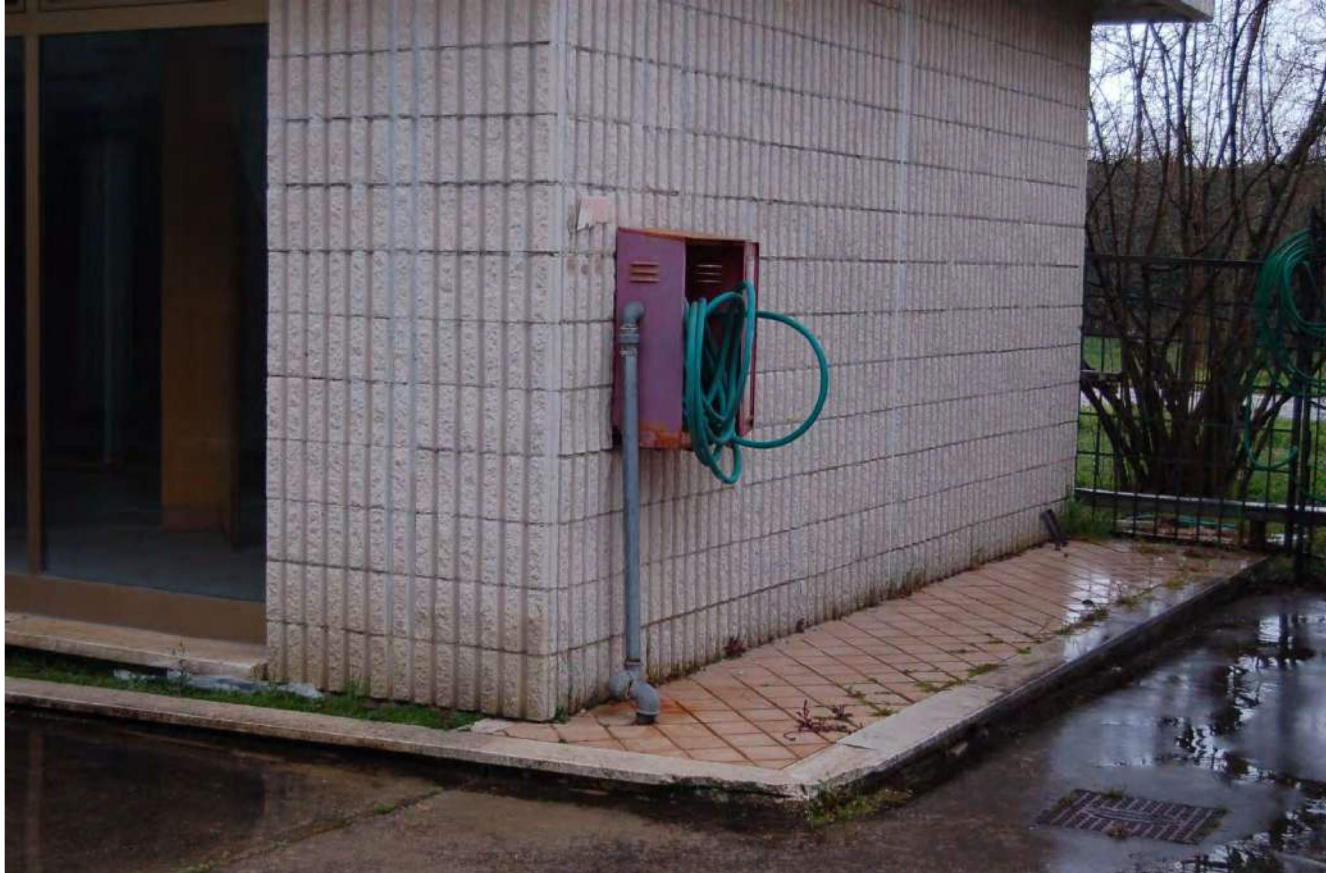
Foto 133 - Prospetto laterale fronte sud
