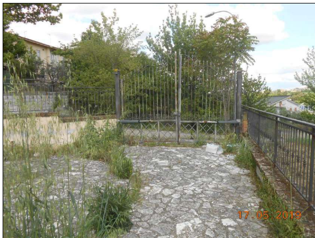
FOTO N. 02 Vista della porzione dell'immobile insistente sulla p.lla 1011, non oggetto di pignoramento.
