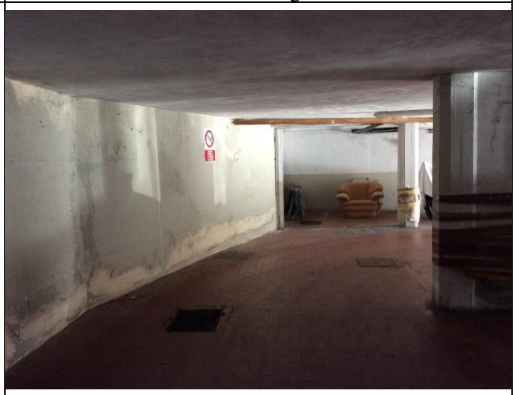
Foto 10: Autorimessa P-1: area di manovra comune
