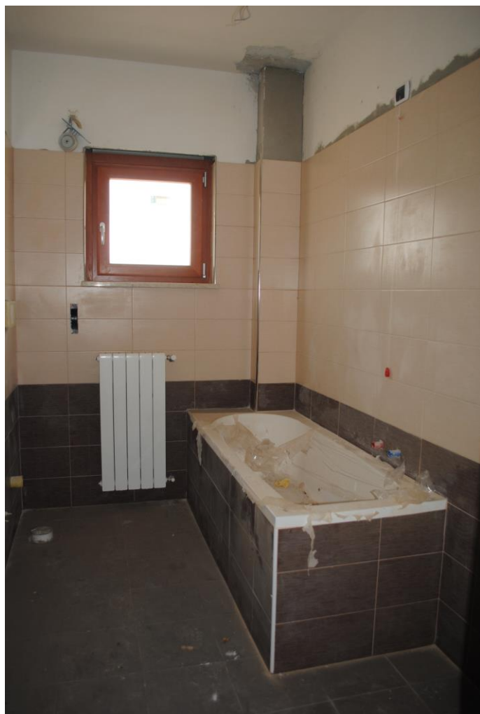
Vista Interna- Alloggio – bagno vasca
