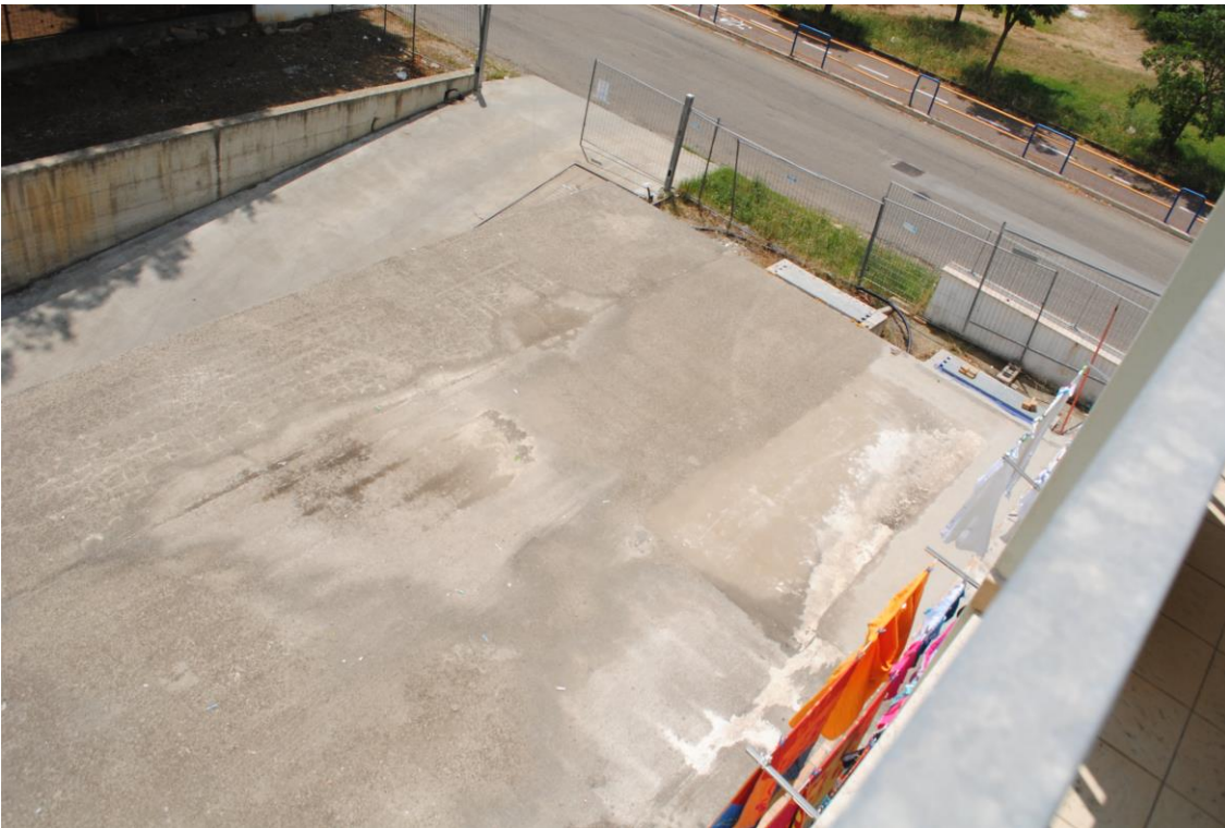
Vista Esterna - Ingresso rampa Box – Via Monreale
