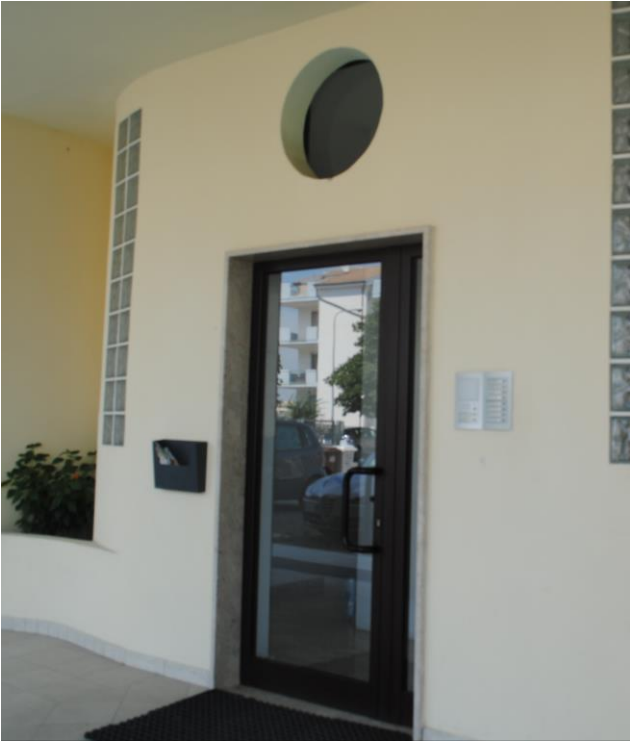
Vista Esterna Portone Ingresso Edificio – Via Togliatti Foto n.3
