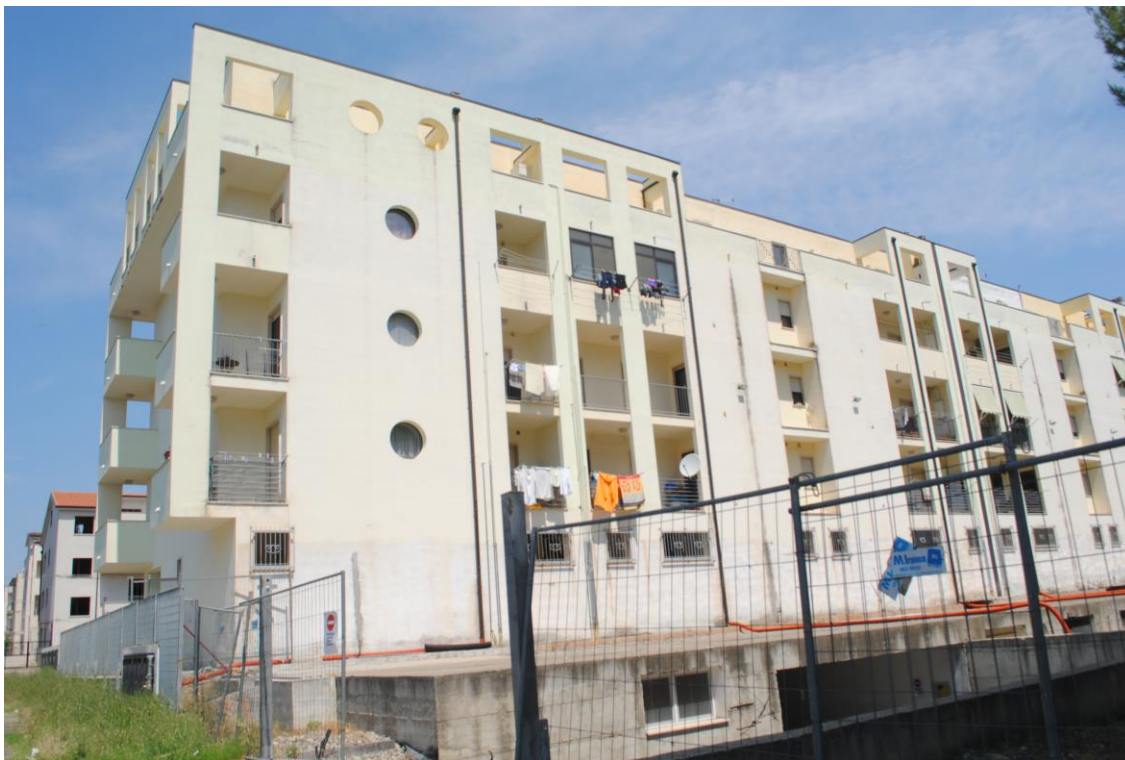
Vista Esterna– Prospetto posteriore – Ingresso rampa box
