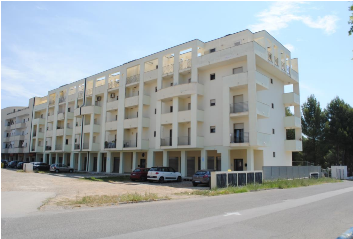
Vista Esterna – Via Togliatti angolo Via Monreale
