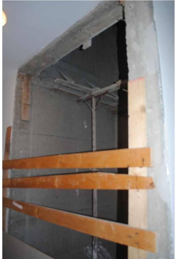
Vista Interna Portone –Vano ascensore –Foto n.4
