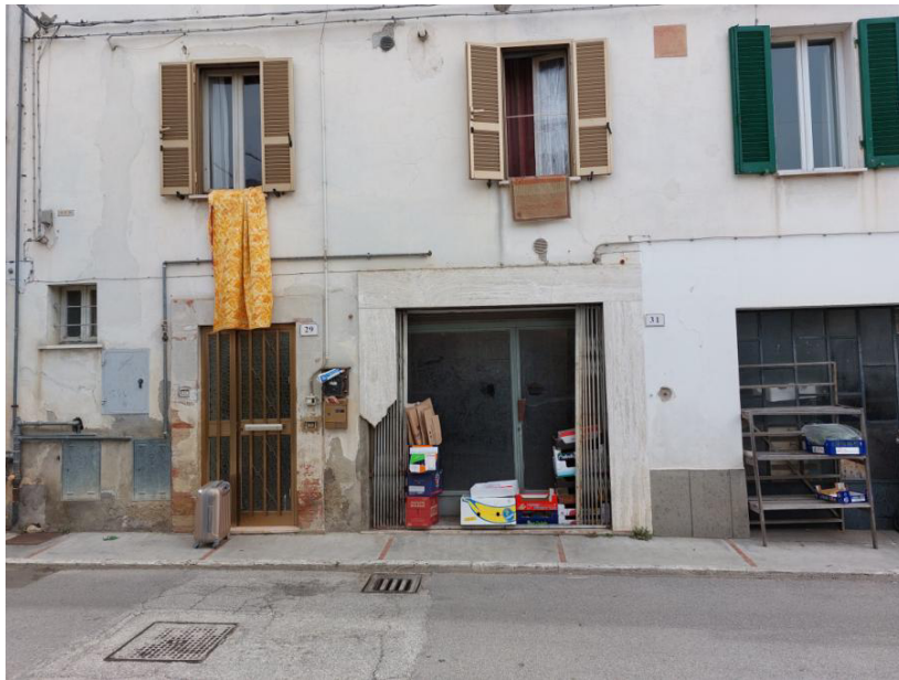
Foto n.41: Particolare del magazzino al piano terra (BENE H). Nella foto sono visibili, il prospetto principale ovest del fabbricato, la porta vetrata con infissi in metallo e il cancello estensibile in metallo (civico 31).
