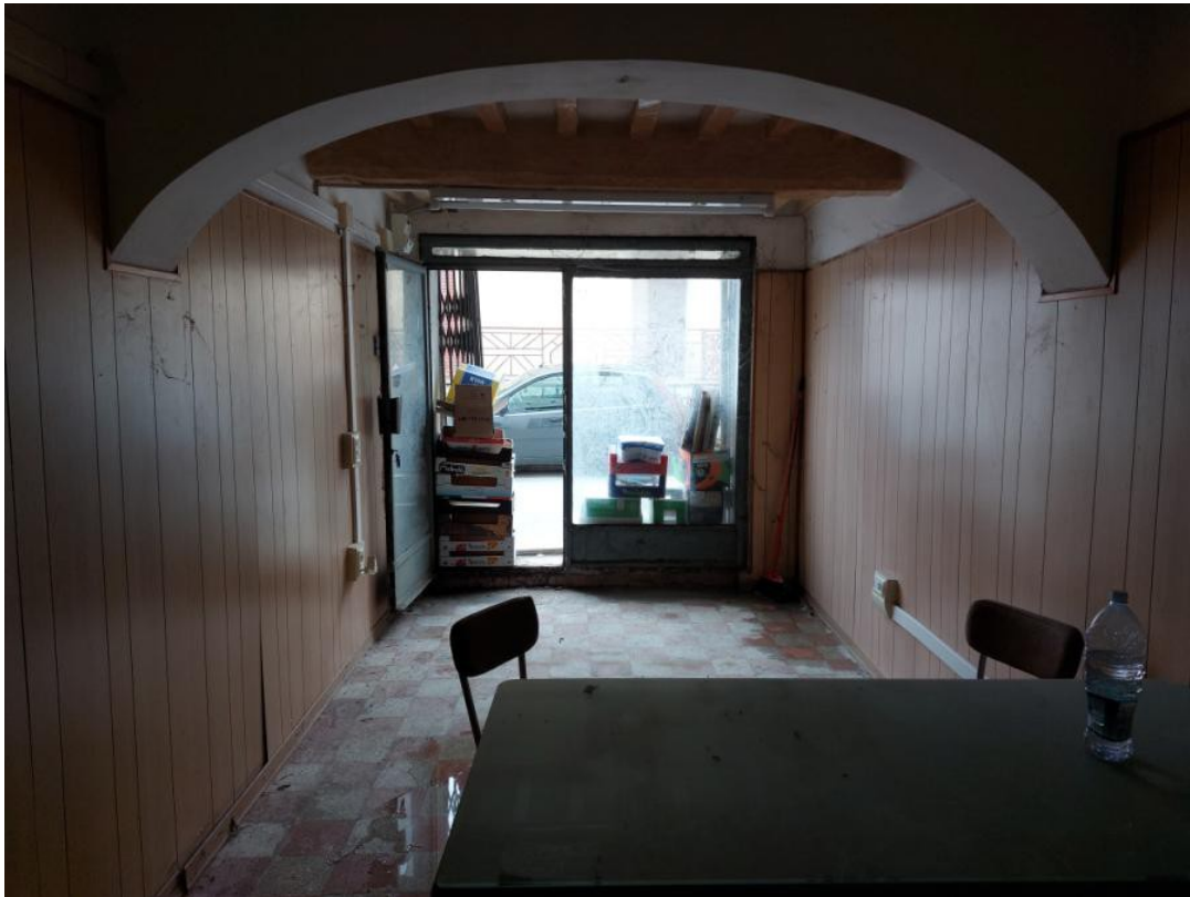
Foto 43. Altro particolare del magazzino al piano terra (Bene H) ripreso da angolazione opposta rispetto alla immagine precedente. Notare i pavimenti realizzati con piastrelle in monocottura, le pareti in parte rivestite da perline in legno e parte tinteggiate e intonacate.
