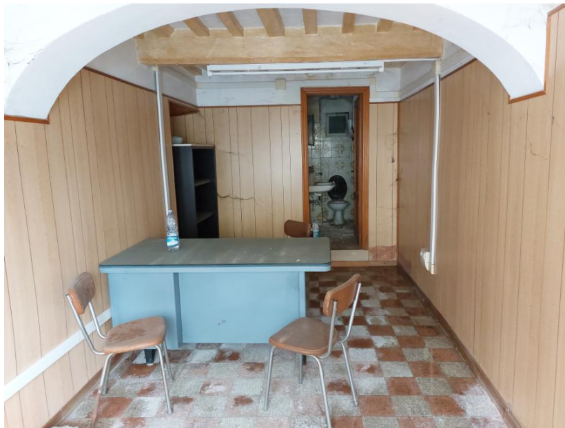
Foto n.42: Particolare interno del magazzino al piano terra (BENE H). Sono visibili i solai con orditura in legno lamellare e l'impianto elettrico del tipo fuori traccia protetto da canaline per cavi. Notare sullo sfondo l'apertura di accesso al w.c..
