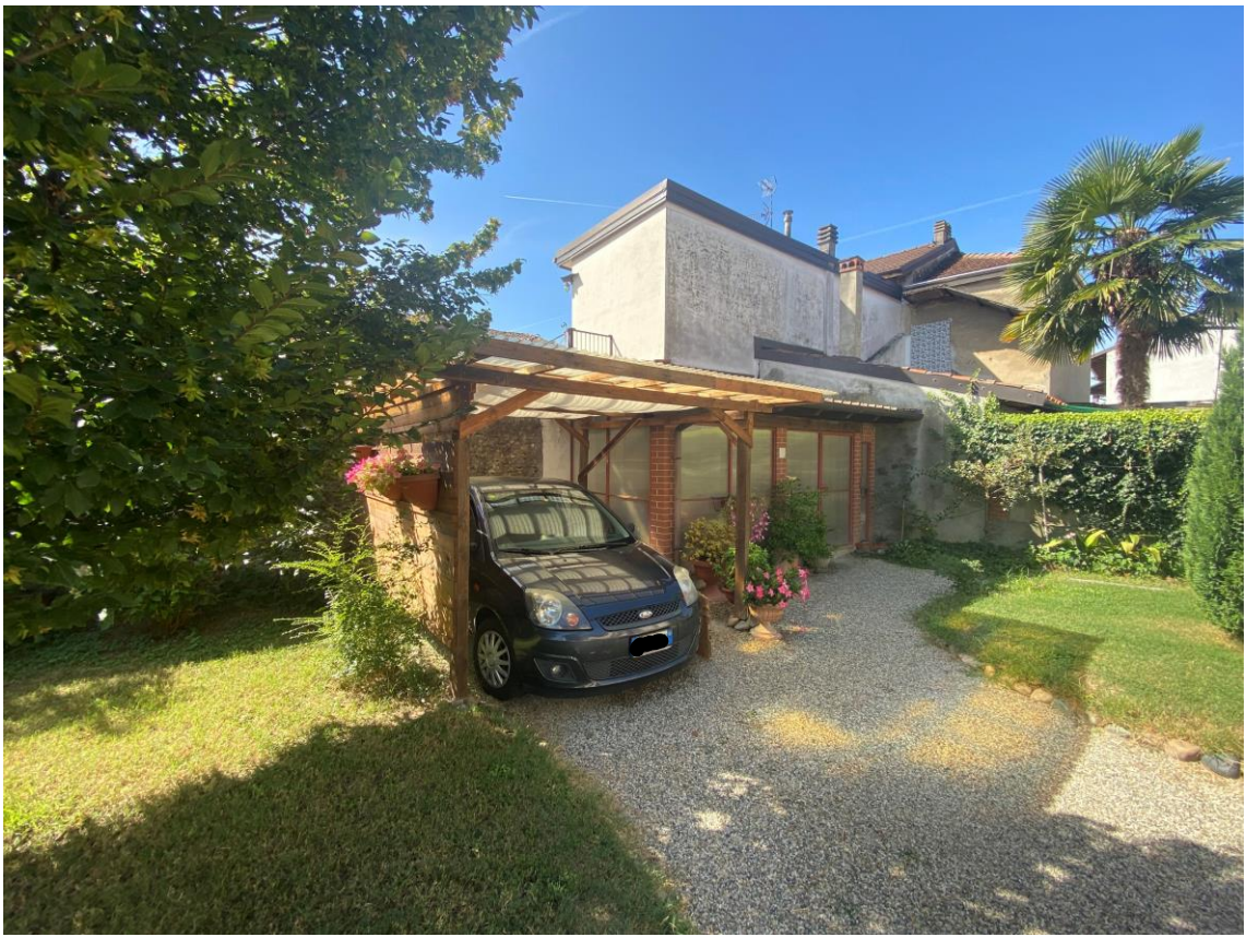
FOTO 19 : VISTA ESTERNA PORTICATO E TETTOIA
