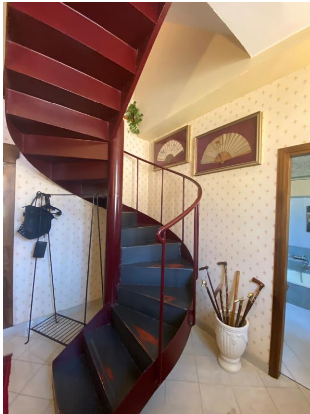
FOTO 8 : VISTA INTERNA VANO SCALA PIANO TERRENO
