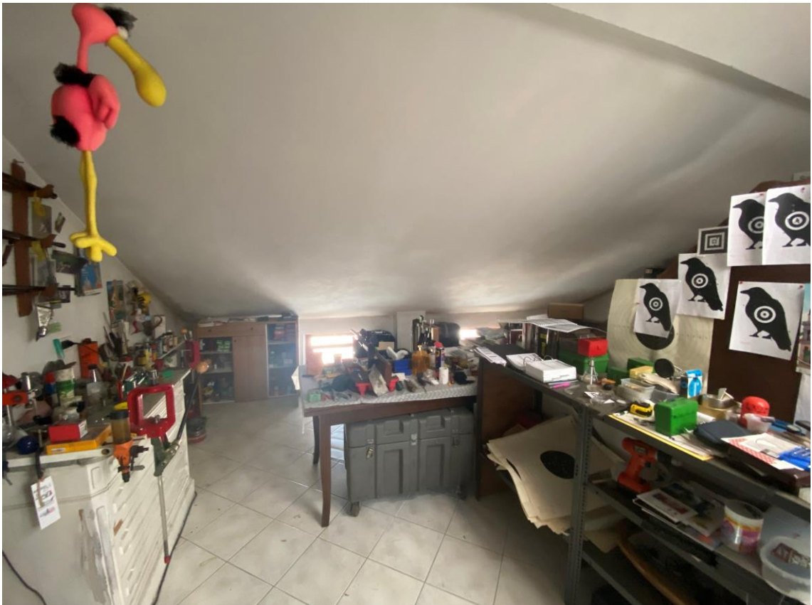
FOTO 14 : VISTA INTERNA SOTTOTETTO PIANO SECONDO
