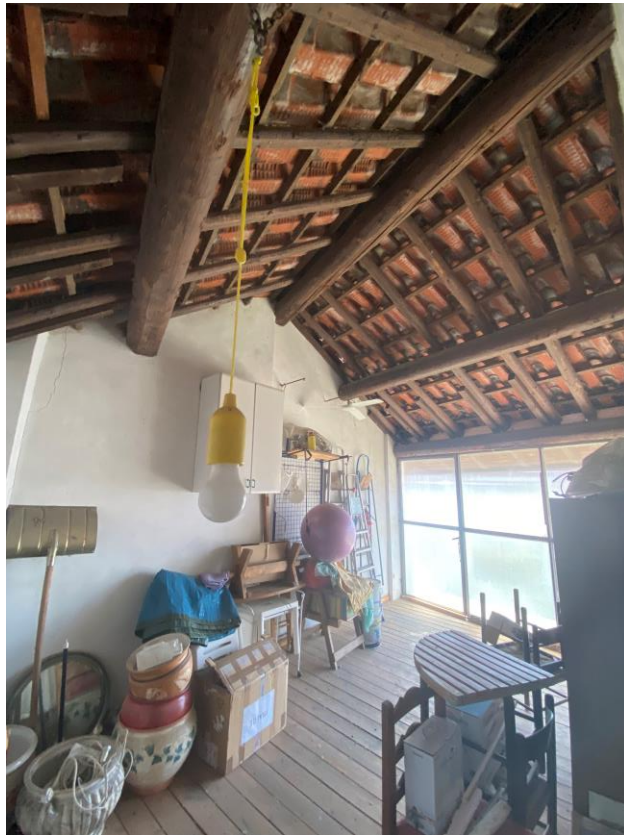
FOTO 13 : VISTA INTERNA LOCALE DI SGOMBERO PIANO PRIMO
