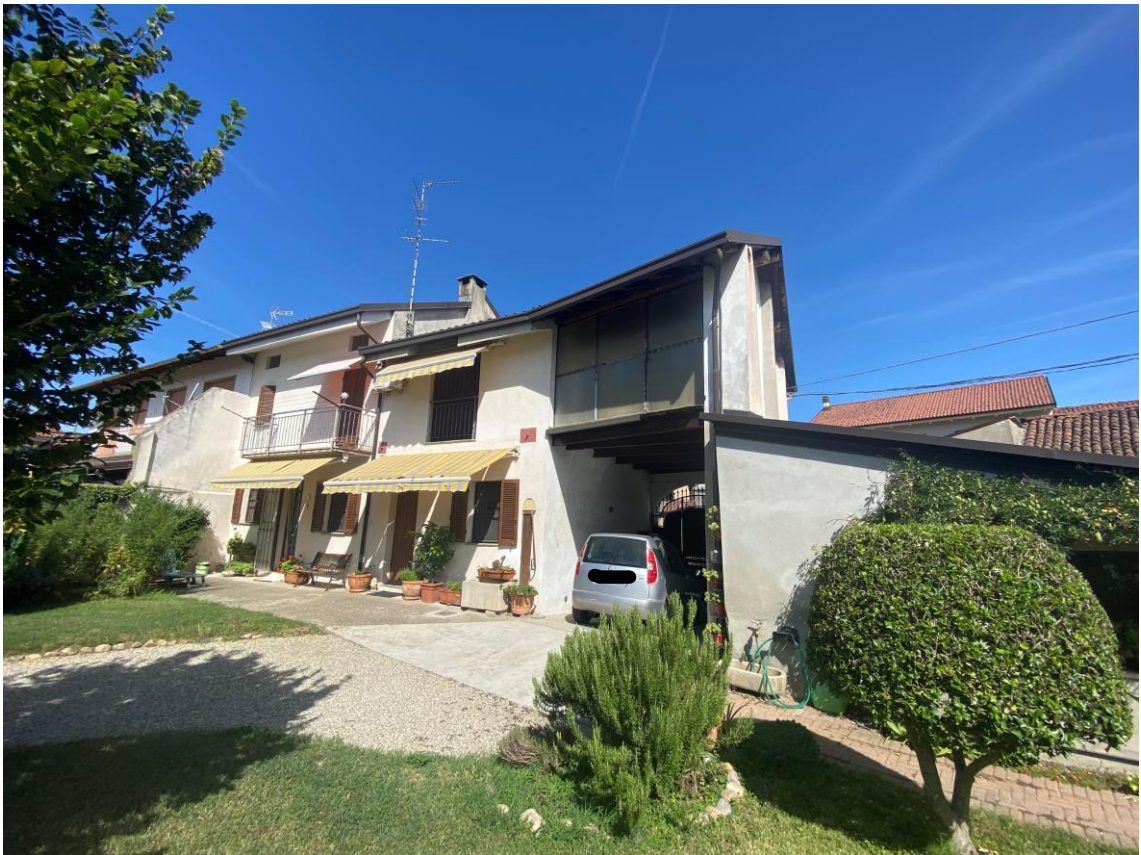
FOTO 21 : VISTA ESTERNA DELL'ABITAZIONE LATO CORTILE
