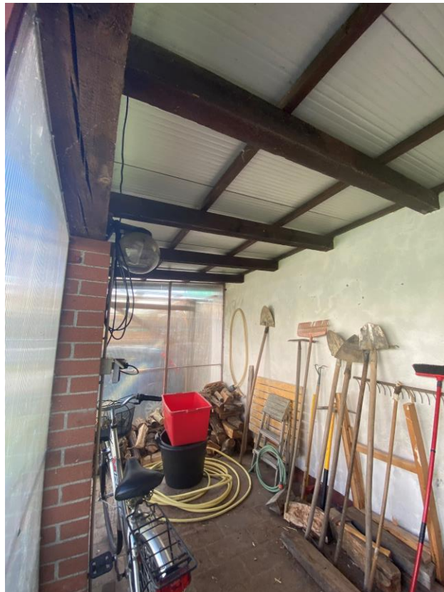
FOTO 18 : VISTA INTERNA PORTICATO PIANO TERRENO
