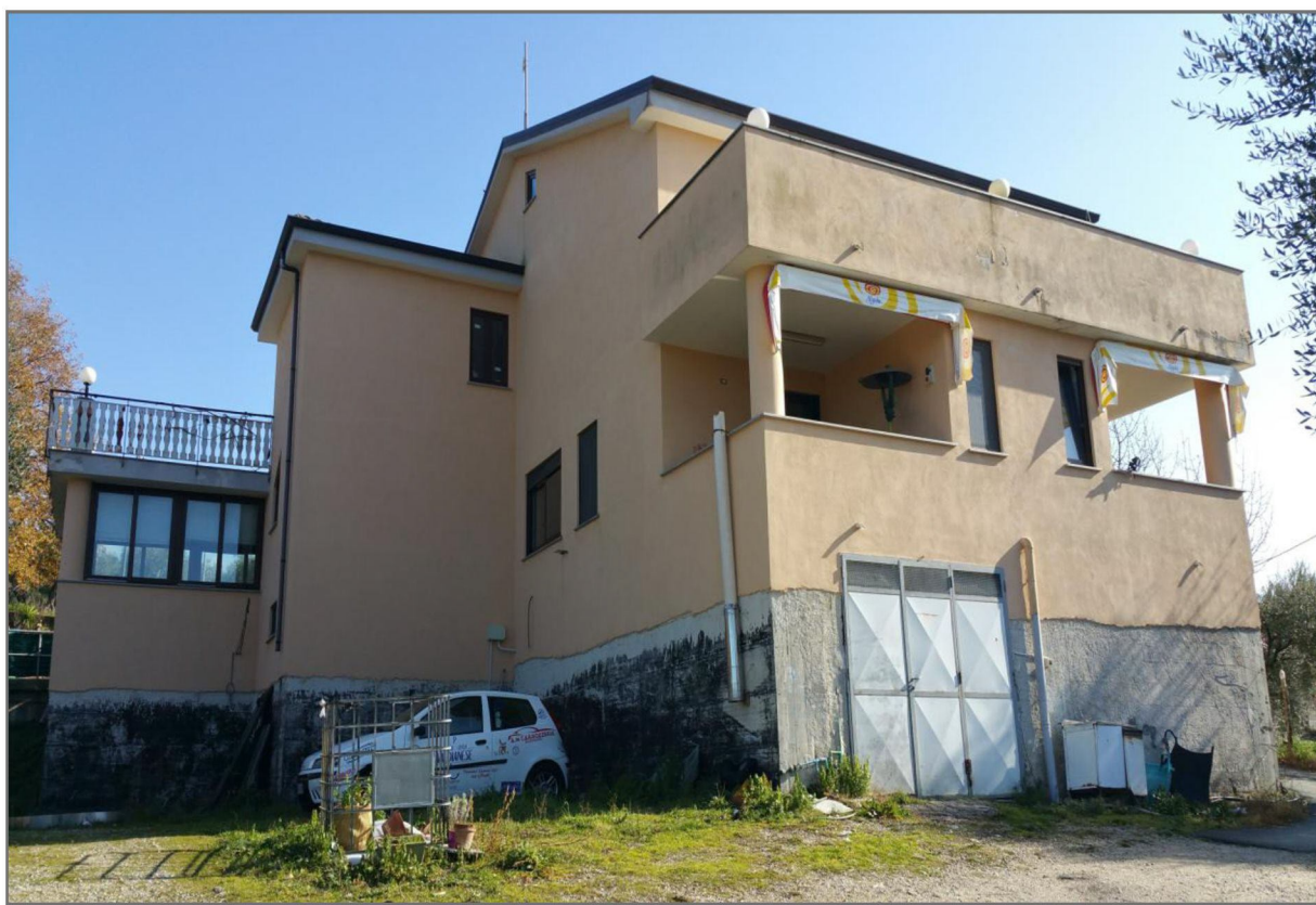
Veduta immobile della facciata lato sud-ovest dalla Via Massavetere
