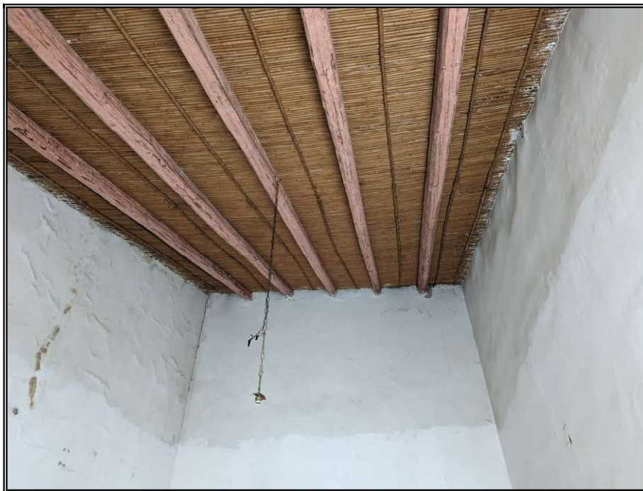
Foto n° 4 – Particolare soffitto vano 1
