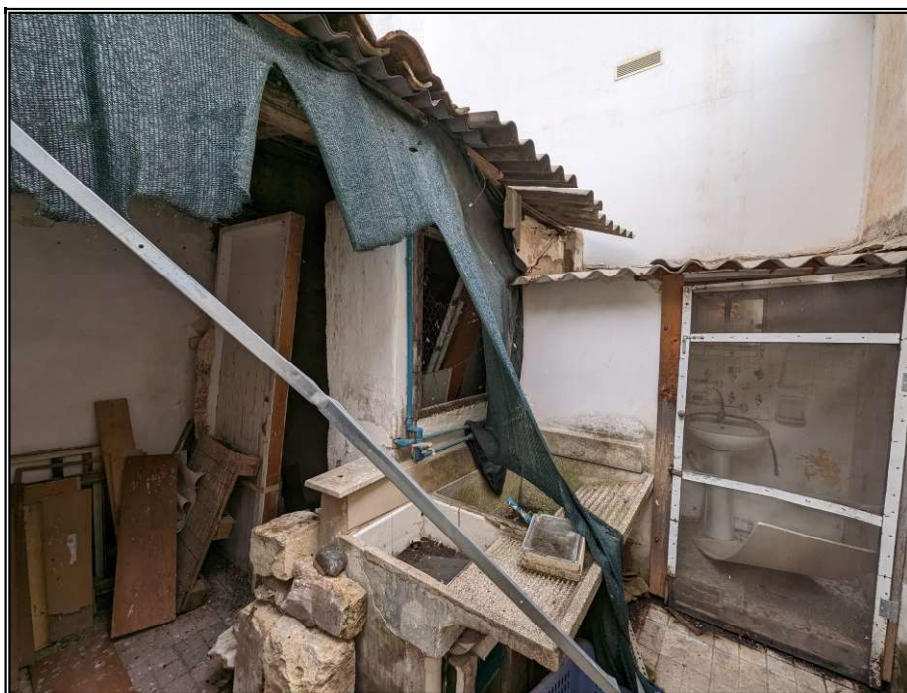
Foto n° 13 – Esterno ripostiglio, tettoia e w.c.
