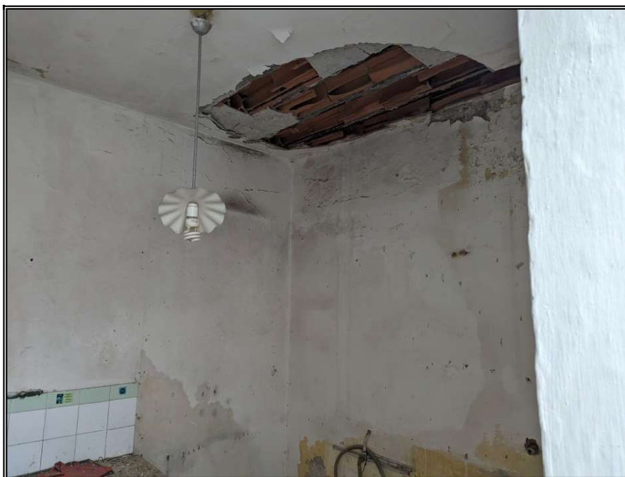
Foto n° 11 - Particolare soffitto locale forno
