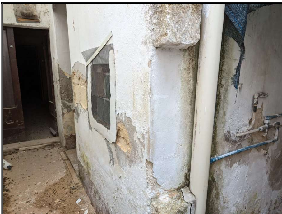
Foto n° 9 – Prospetto locale forno
