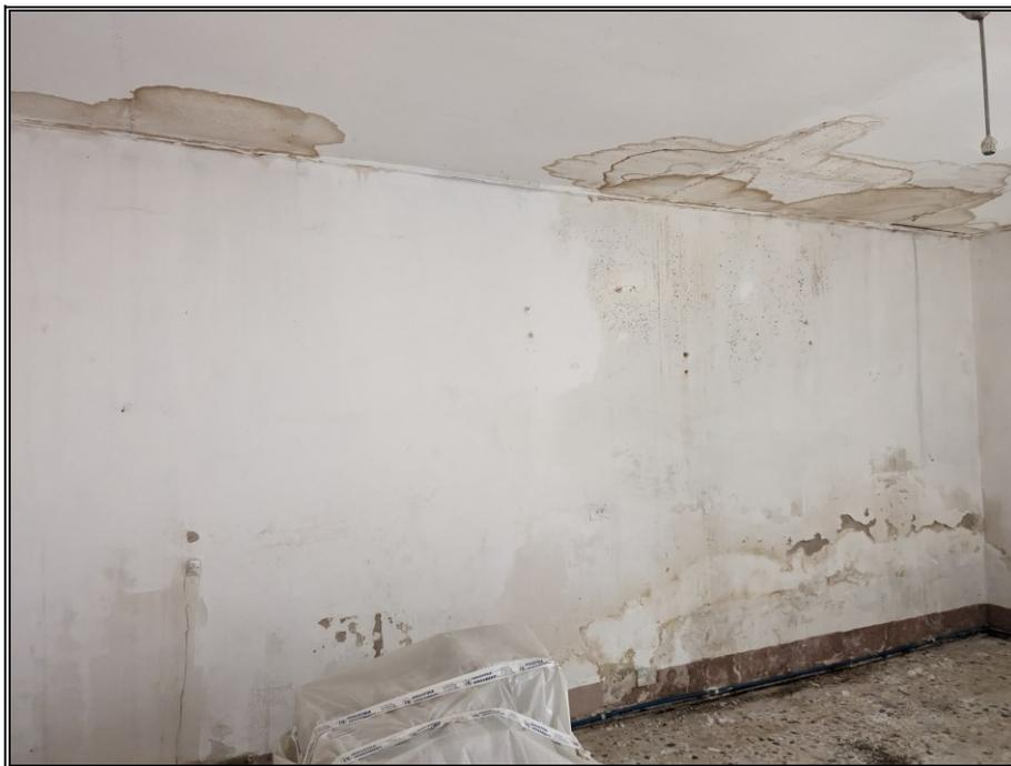
Foto n° 8 – Particolare infiltrazione d'acqua nel controsoffitto e umidità nella parete
