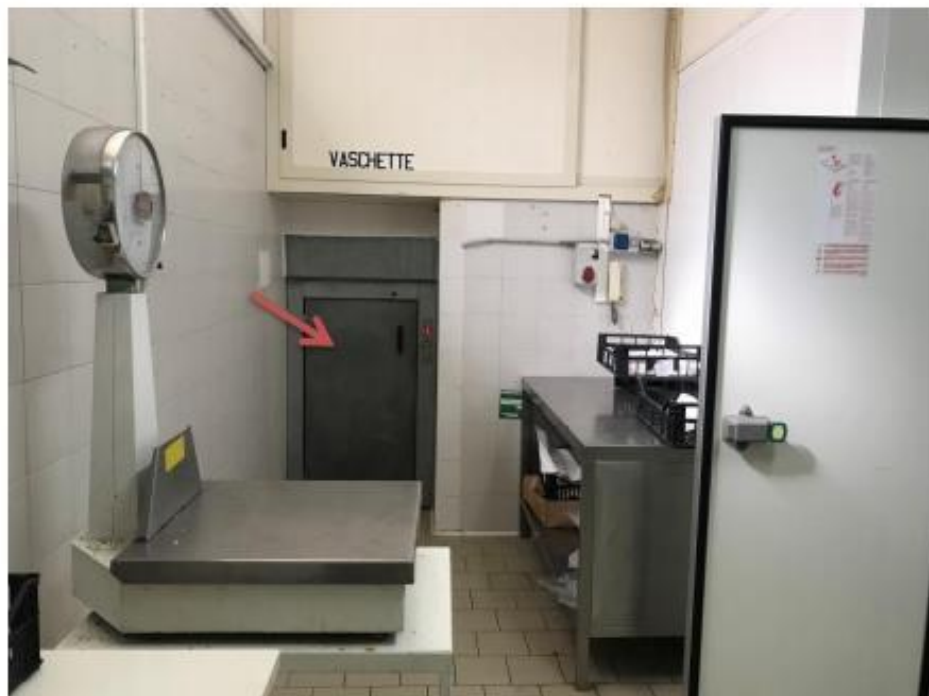
Vano 5 – Si evidenzia il montacarichi
