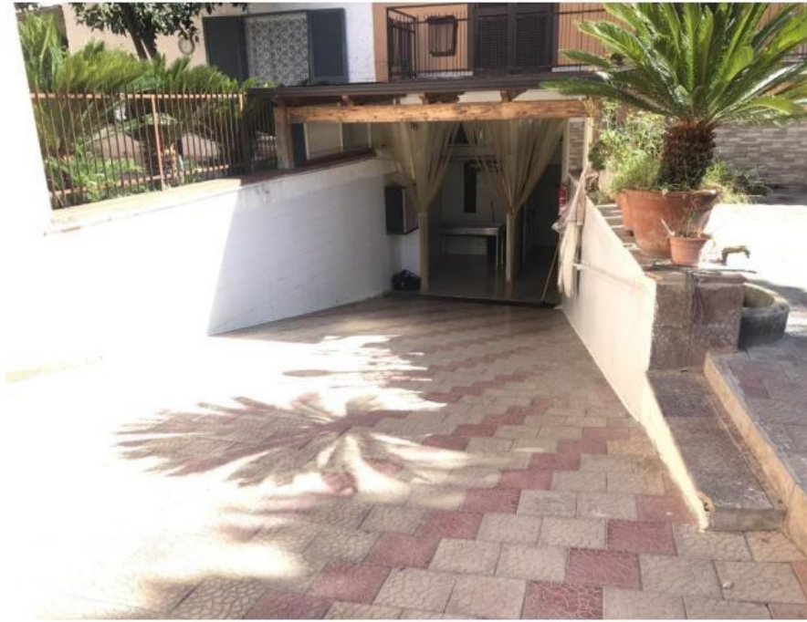
Rampa d'accesso al laboratorio
