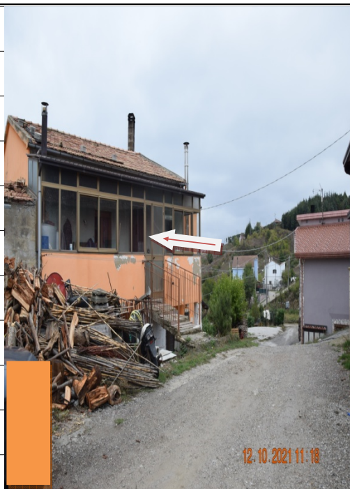
Foto Prospetto Principale Piano 1° Sub 4
