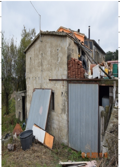
Foto Prospetto Principale " PT. Sub 3"
