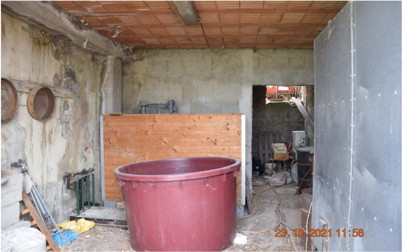
Foto interna – Magazzino Sub 3 “ Parte 1”
