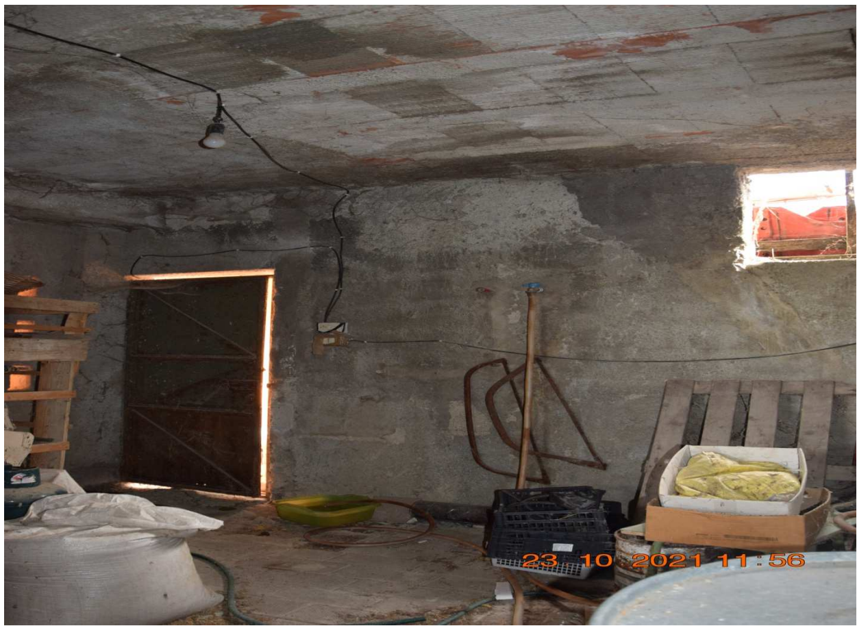
Foto interna – Magazzino Sub 3 “ Parte 2”
