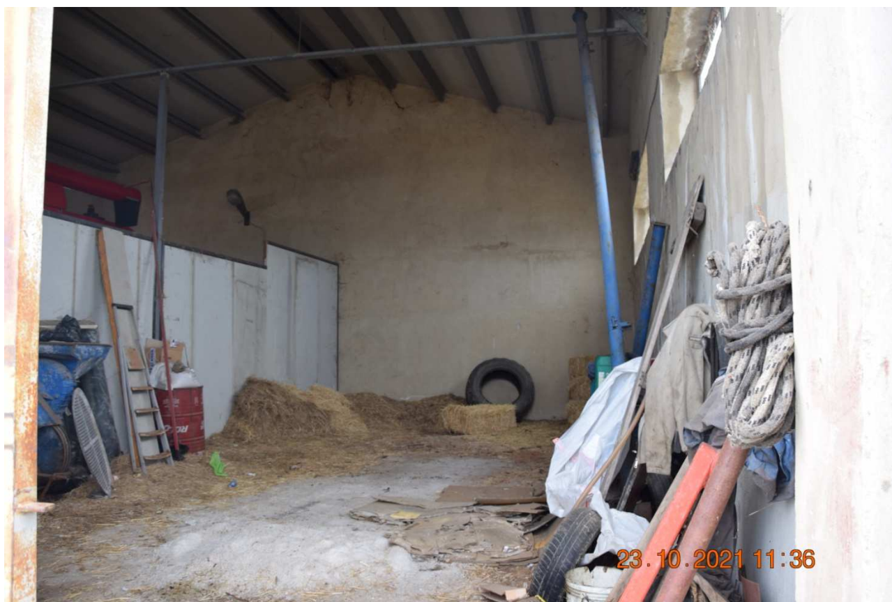
Foto interna – Deposito Sub 2
