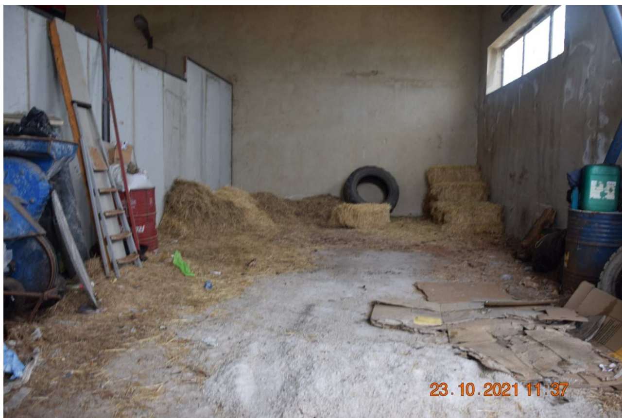
Foto interna – Deposito Sub 2
