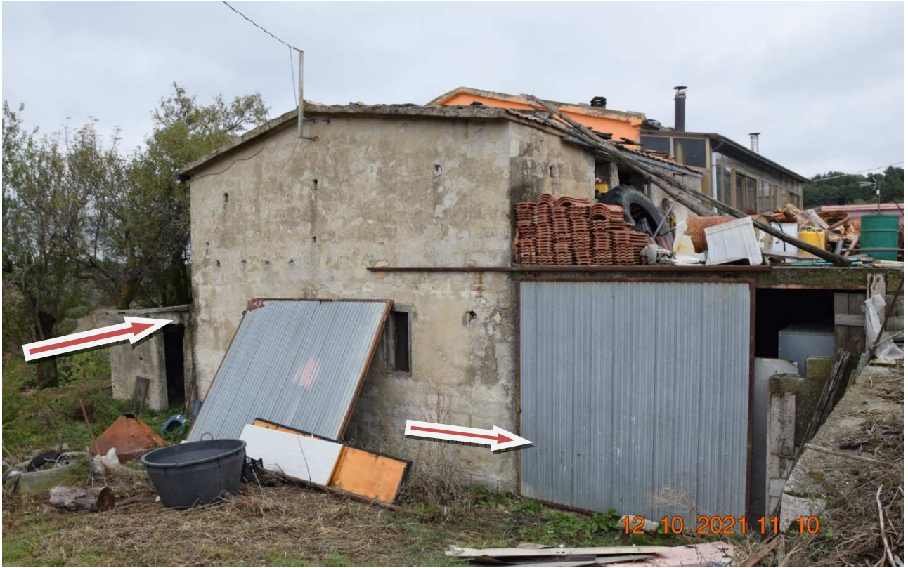
Prospetto Principale Fabbricato U.I.U. sub 3 "Civico sn"
