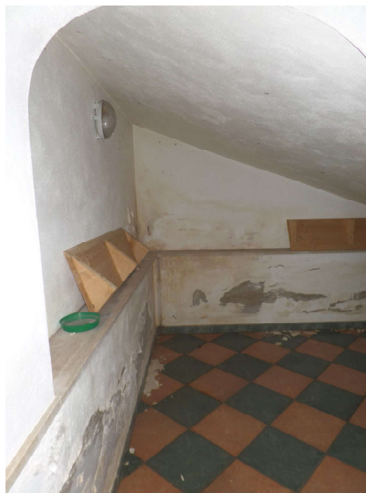
Foto n° 6. Piano Seminterrato: sottorampa
