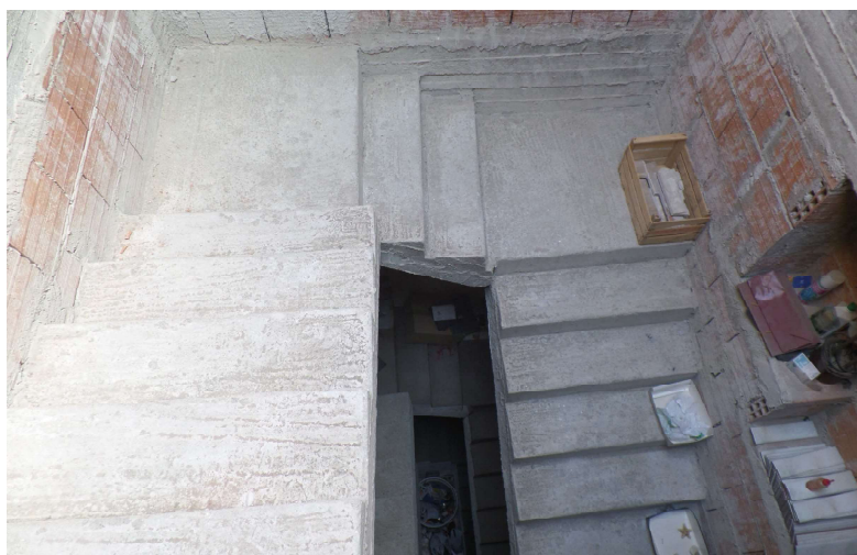
Foto n° 21. Piano 2°: Vano scala
