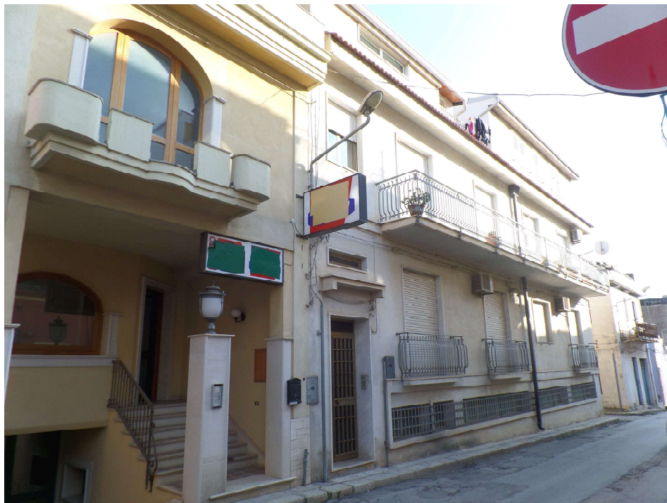
Foto n° 23. Rosolini: Prospetto Via Dante Alighieri
