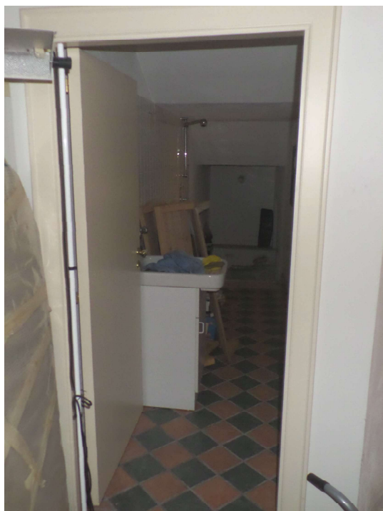
Foto n° 5. Piano Seminterrato: Lavanderia
