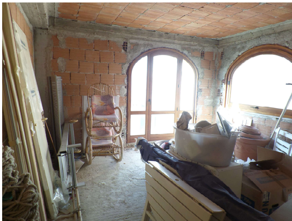
Foto n° 16. Piano 1°: Vano 4/Soggiorno/Pranzo
