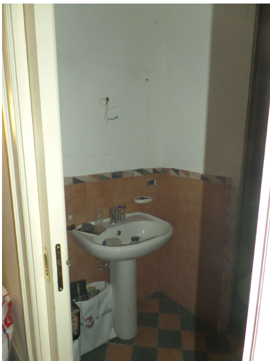
Foto n° 10. Piano Rialzato: Antibagno
