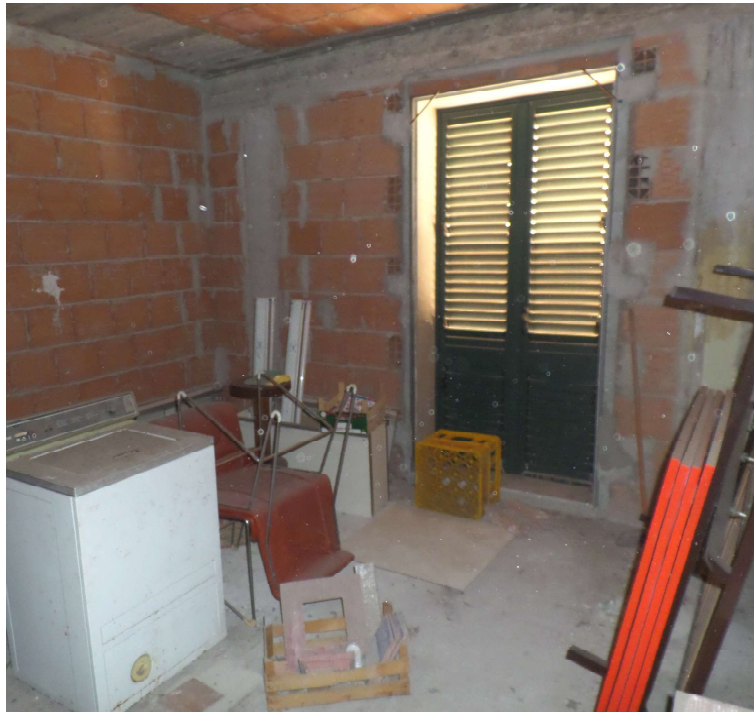
Foto n° 13. Piano 1°: Vano 3/Cucina
