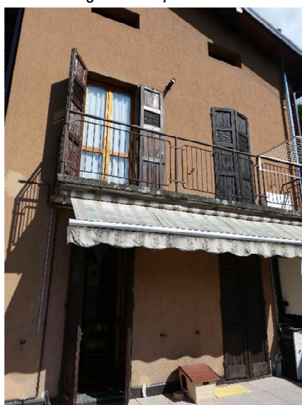
Fronte sul terrazzo (sud-est)
