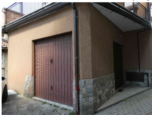
Ingresso deposito PT
