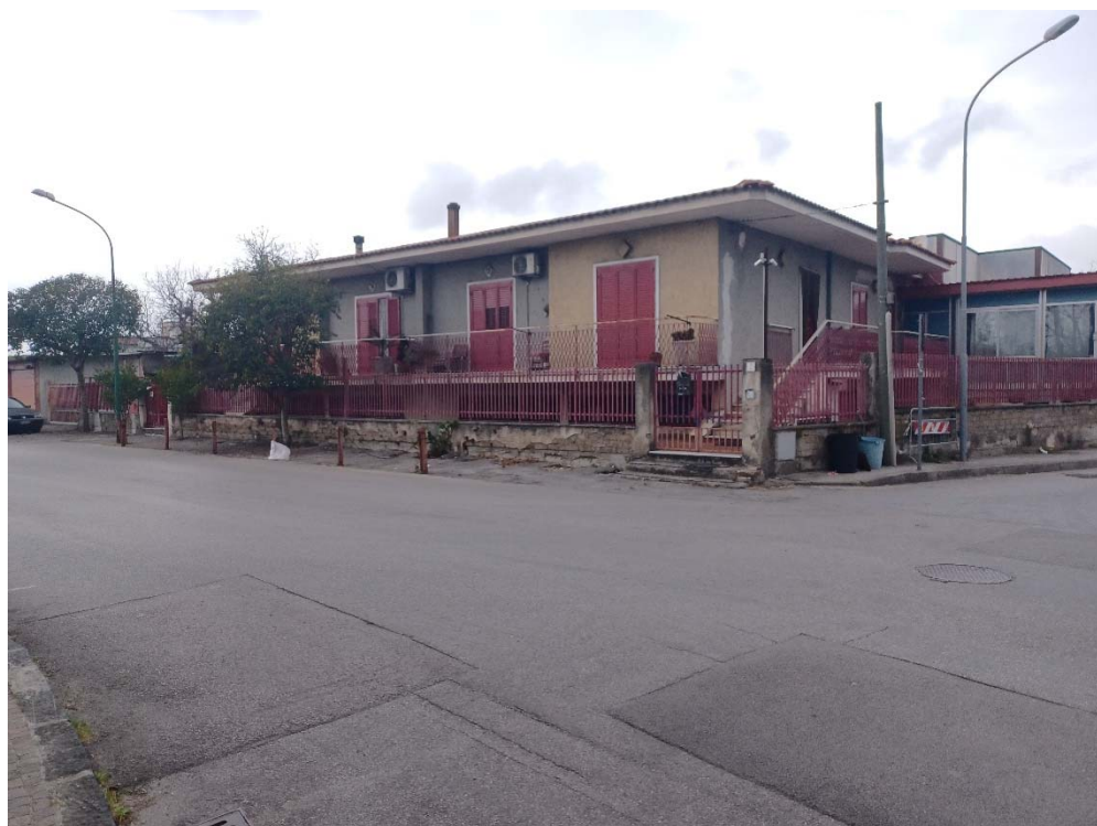
FOTO N°2: vista prospettica angolo via Miccoli-Via Palatone
