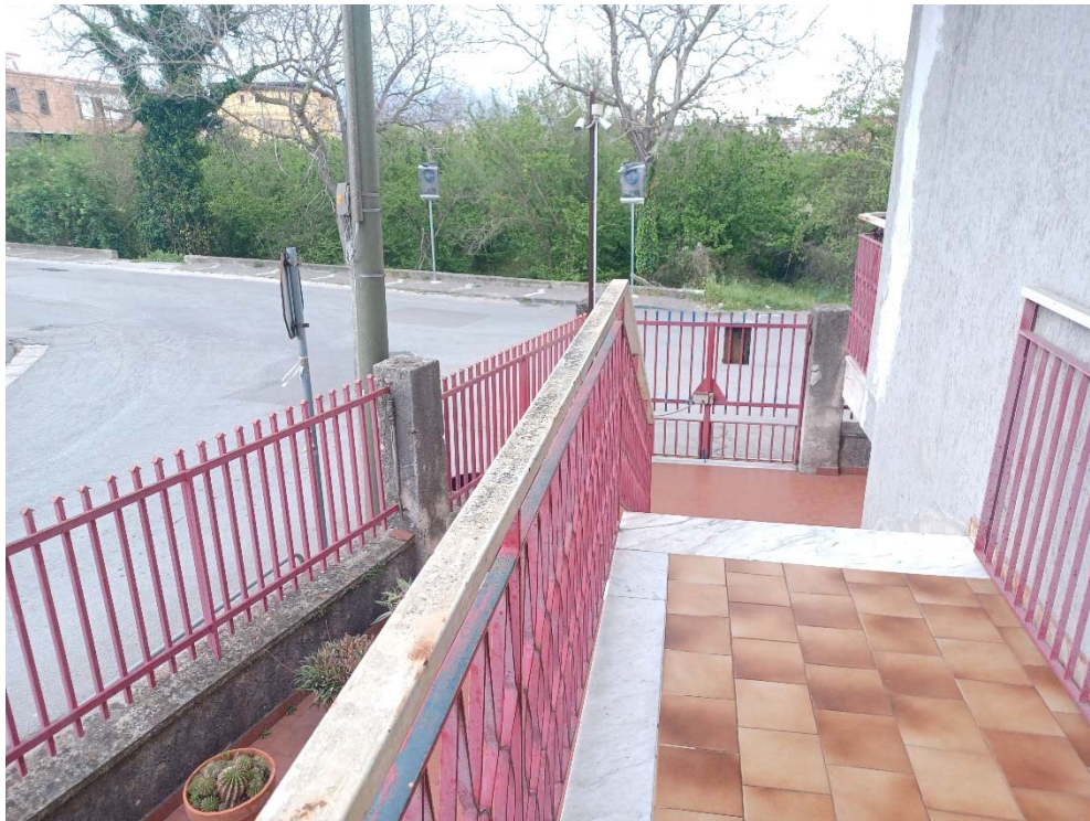
FOTO N°10: ballatoio di accesso
