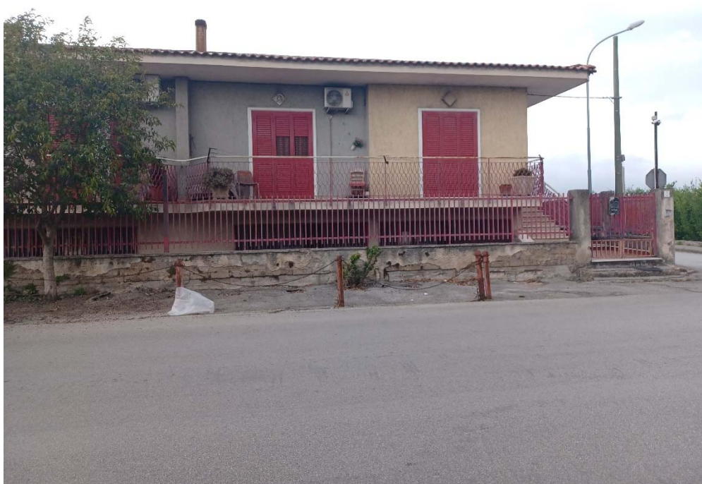
FOTO N°1: prospetto principale da via Miccoli
