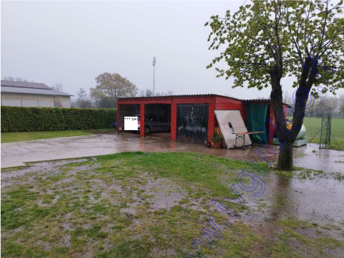
Particolare vista prospettica fabbricato accessorio alla villa
