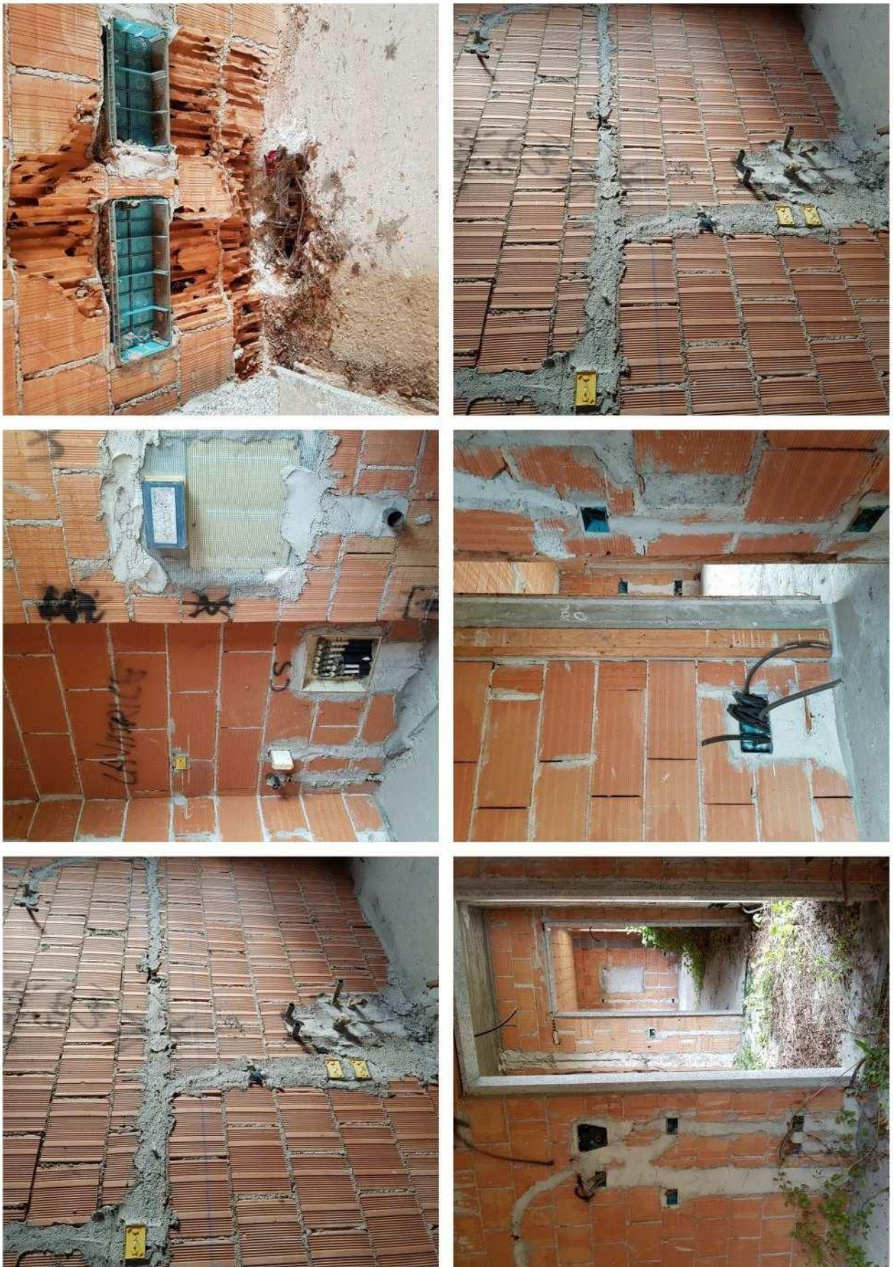
Particolari dello stato di avanzamento opere al grezzo (avanzamento al 48,50%)
