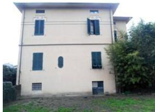
veduta del retro (lato sud ovest) del fabbricato 621
