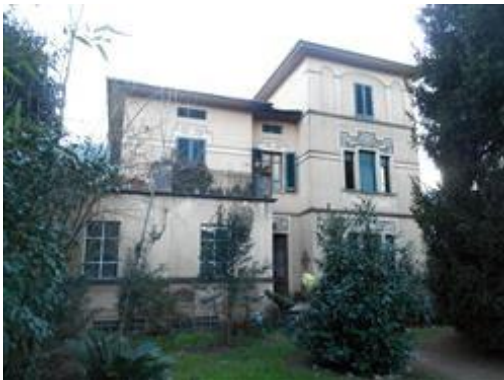
veduta della facciata principale (lato nord est) del fabbricato 621
