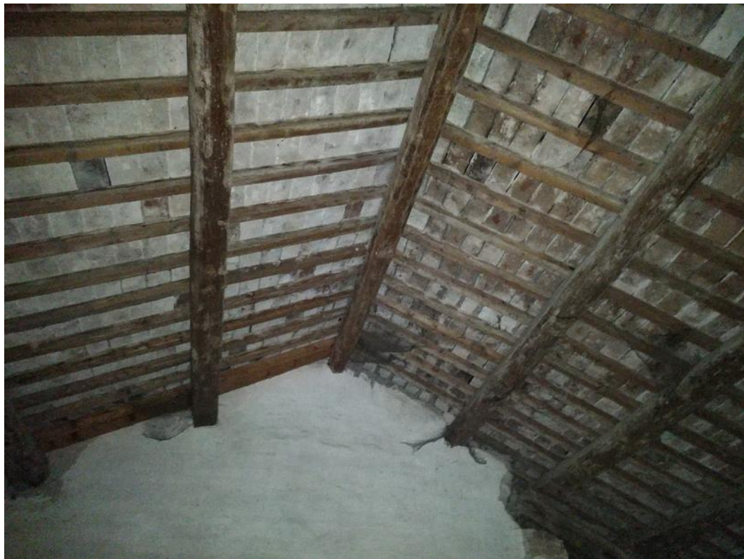
Foto 27 Particolare della struttura di copertura.
