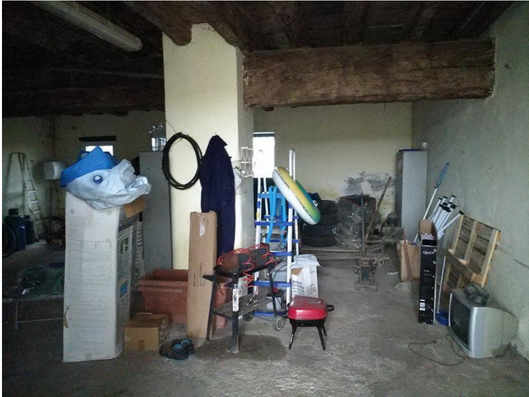
Foto 21 Vista del magazzino a piano terra.
