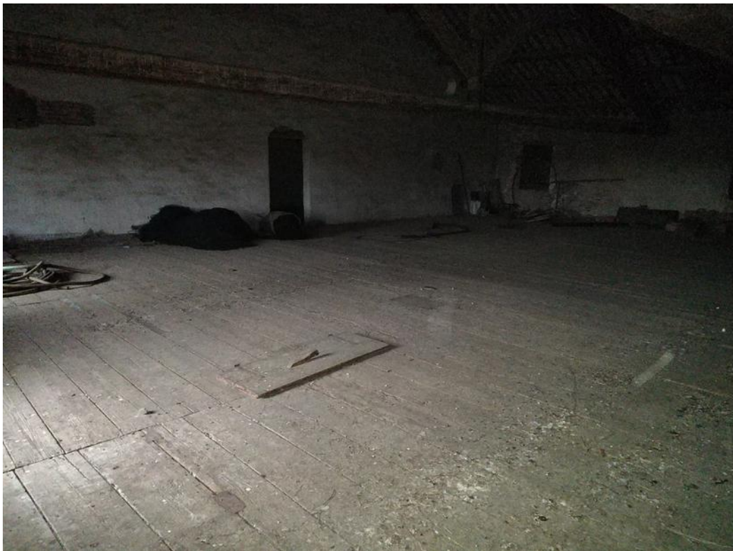
Foto 26 Scorcio del granaio nel sottotetto.
