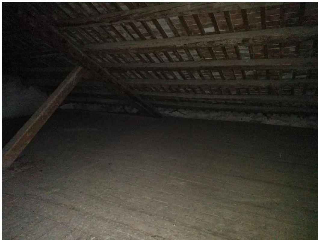
Foto 28 Particolare della struttura di copertura.
