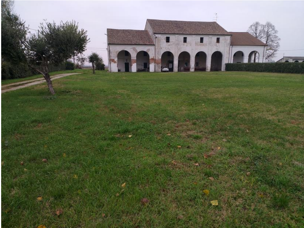
Foto 3 Vista dell'edificio e del terreno di pertinenza.
