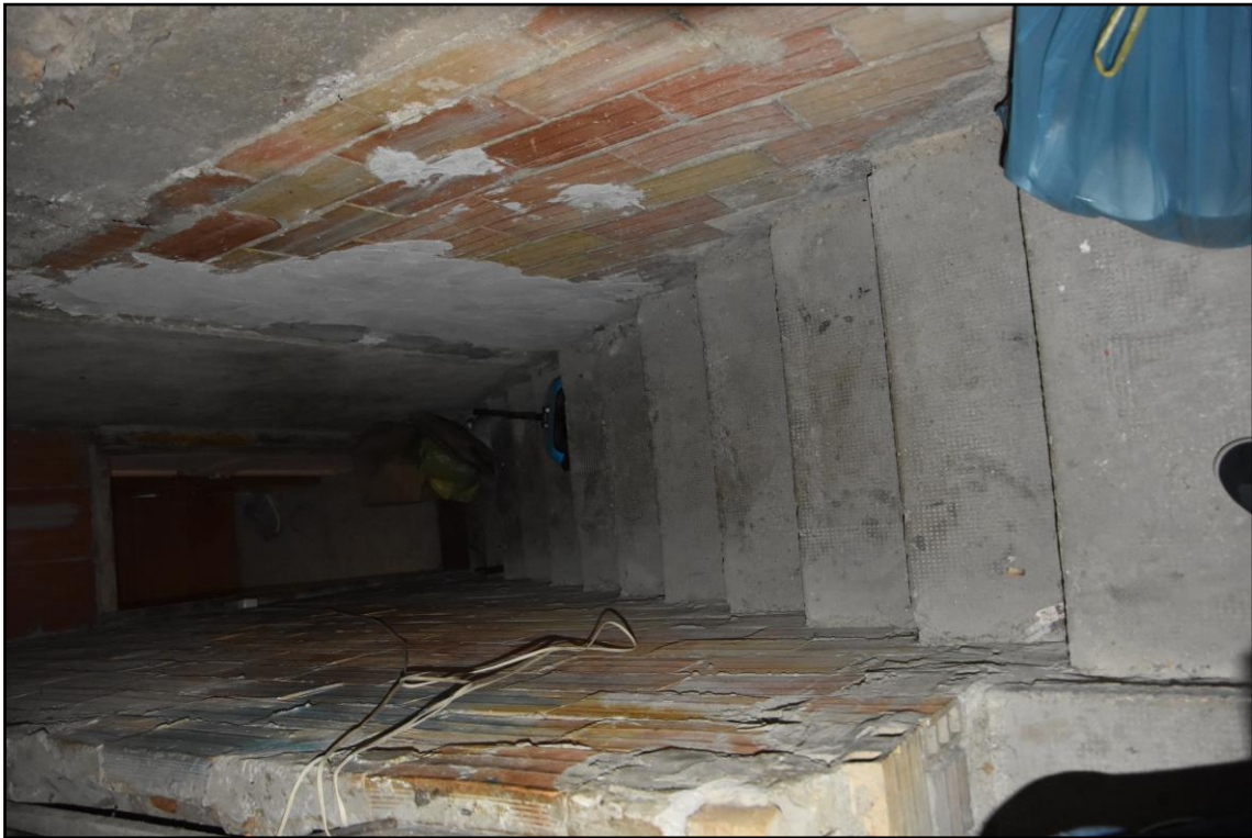
Foto n. 12: Scala esclusiva accesso sottotetto
