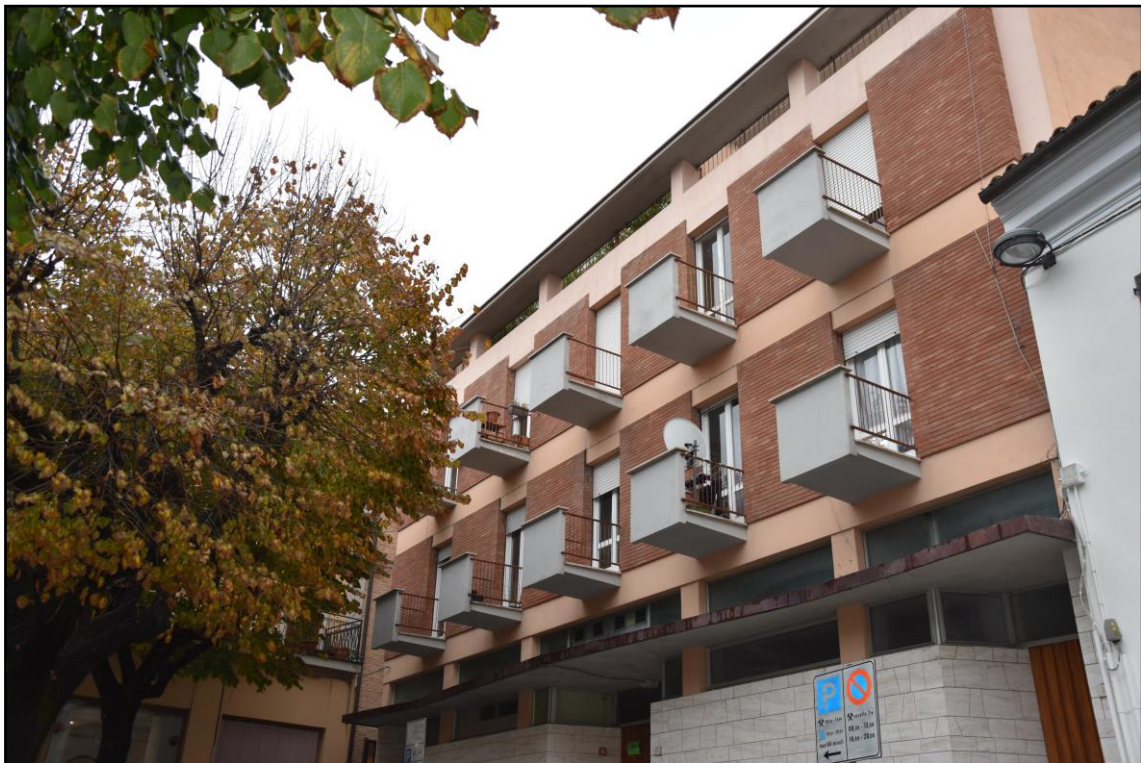
Foto n. 02: Prospetto principale dell'edificio
