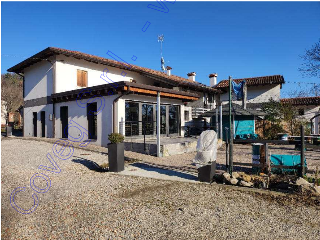
Particolare prospetto sud - ovest
