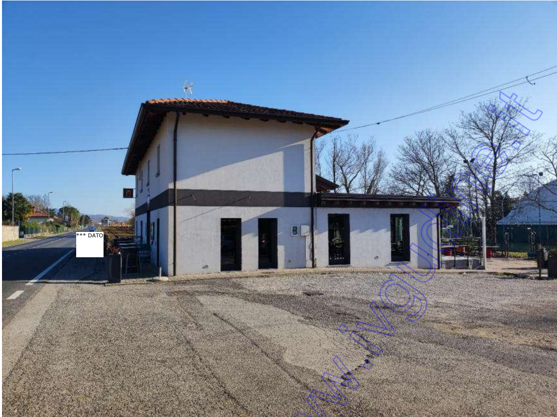
Particolare prospetto ovest
