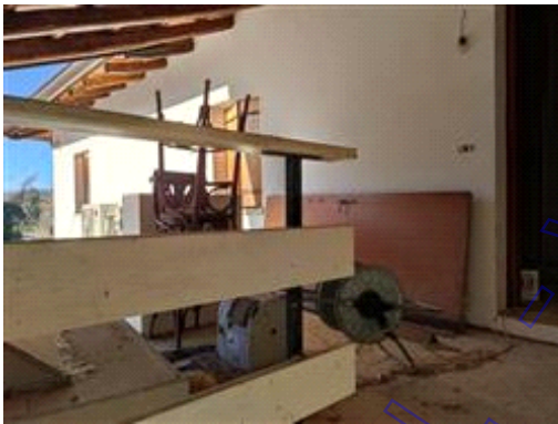
Arrivo dalla scala esterna sul portico.
