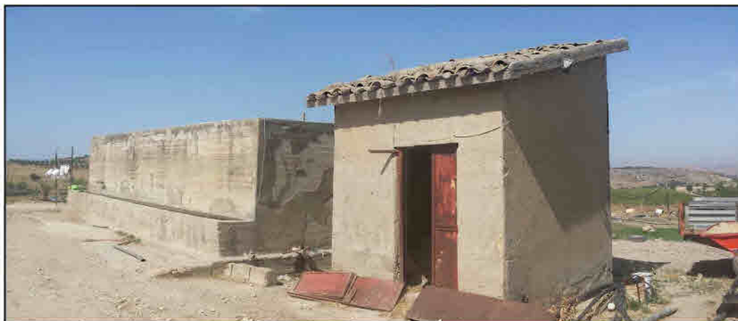
Vasca e locale pompe
