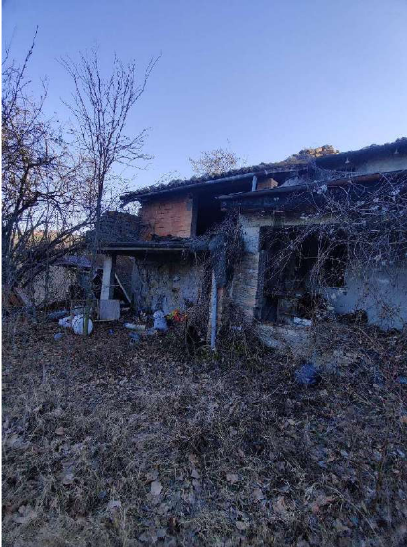
Immagine della legnaia e del portico di ingresso al piano Terra
