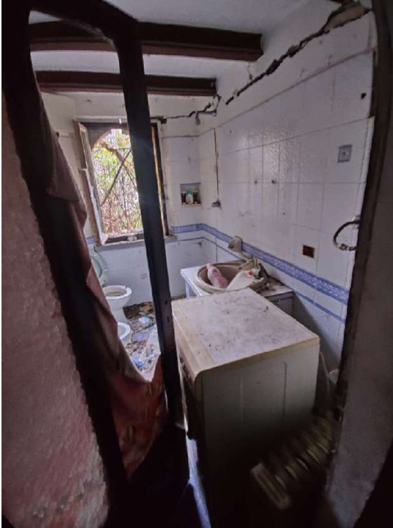
Vista del servizio igienico.
