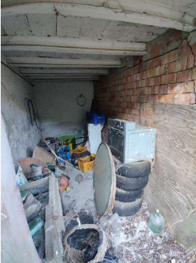
Vista del ripostiglio al piano Terra, sul lato Ovest.
