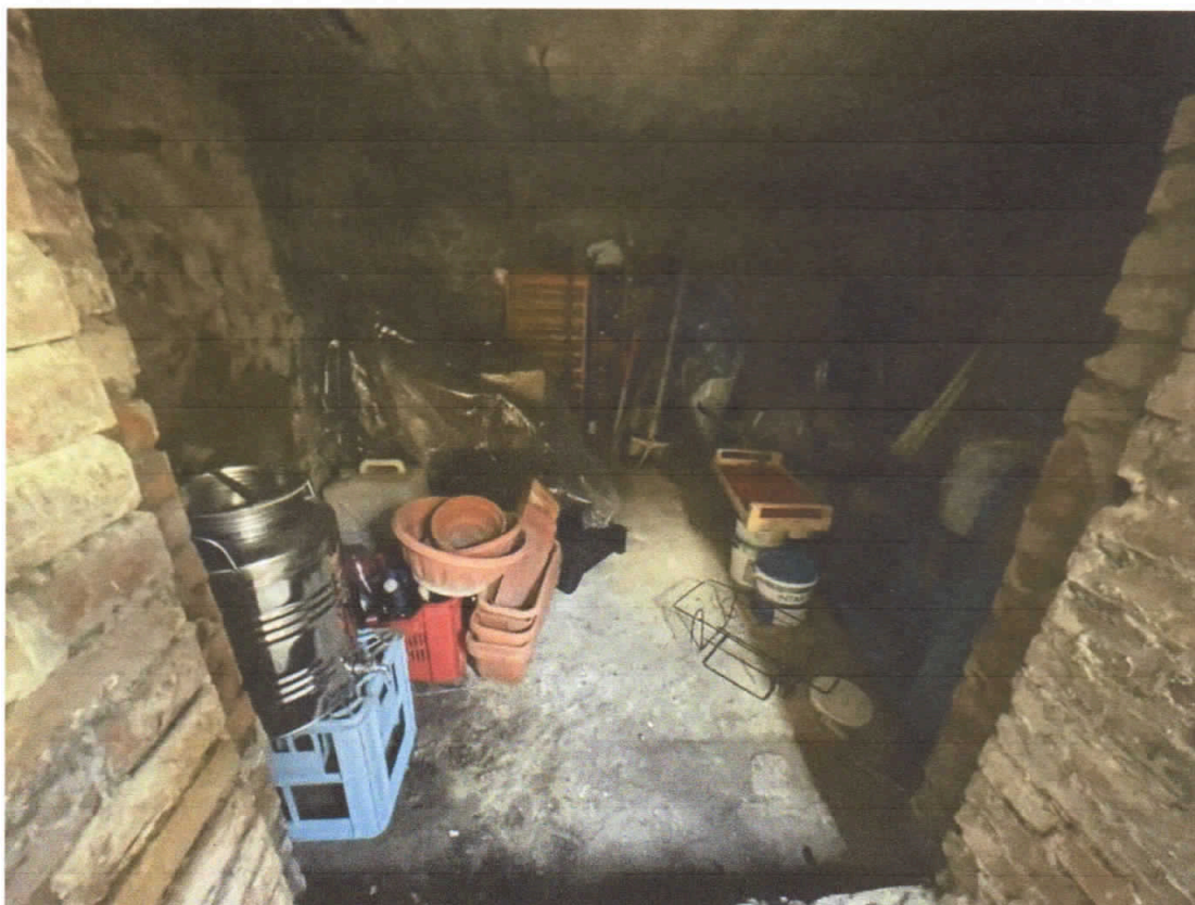
51) C.F. Fg.68 p.IIa 453 sub.4 – Particolare della cantina al piano primo sottostrada
