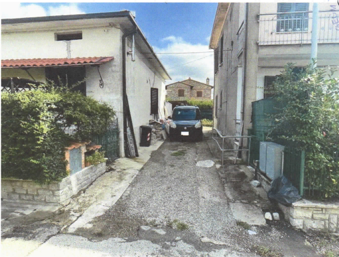
73) C.F. Fg.68 p.IIIa 453 sub.1 – Particolare della corte esterna ad uso esclusivo dei beni oggetto di stima
