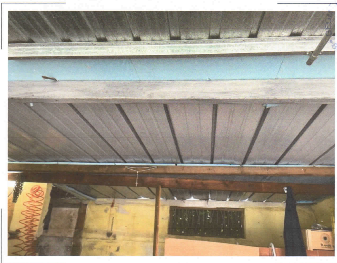
63) C.F. Fg.68 p.IIa 453 sub.3 – Particolare della copertura della legnaia con accessori due ripostigli attualmente in corso di trasformazione
