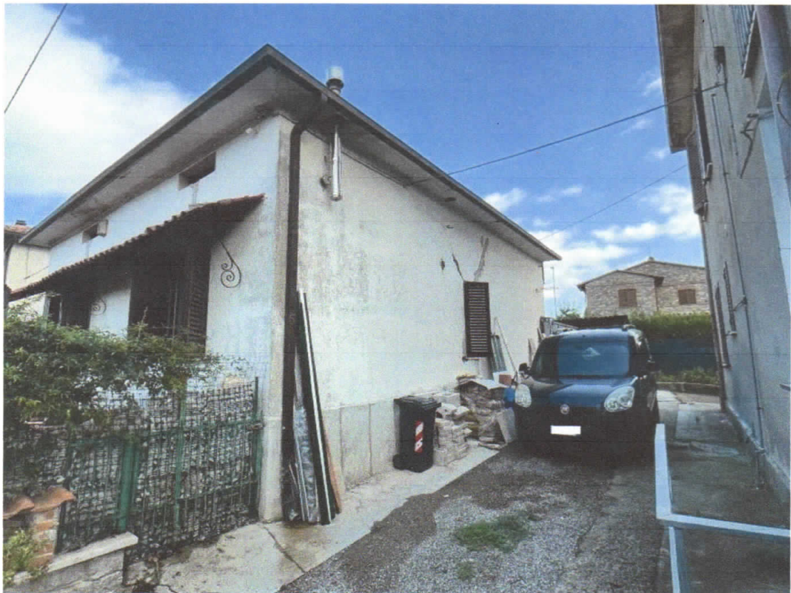
5) C.F. Fg. 68 p.IIa 453 sub.1, 2, 3 e 4 – Prospetto laterale sx vista generale del complesso immobiliare oggetto di stima ad uso abitativo
