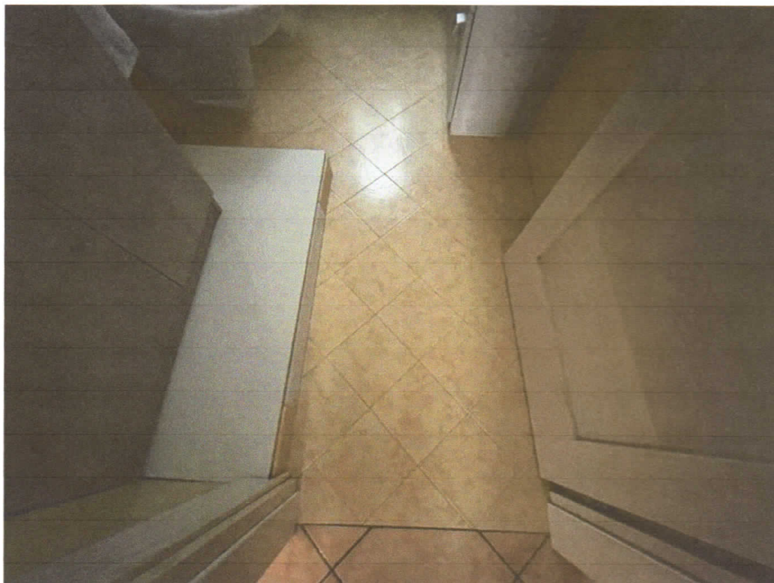
27) C.F. Fg.68 p.IIa 453 sub.4 – Particolare della pavimentazione del bagno
