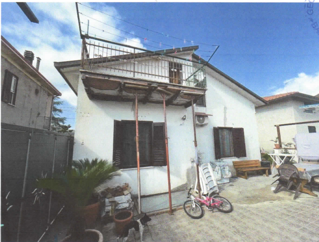
4) C.F. Fg. 68 p.IIa 453 sub.1, 2, 3 e 4 – Retro prospetto vista generale del complesso immobiliare oggetto di stima ad uso abitativo
