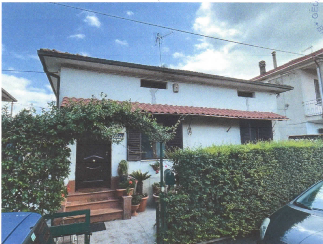
2) C.F. Fg. 68 p.IIa 453 sub.1, 2, 3 e 4 – Prospetto principale vista generale del complesso immobiliare oggetto di stima ad uso abitativo
