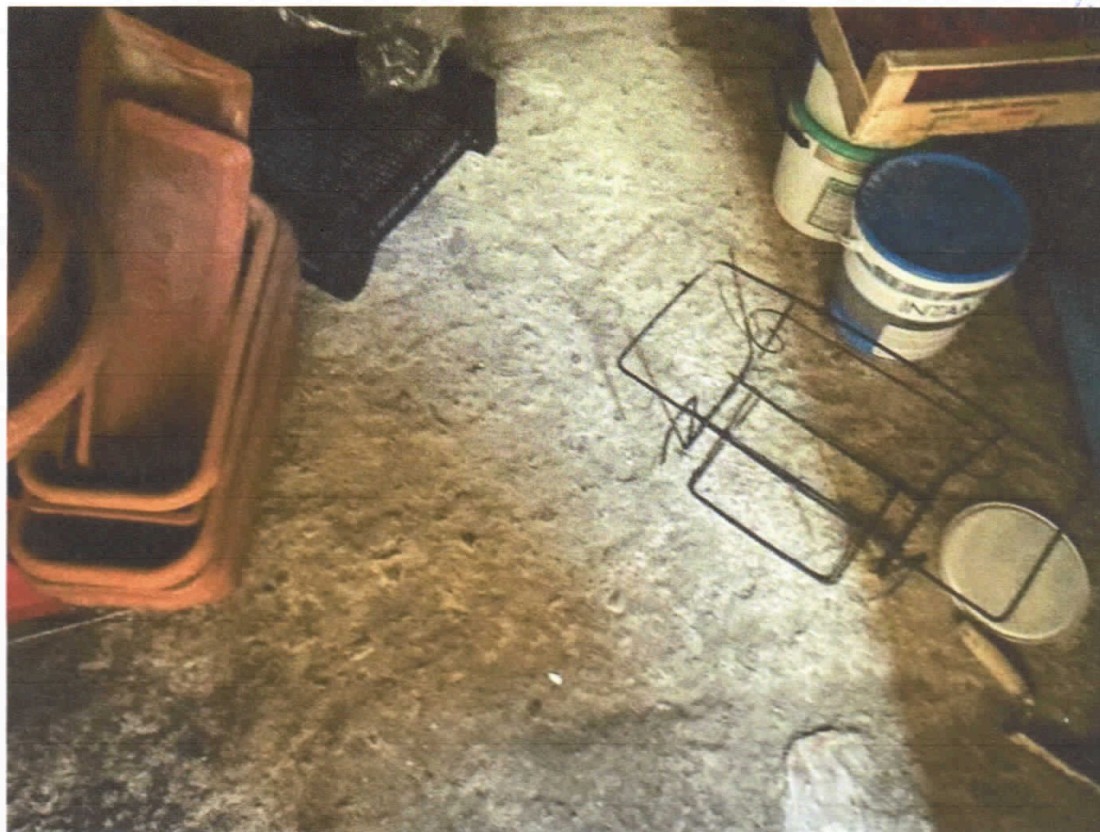
52) C.F. Fg.68 p.IIa 453 sub.4 – Particolare della pavimentazione della cantina al piano primo sottostrada
