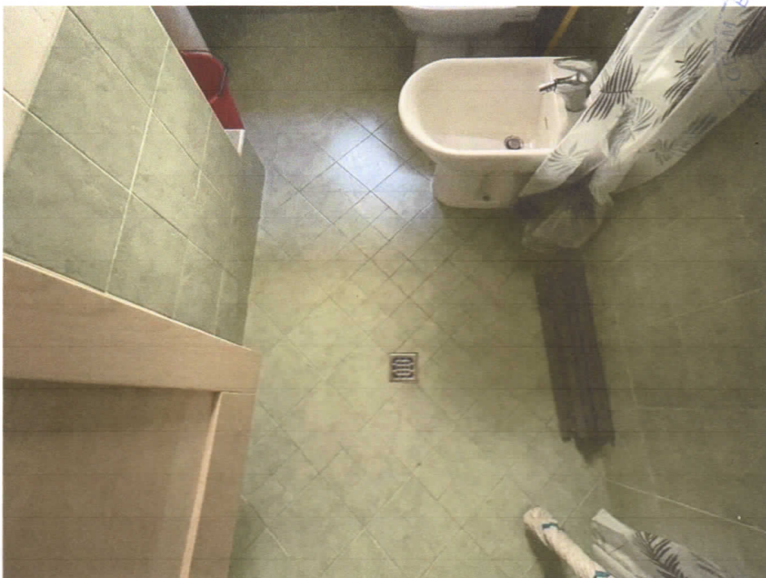
28) C.F. Fg.68 p.IIa 453 sub.4 – Particolare della pavimentazione del w.c.
