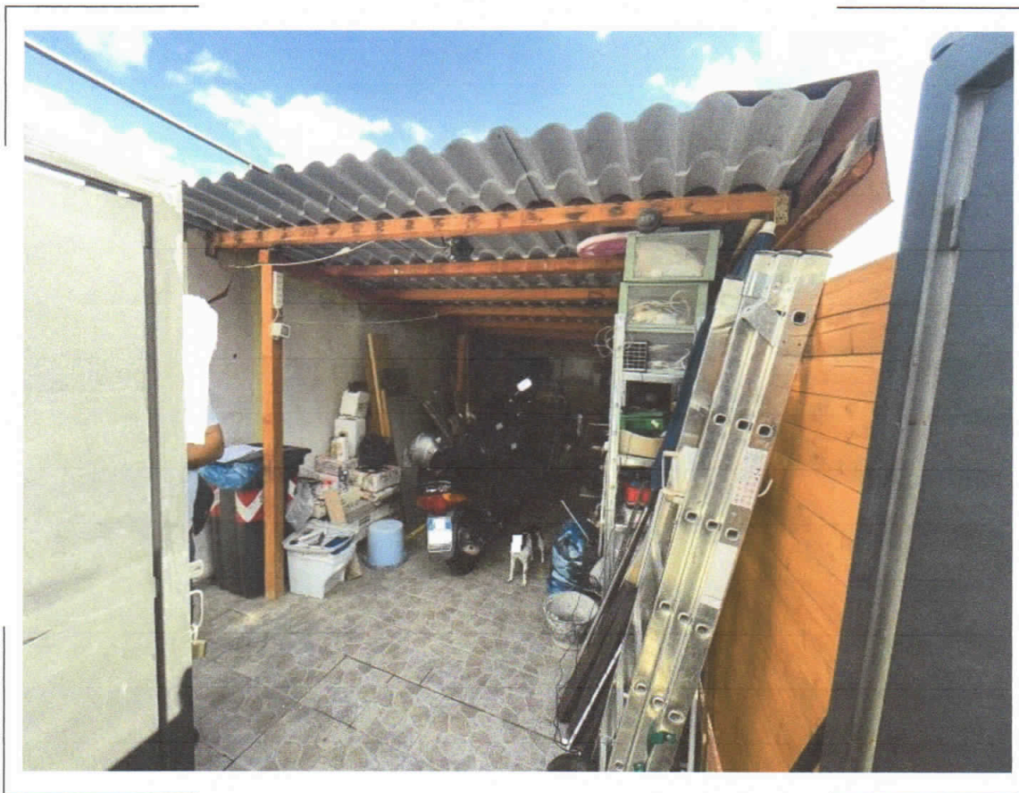
66) C.F. Fg.68 p.IIa 453 sub.2 – Particolare dell'ubicazione della baracca in metallo demolita e sostituita da una tettoia il legno con copertura in pvc
