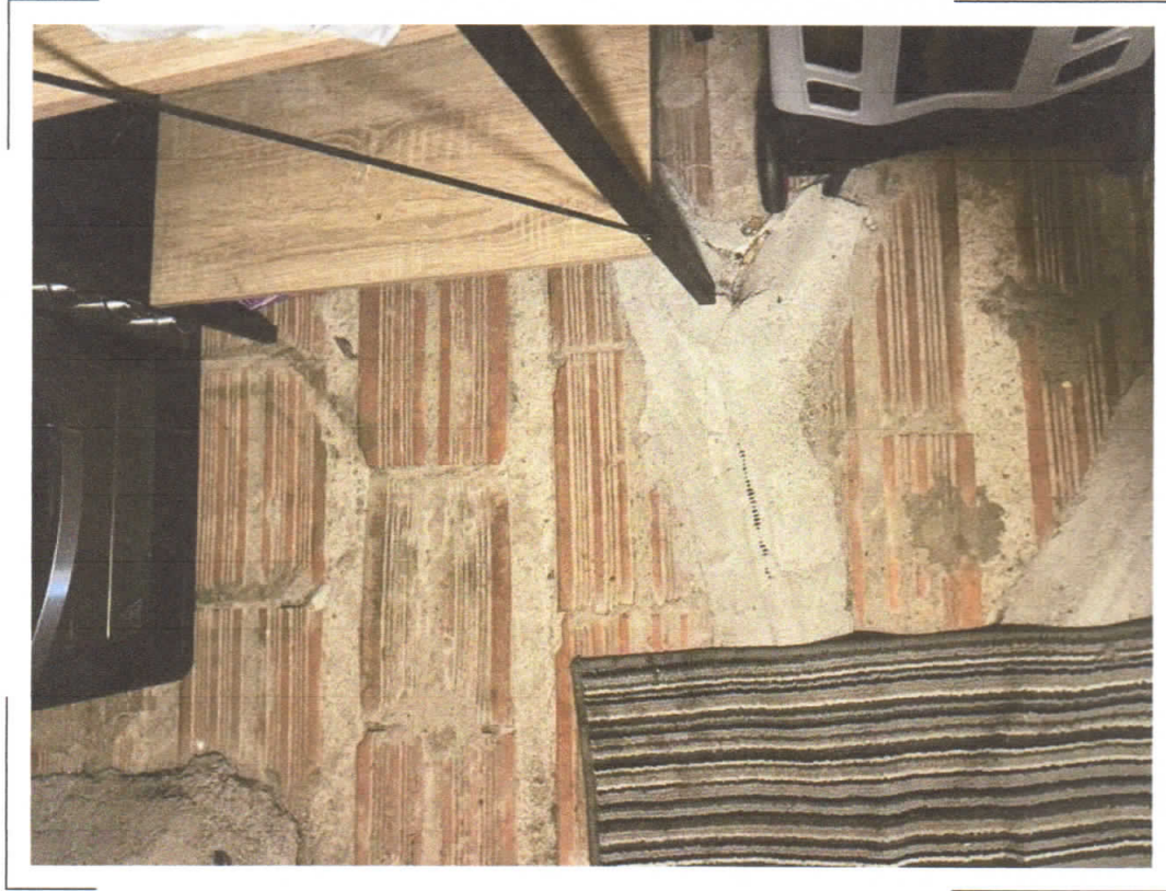
26) C.F. Fg.68 p.Ila 453 sub.4 – Particolare del pavimentazione della soffitta al piano primo/sottotetto
