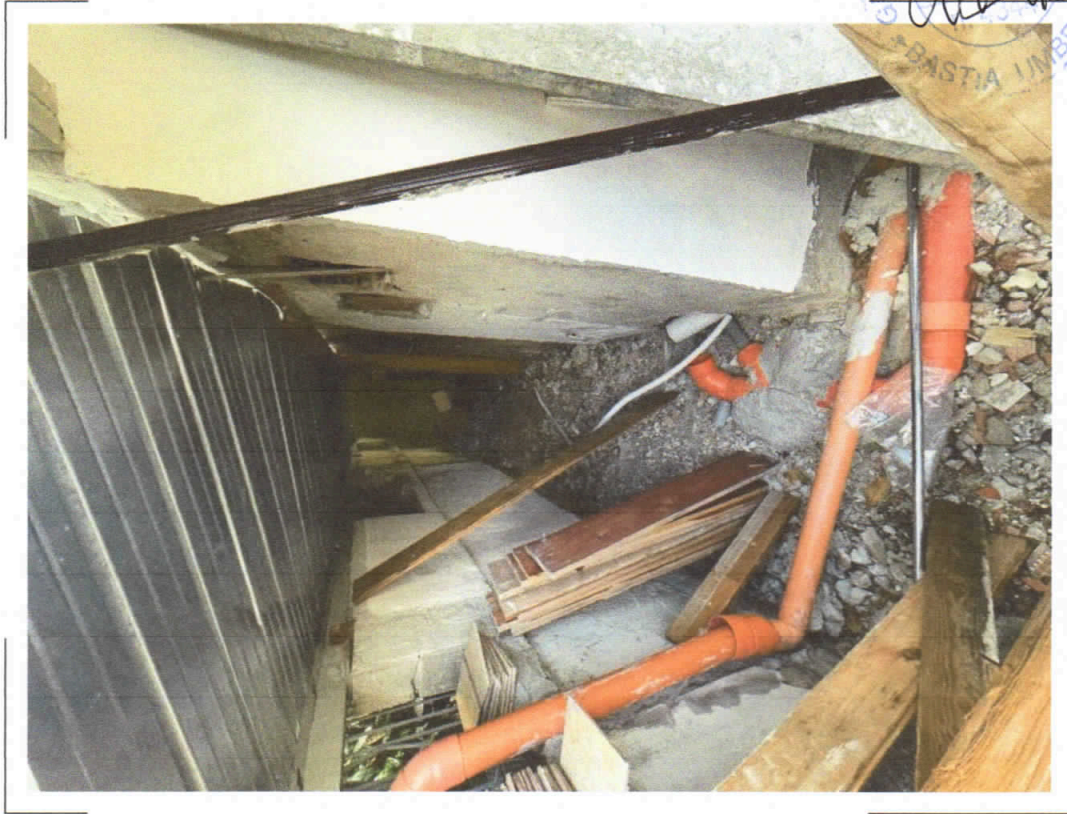
64) C.F. Fg.68 p.IIa 453 sub.3 – Particolare della copertura della legnaia con accessori due ripostigli attualmente in corso di trasformazione
