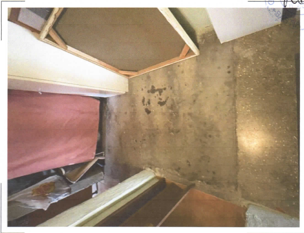
25) C.F. Fg.68 p.Ila 453 sub.4 – Particolare del pavimentazione del disimpegno al piano primo/sottotetto
