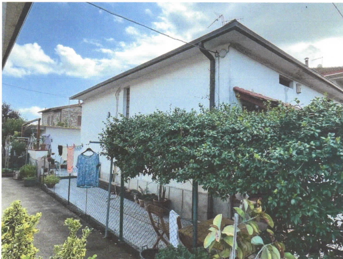
3) C.F. Fg. 68 p.IIa 453 sub.1, 2, 3 e 4 – Prospetto laterale dx vista generale del complesso immobiliare oggetto di stima ad uso abitativo
