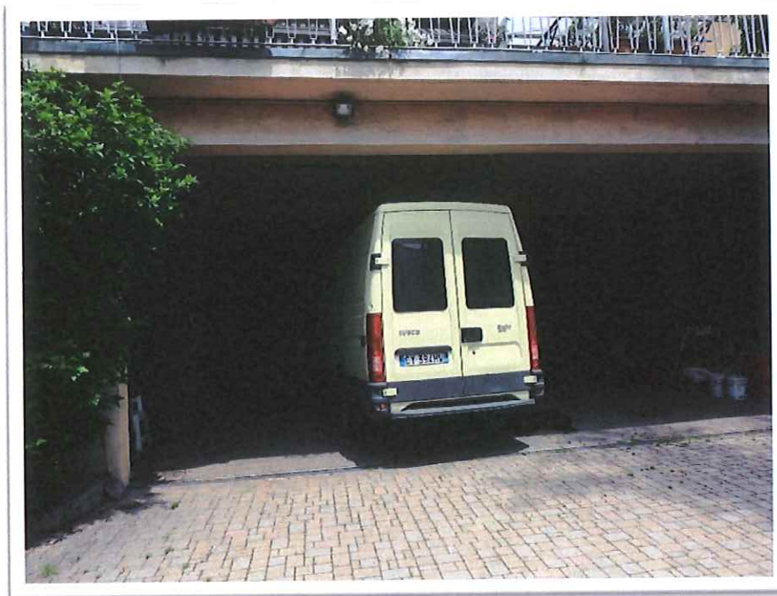
Foto N. 63: vista dell'accesso al magazzino, a piano seminterrato, della villa;
