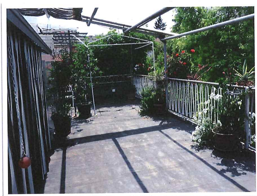
Foto N. 52: vista della terrazza, a piano terra, della villa;
