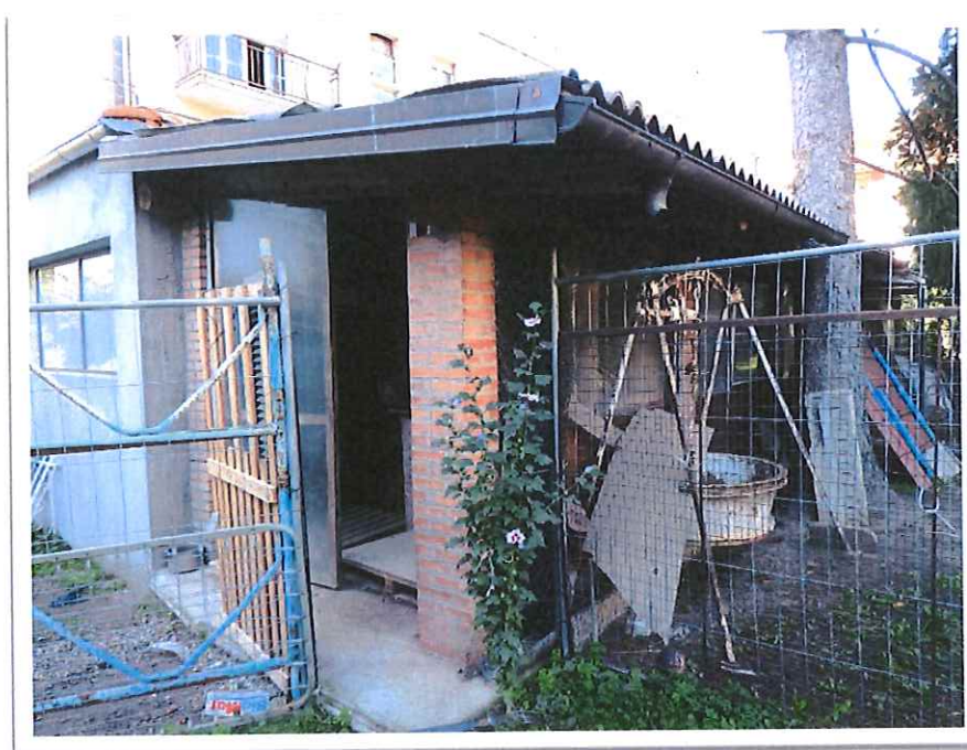
Foto N. 70: vista della tettoia che dovrà essere demolita;
