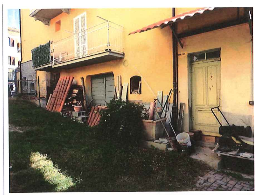
Foto N. 2: vista del portone in legno di accesso al magazzino;
