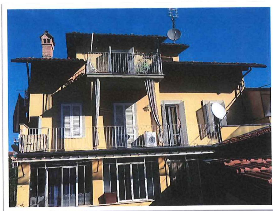
Foto N. 33: vista esterna dell'appartamento posto al piano secondo;
