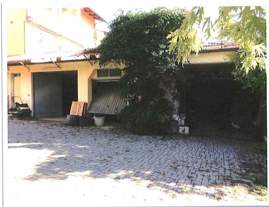
Foto N. 5: vista dei portoni di accesso alle autorimesse;
