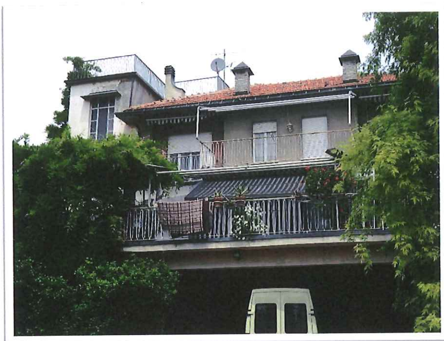
Foto N. 45: vista della facciata sud della villa dal cortile interno;
