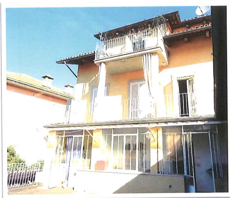
Foto N. 15: vista della facciata posta a Sud dal terrazzo dell'appartamento;
