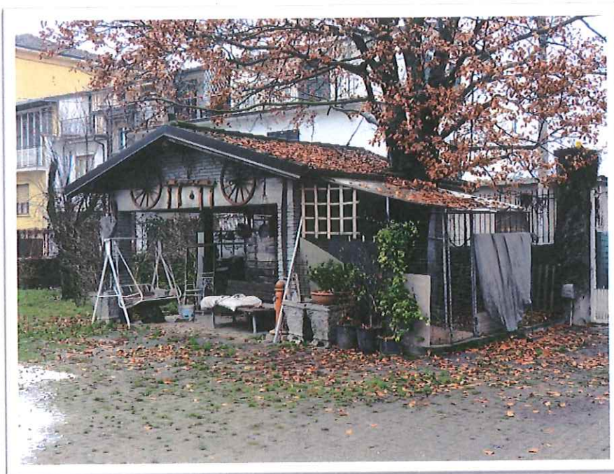
Foto N. 69: vista del basso fabbricato che dovrà essere demolito;
