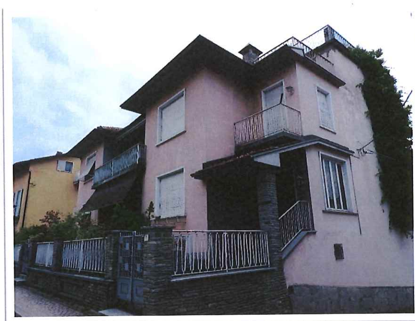
Foto N. 44: vista della facciata principale della villa da Via Torino;
