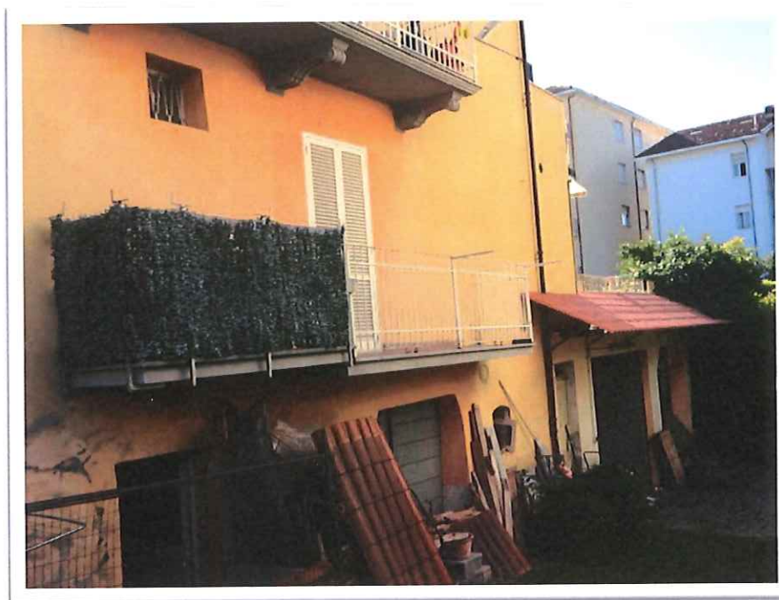
Foto N. 1: vista esterna degli accessi al magazzino e all'autorimessa;
