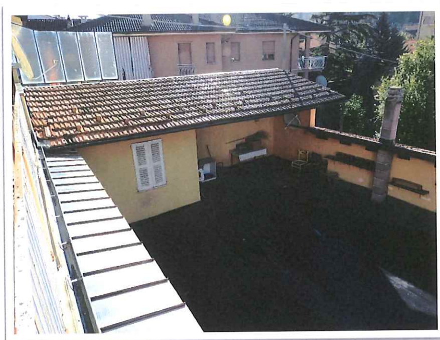
Foto N. 19: vista dell'ampia terrazza dell'appartamento;
