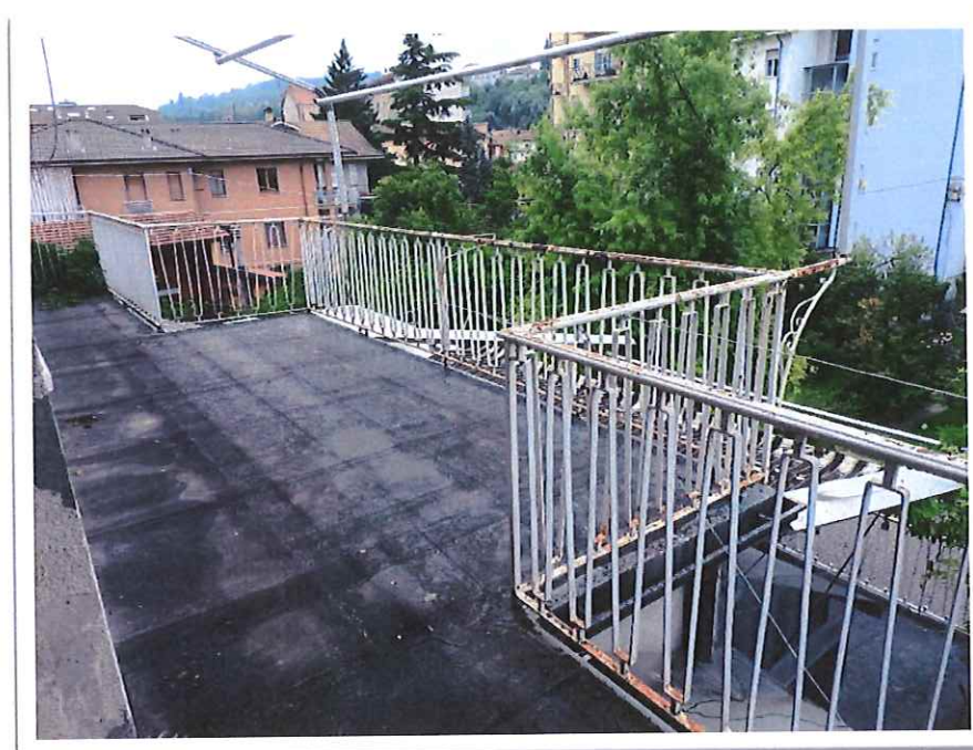
Foto N. 56: vista del balcone, a piano primo, della villa;
