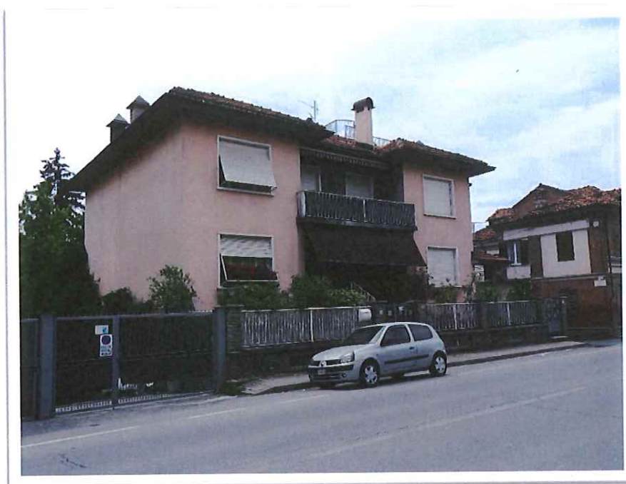
Foto N. 43: vista della facciata principale della villa da Via Torino;
