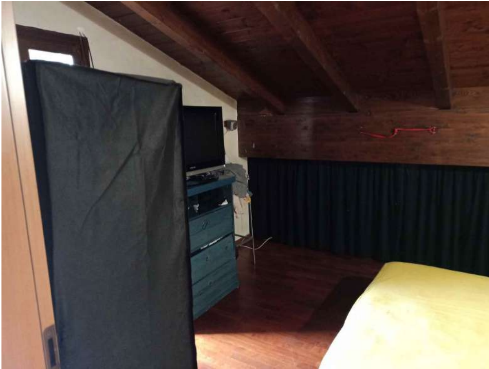
Foto n. 4 – Appartamento – Piano secondo - Soffitta
