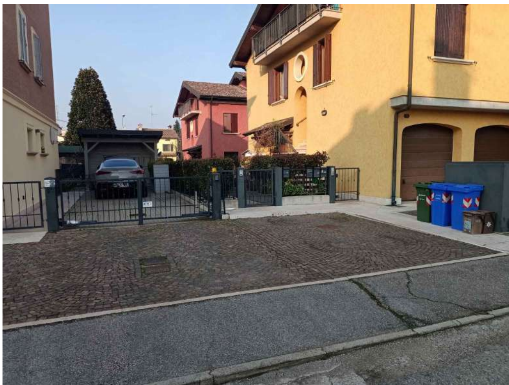
Foto n. 7 – Area urbana – Piano terra
