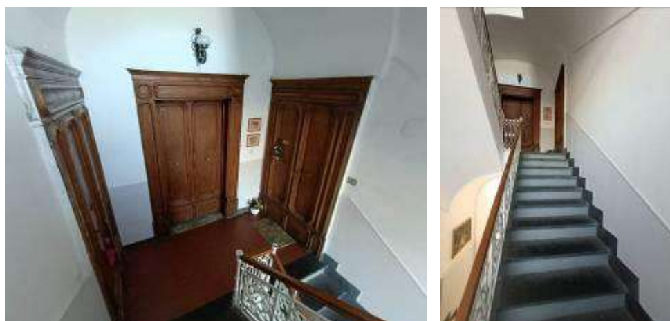
Pavimento pianerottolo di smonto del primo piano
