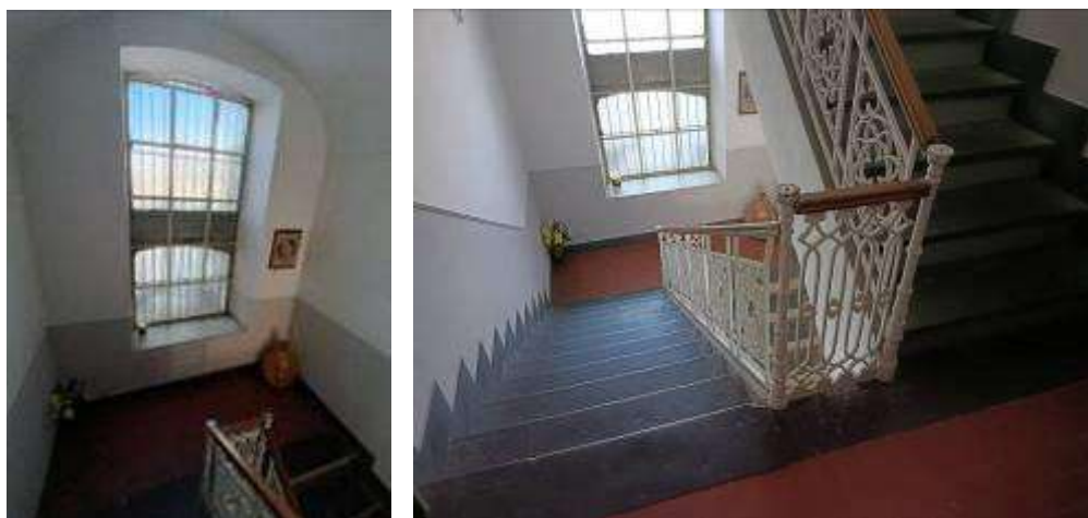
Infissi – Rampa di scale in pietra locale
