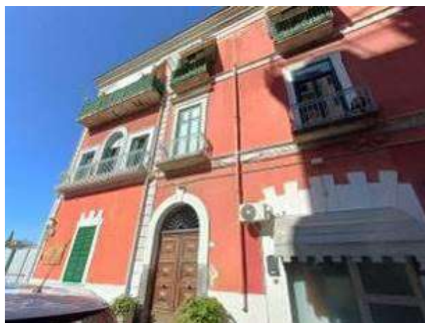
Portone di ingresso fabbricato
