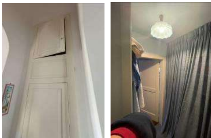
Ripostiglio in quota
