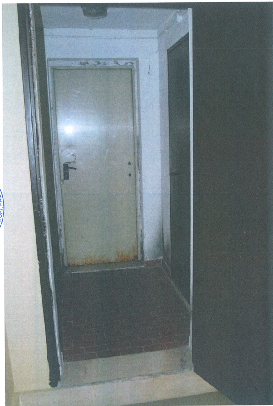
Disimpegno del locale lavatoio –pianerottolo- sub 502- piano 5°
