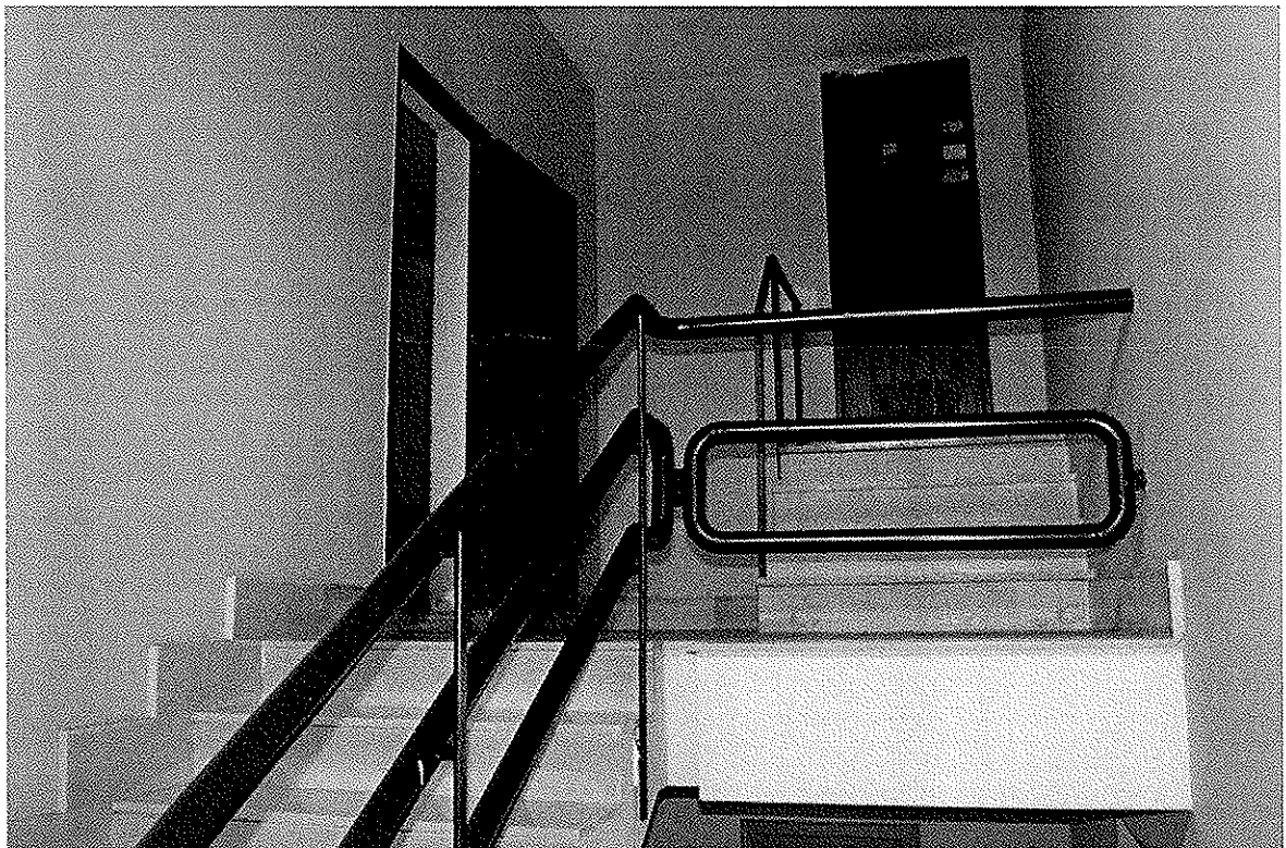
INGRESSO AL LAVATOIO VIA A. DI TIVOLI 12 PIANO 6°
