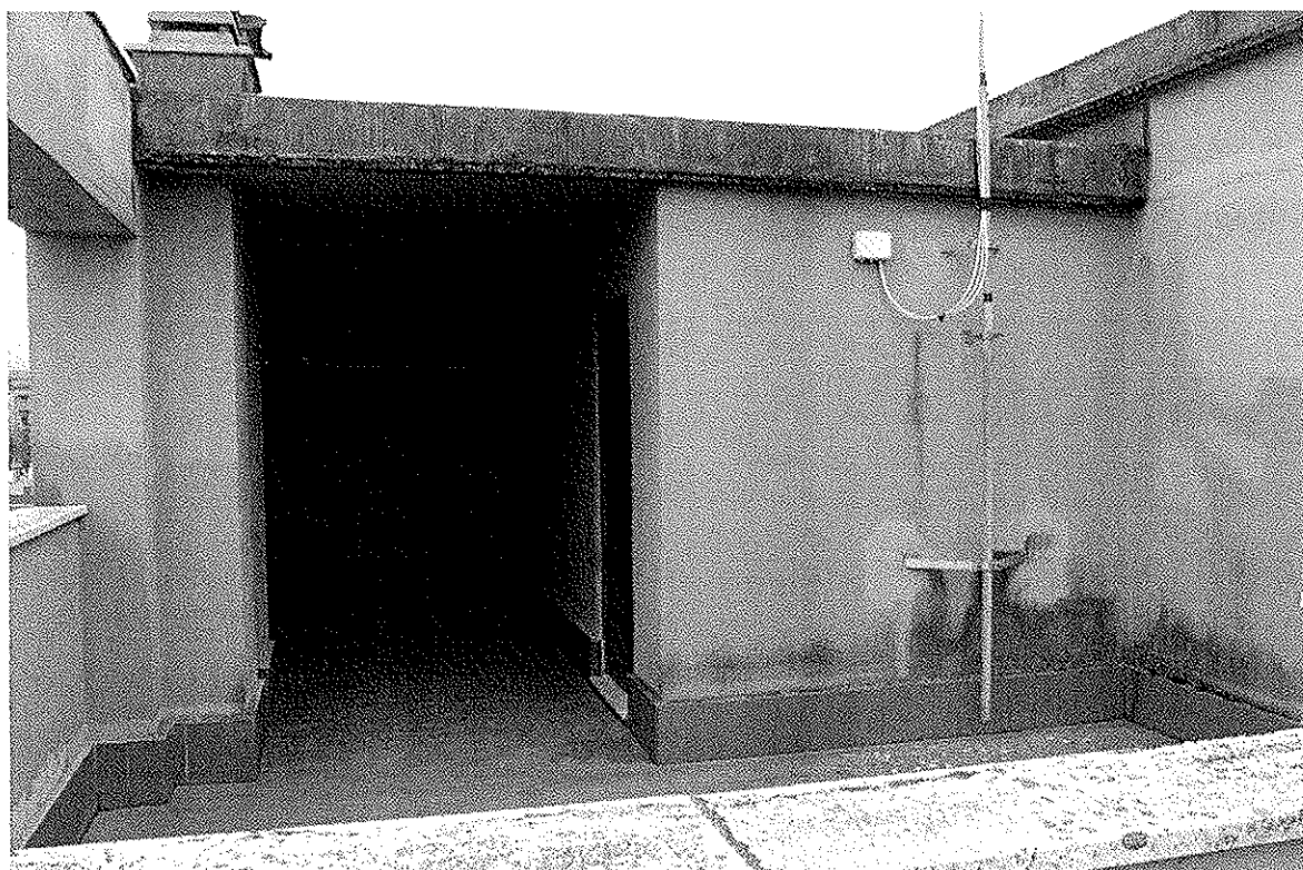
PARTICELLA 294 FOGLIO 1081 SUB 504 TERRAZZO
