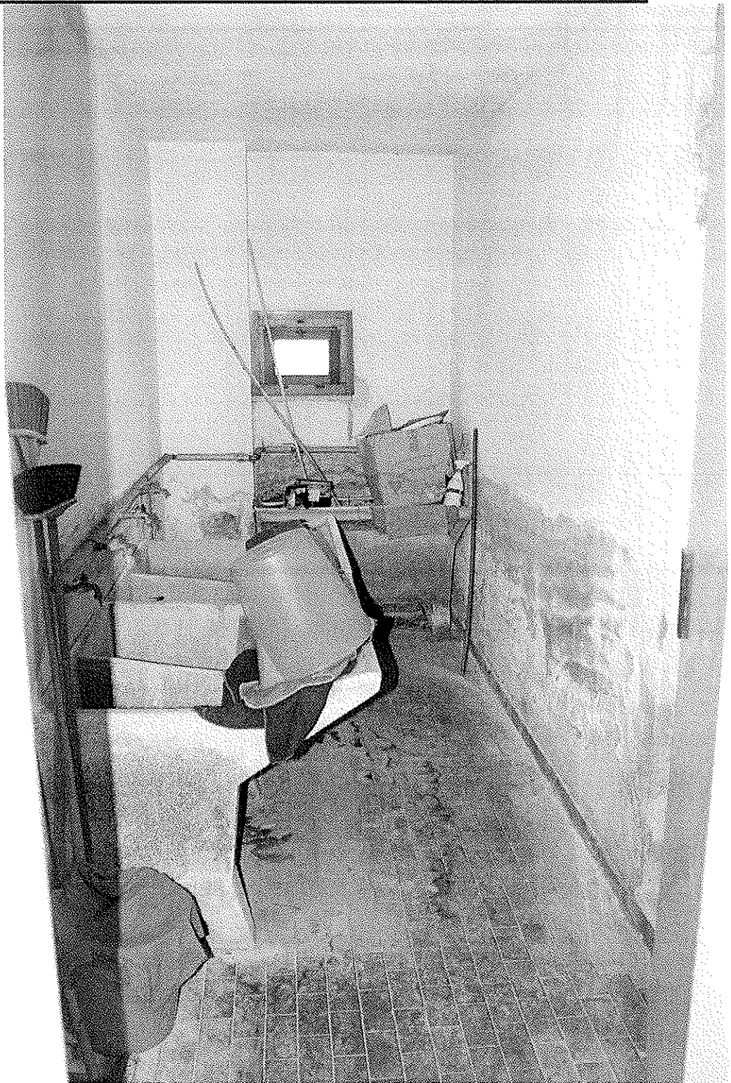
- INTERNO- LAVATOIO VIA ABATE DI TIVOLI 5 FOGLIO 294 PARTICELLA 1079 SUB 503-EDIFICIO 4
