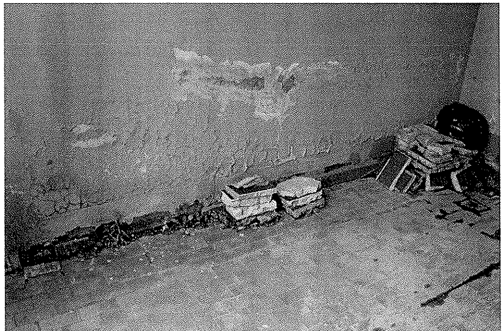
LAVATOIO - INTERNO- VIA ABATE DI TIVOLI 5 FOGLIO 294PARTICELLA
