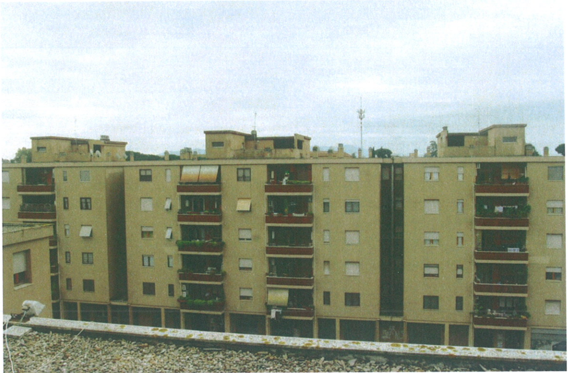
EDIFICIO 5 n° 3 LAVATOI in Via ABATE DI TIVOLI 12-24-36 PIANO 6
