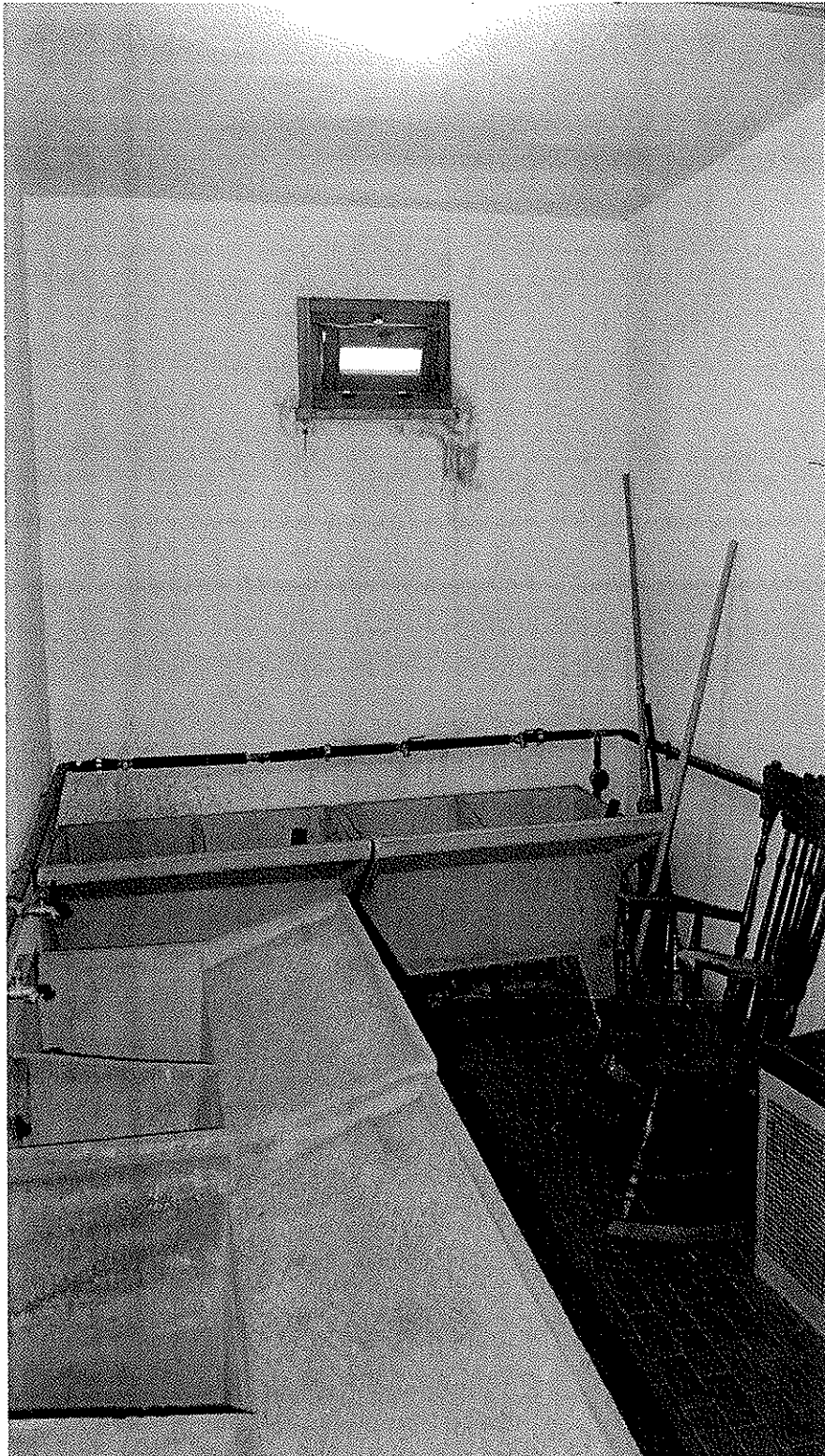
PARTICELLA 294 FOGLIO 1081 SUB 504 LAVATOIO
