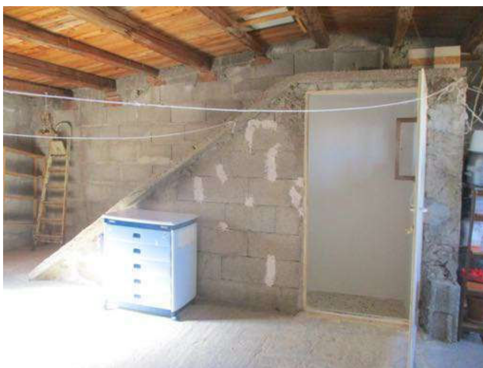
Foto 26- vista del piano 3° sottotetto ex terrazza
