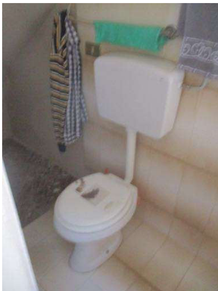
Foto 12- vista del WC attiguo al soggiorno
