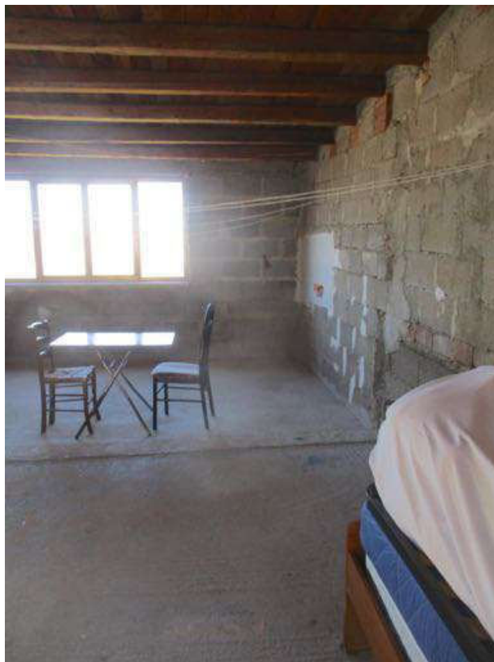
Foto 27- vista del piano 3° sottotetto ex terrazza
