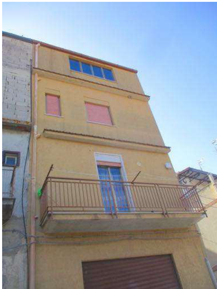
Foto 2- vista del prospetto su via Verga (civ.11)
