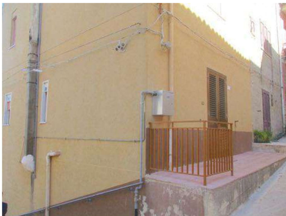
Foto 4- vista dell'ingresso all'abitazione in CF [REDACTED] via Manzoni 1
