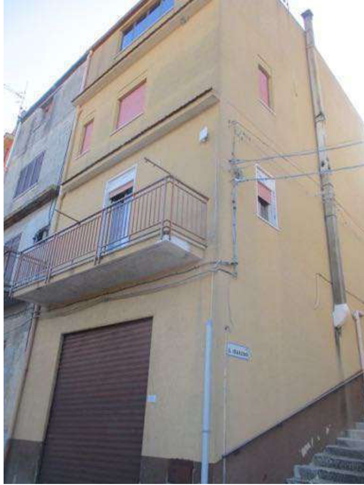
Foto 1- vista del fabbricato sito in Vicari, via Verga (civ.11) e via Manzoni (civ.1)
