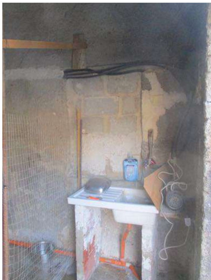
Foto 6- particolare del vano murato, magazzino via Verga (civ.11)
