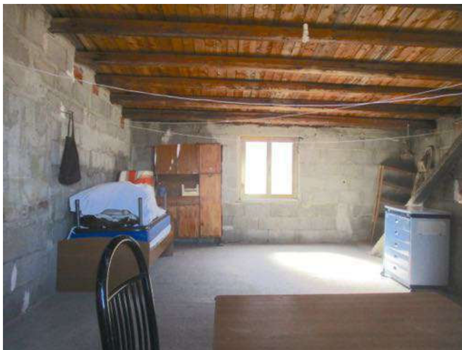
Foto 25- vista del piano 3° sottotetto ex terrazza
