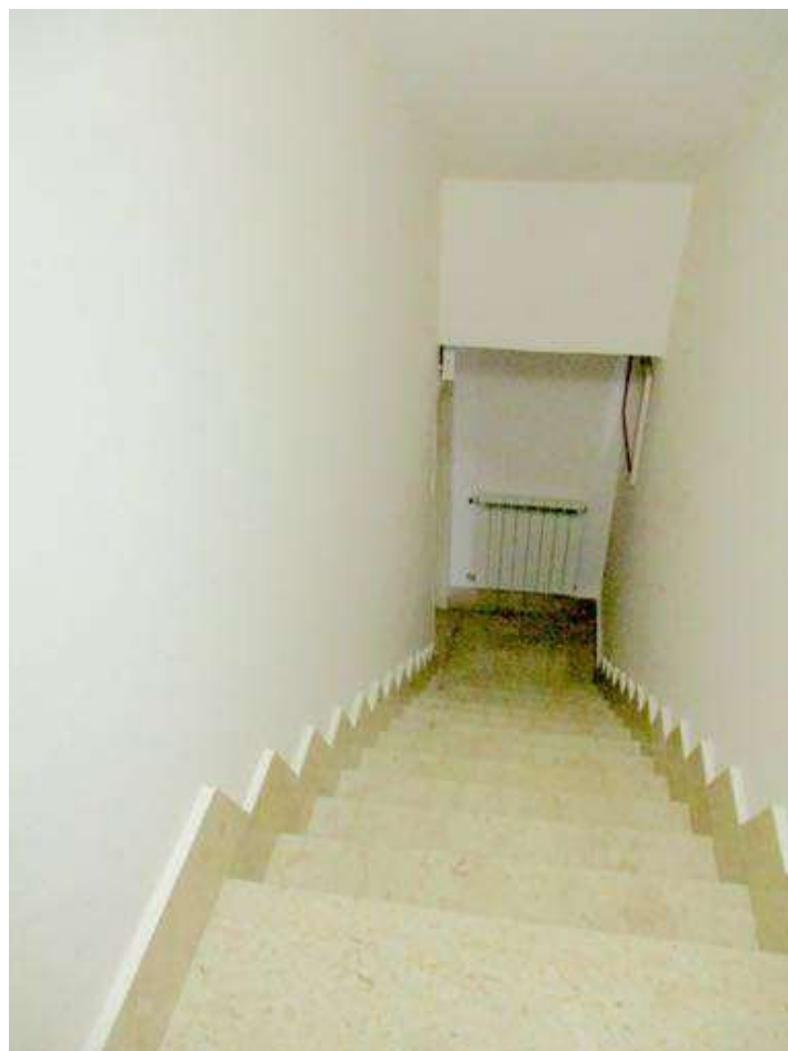
Foto 18- vista della scala di collegamento interna
