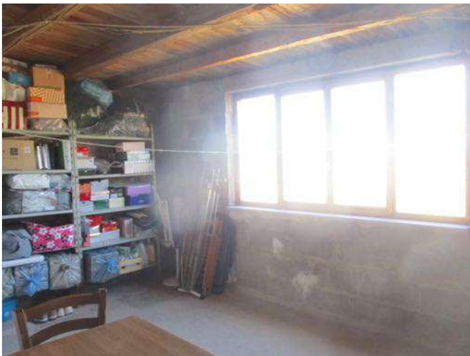
Foto 24- vista del piano 3° sottotetto ex terrazza
