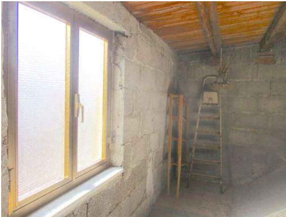
Foto 23- vista del piano 3° sottotetto ex terrazza
