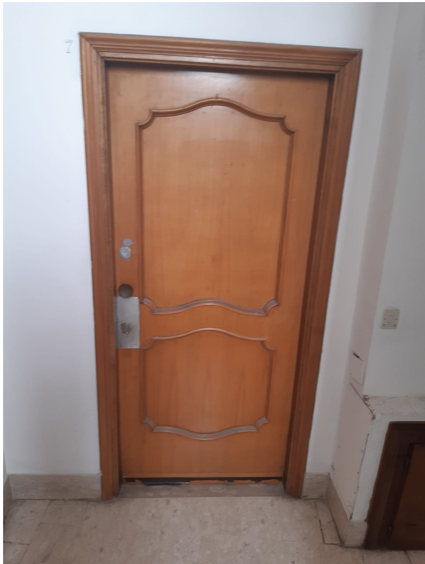
Vista particolare ubicazione e tipologia portoncino caposcala in pian secondo di accesso alla U.I.U.
