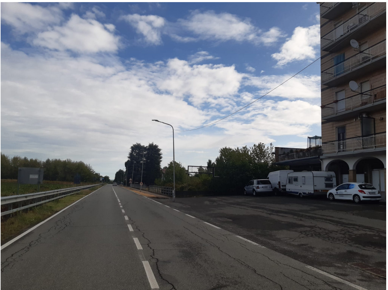
Vista d'insieme dell'ubicazione del fabbricato condominiale rispetto alla Via Alessandria
