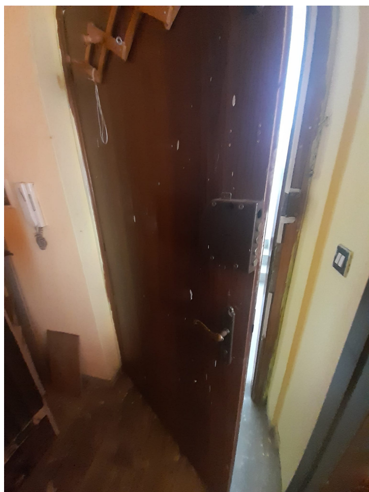
Vista particolare interna alla U.I.U. della zona ingresso / disimpegno
