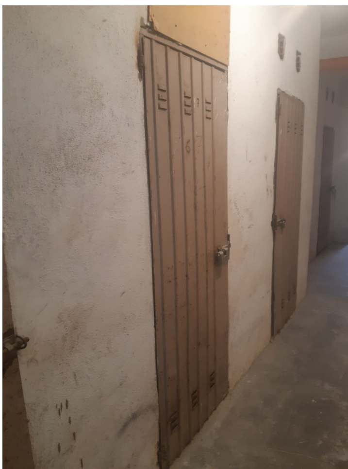
Vista particolare dal disimpegno comune del portoncino di accesso al locale cantina in piano seminterrato
