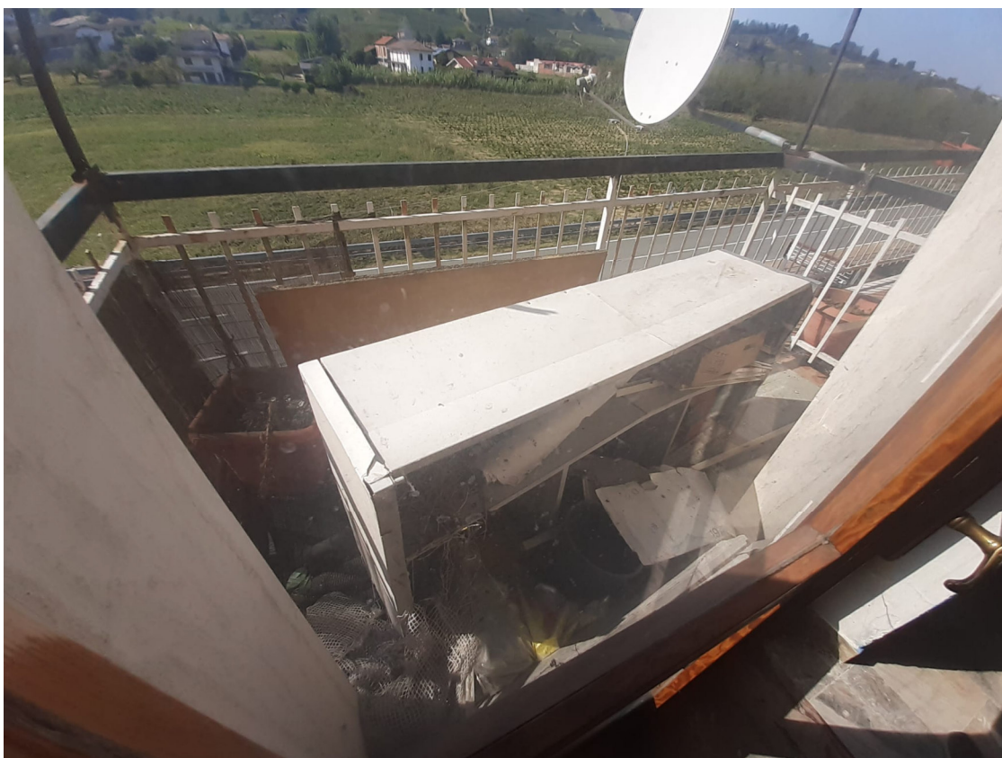
Vista particolare balcone pertinenziale posto sul fronte Ovest
