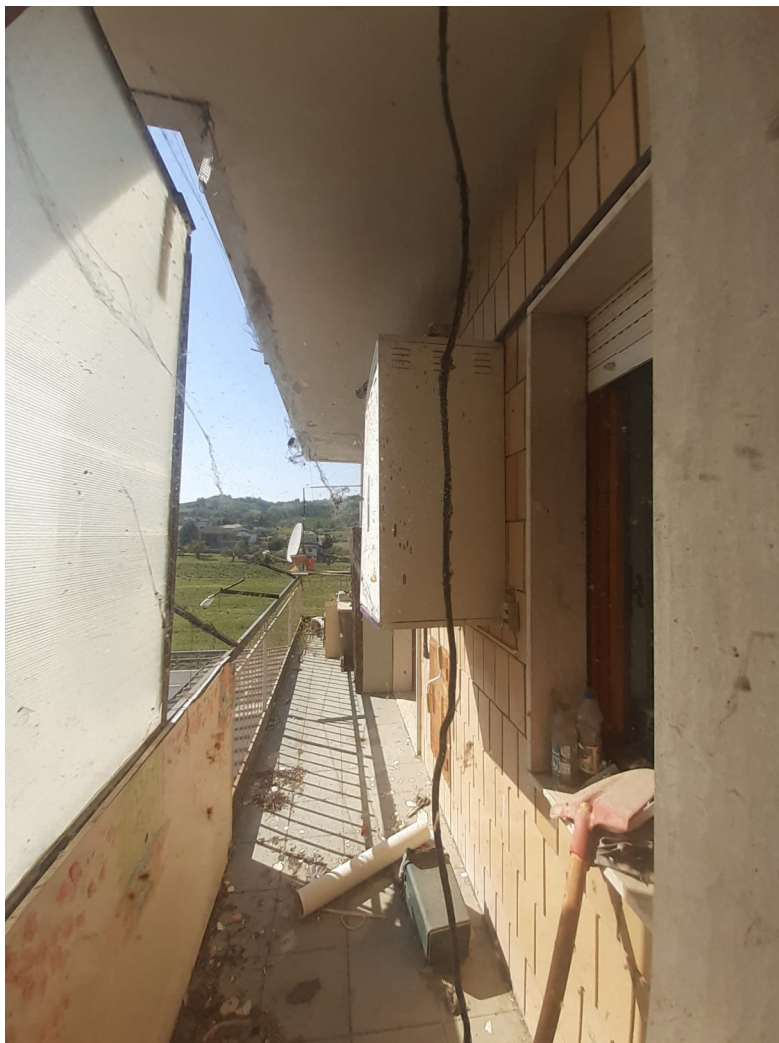
Vista particolare balcone pertinenziale posto sul fronte Sud
