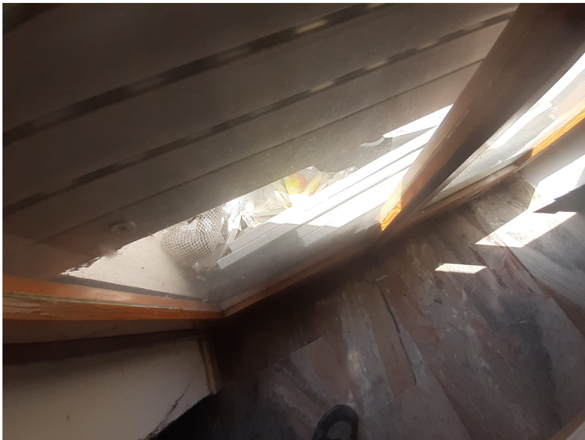
Vista particolare tipologia serramenti a servizio dei locali
