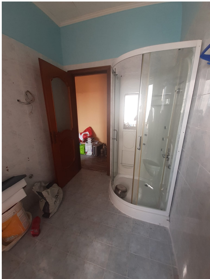
Vista particolare locale bagno e relative dotazioni
