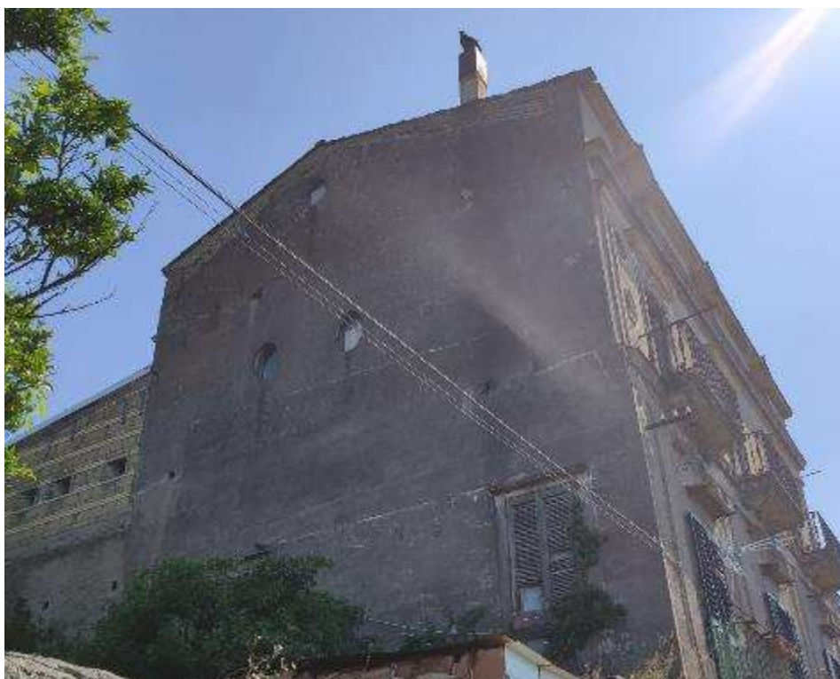
VISTA DELL'UNITÀ DA VIA CAROTENUTO
