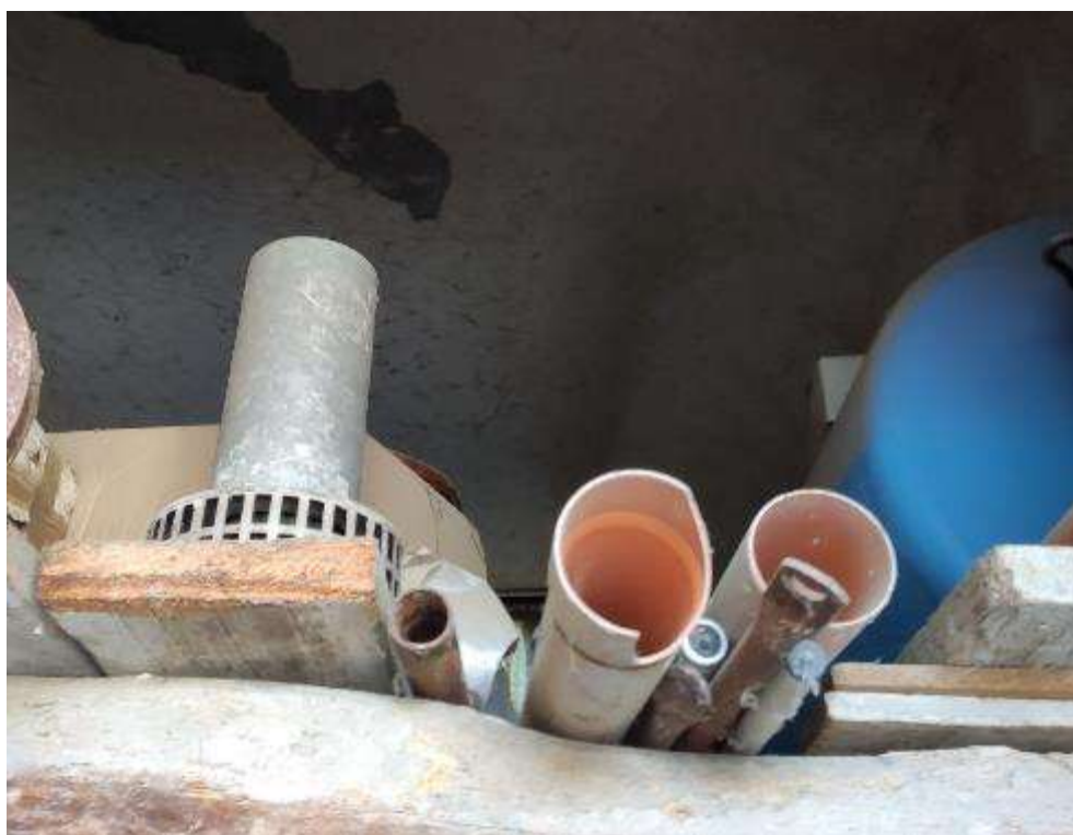
VISTA INTERNA DEL LOCALE DEPOSITO
