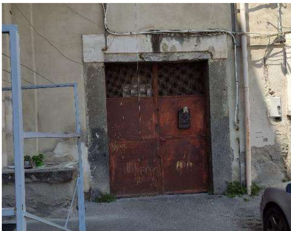
VISTA ESTERNA DEL LOCALE DEPOSITO
