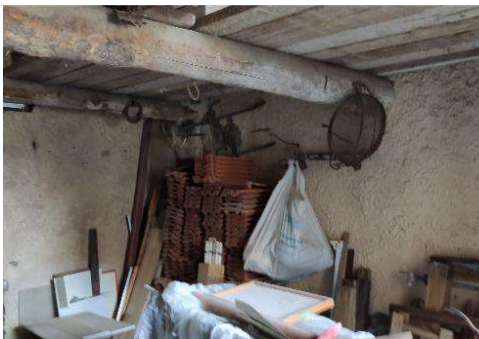
VISTA INTERNA DEL LOCALE DEPOSITO
