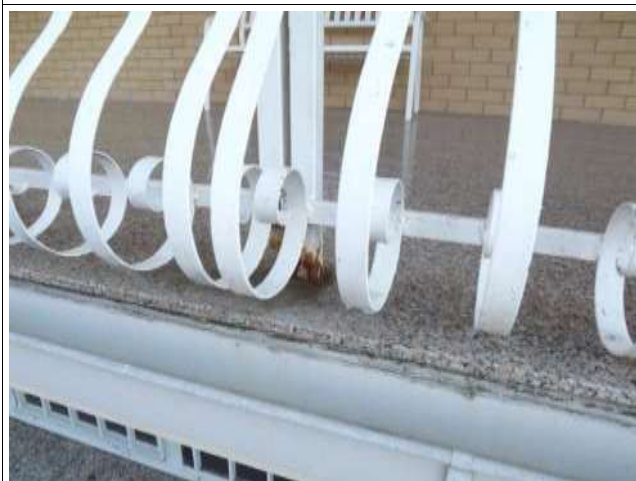
Parapetto logge p.terra ossidazione attacco montanti ringhiera
