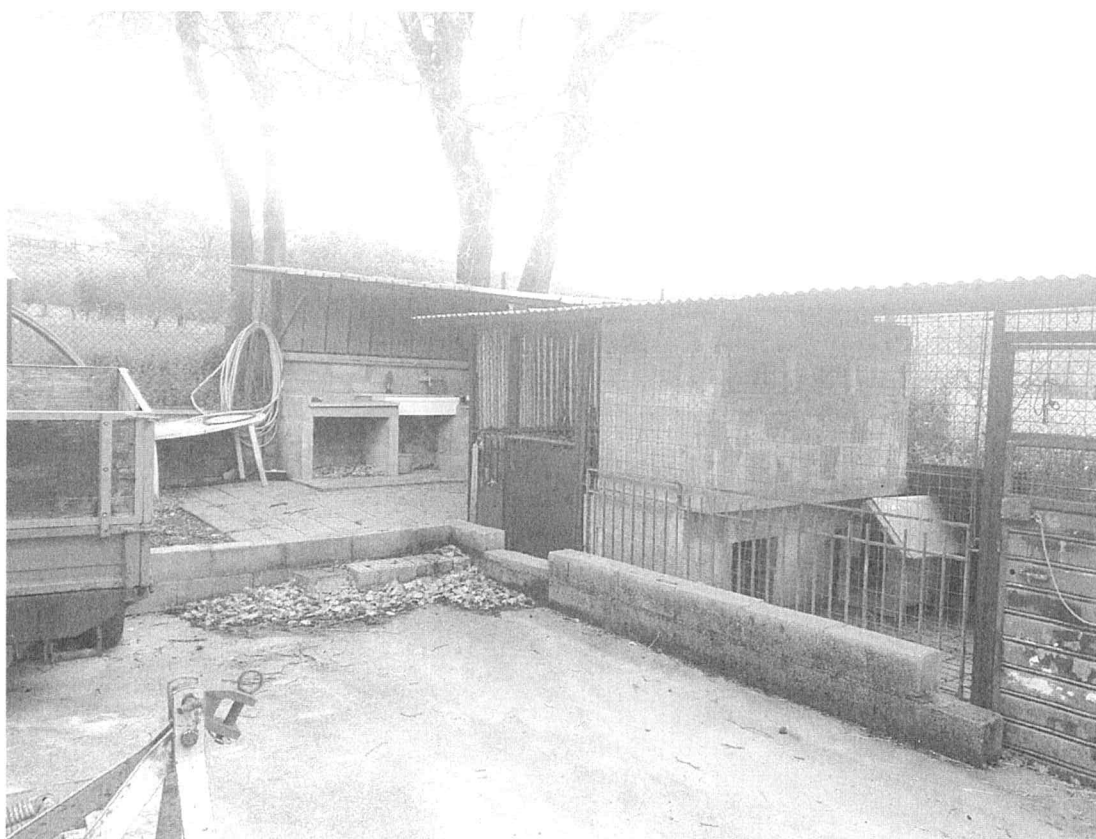
FOTO n. 8 – fabbricati eretti sull'IMMOBILE 2
