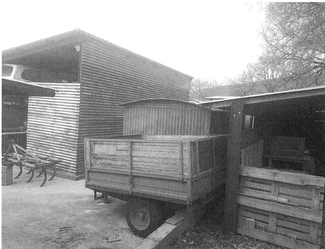
FOTO n. 9 – fabbricati eretti sull'IMMOBILE 2
