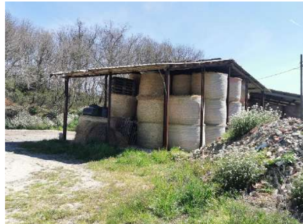
Foto esterna n° 6 Terreni
