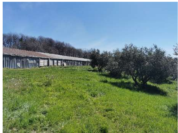
Foto esterna n° 2 Terreni
