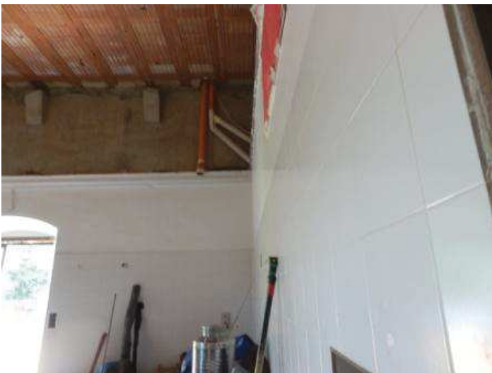
BENE 2 – modifiche non ultimate . con rimozione del controsoffitto
