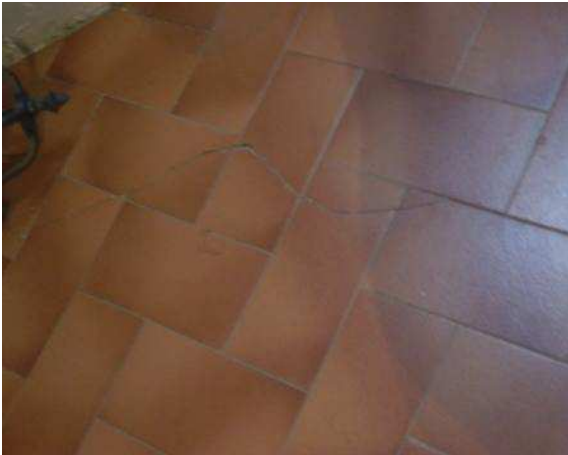
BENE2 lesioni al pavimento e architravi delle porte
