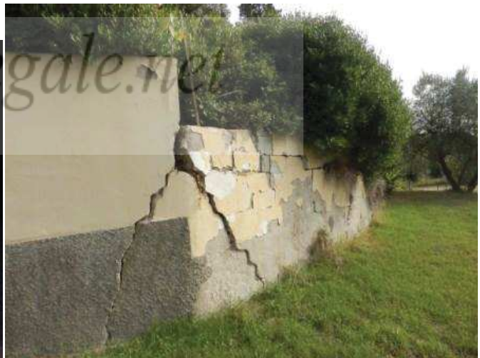
precaria staticità muro a ridosso della piscina a comune
