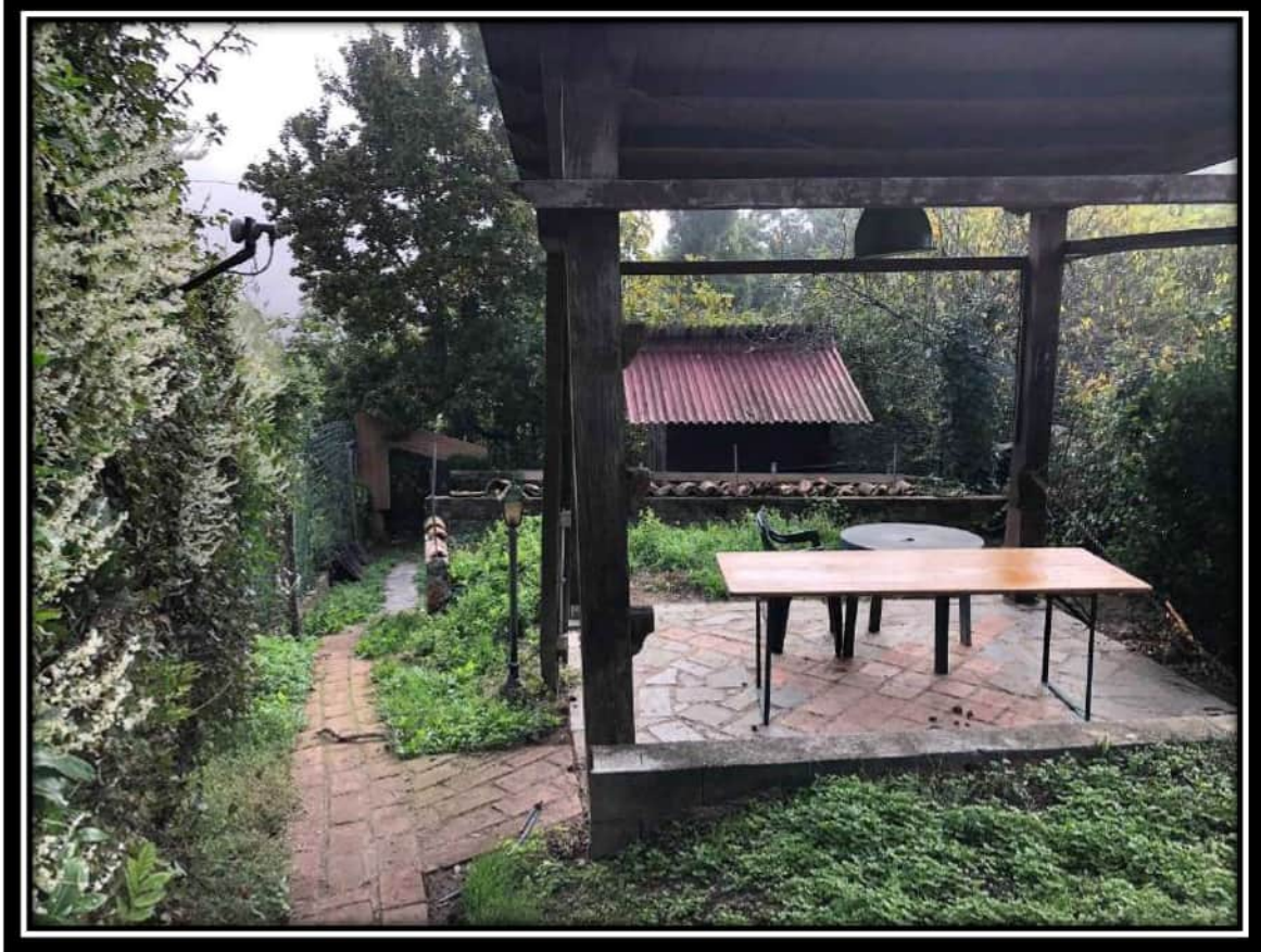
Foto 28 – Terrreno mappale 902 – Tettoia
