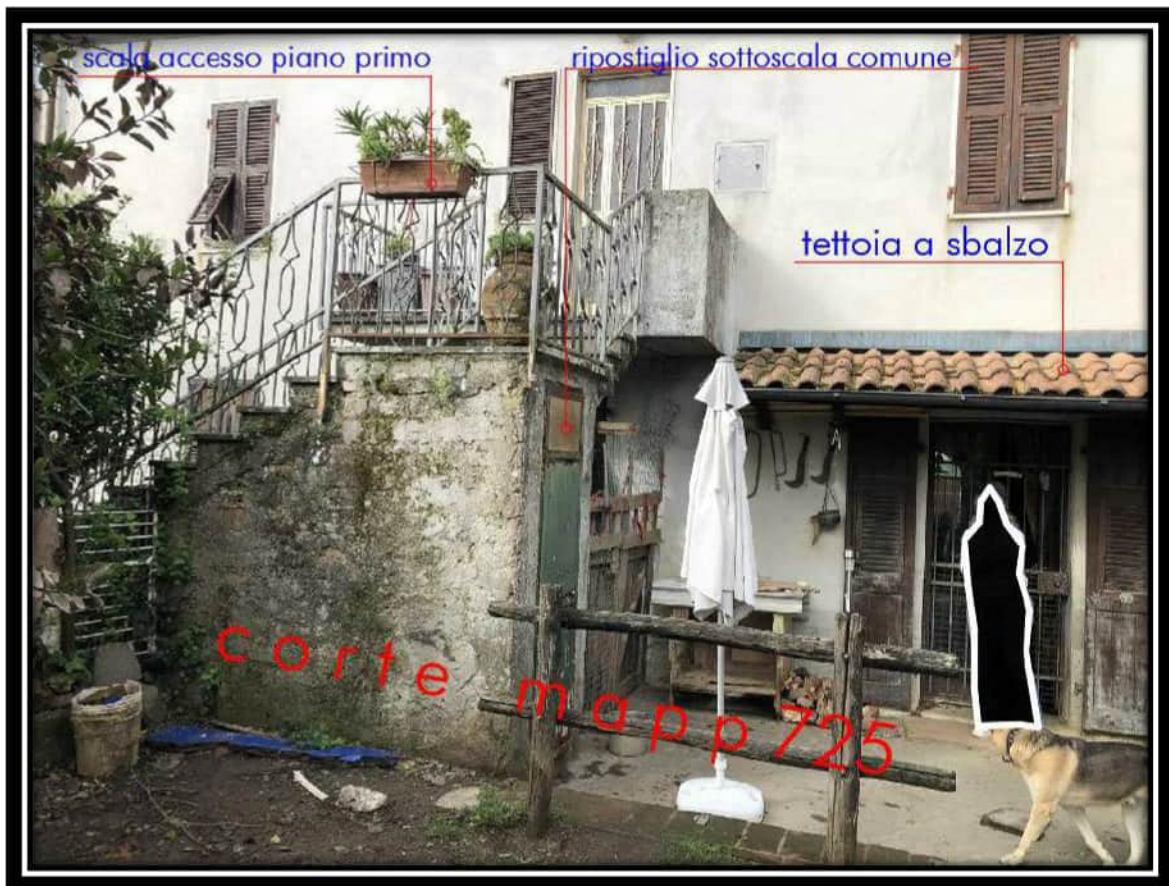
Foto 22- - Corte al mappale 725 e scala esterna di accesso al piano primo
