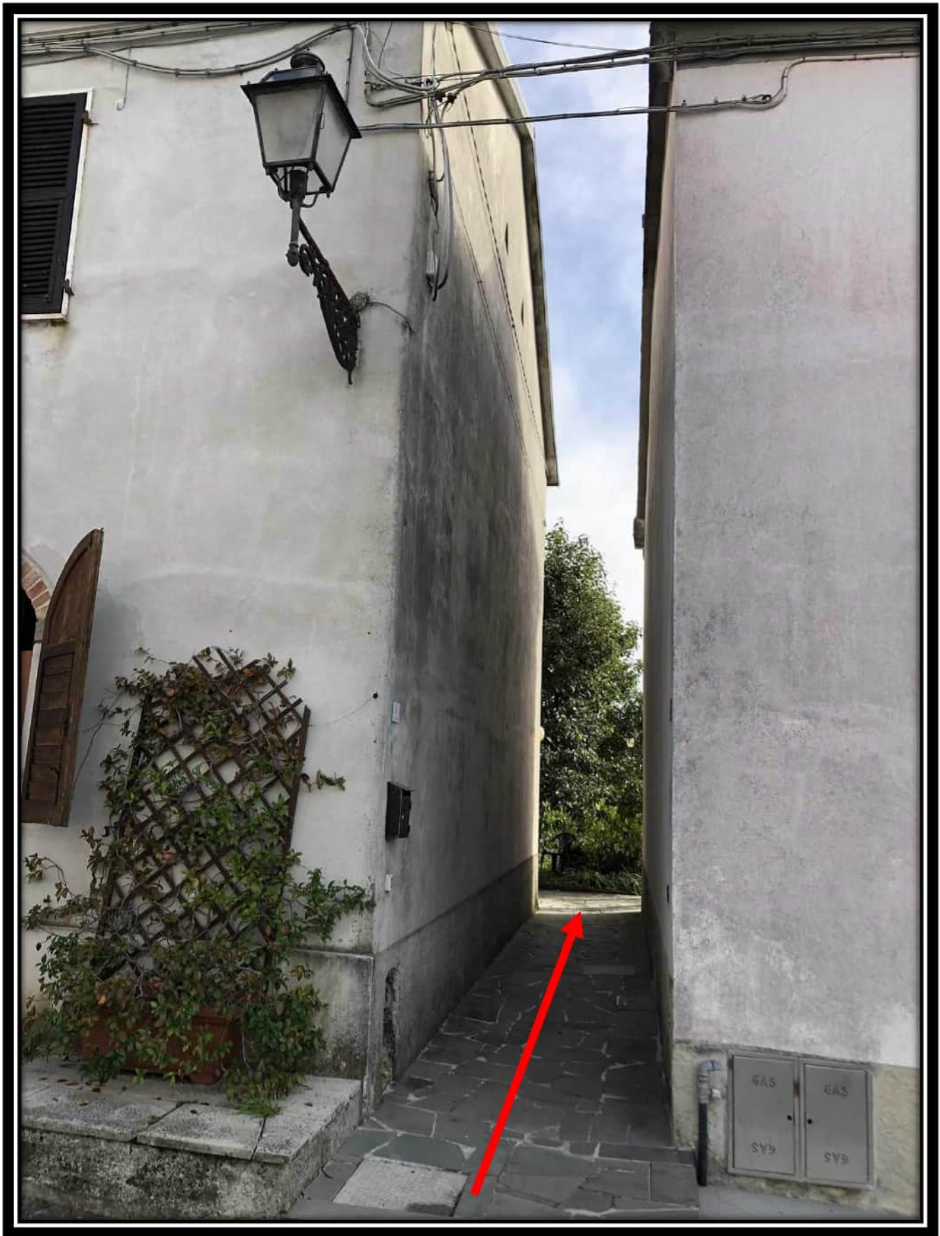
Foto 5 – Passaggio di comunicazione tra Via dell'Ardito e il mappale 725 e 902
