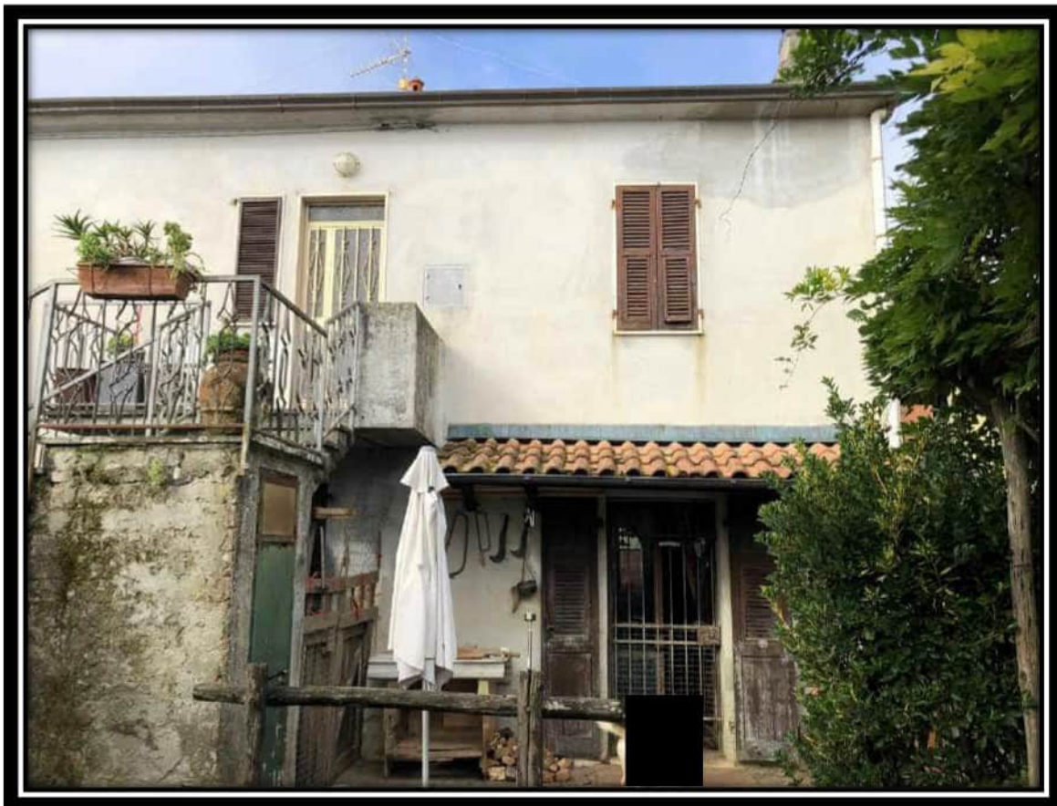
Foto 4 - Porta di uscita secondaria dal retro
