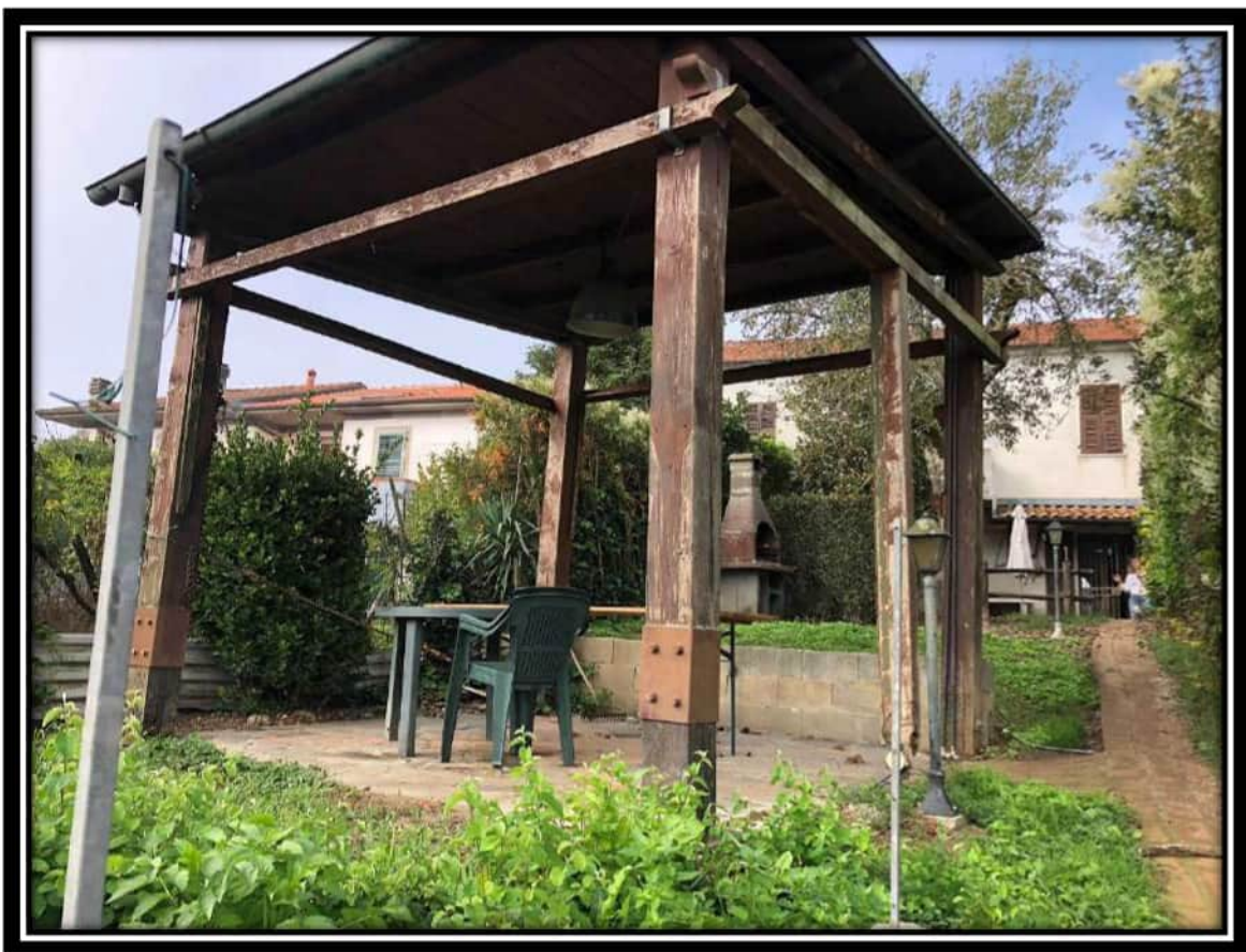
Foto 29 – Terrreno mappale 902 – Tettoia
