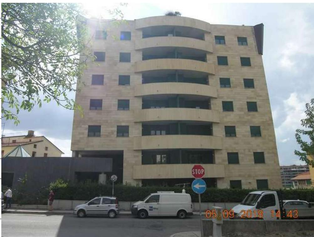
La struttura è in cemento armato a telaio, solai in
