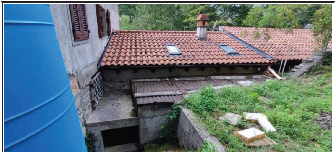
Foto n. 5 – Porzione di fabbricato oggetto di perizia – Vista sul retro
