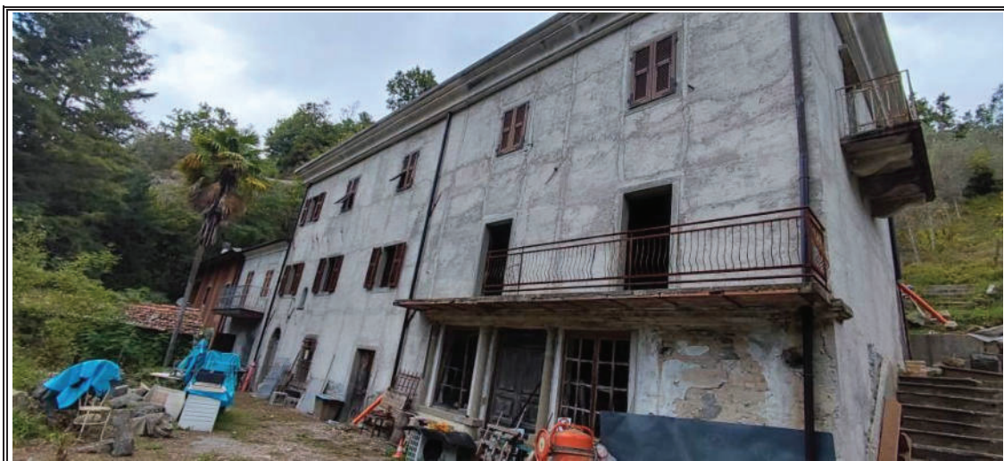
Foto n. 2 – Vista del fabbricato – Angolo SUD
