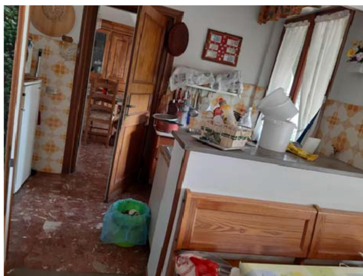
Foto n.20: muro di separazione dalla cucina demolito in parte.
