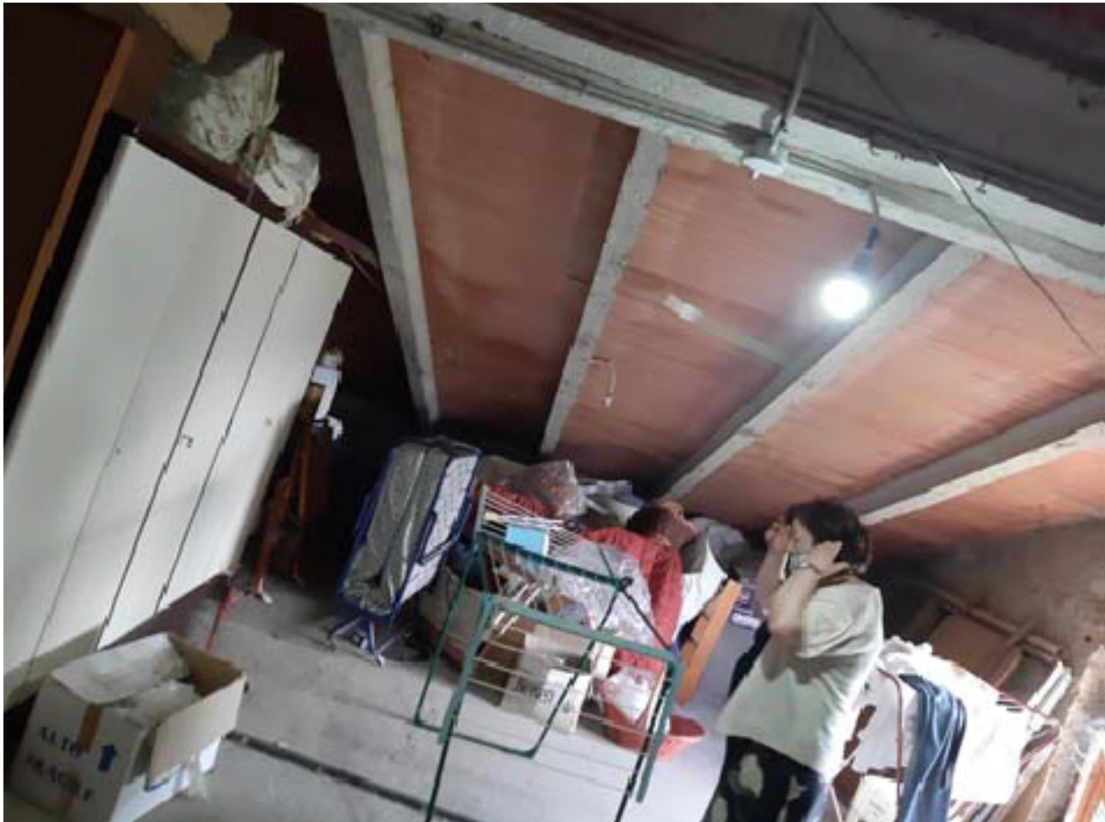
Foto n.8: Il locale di sgombero sottotetto.
