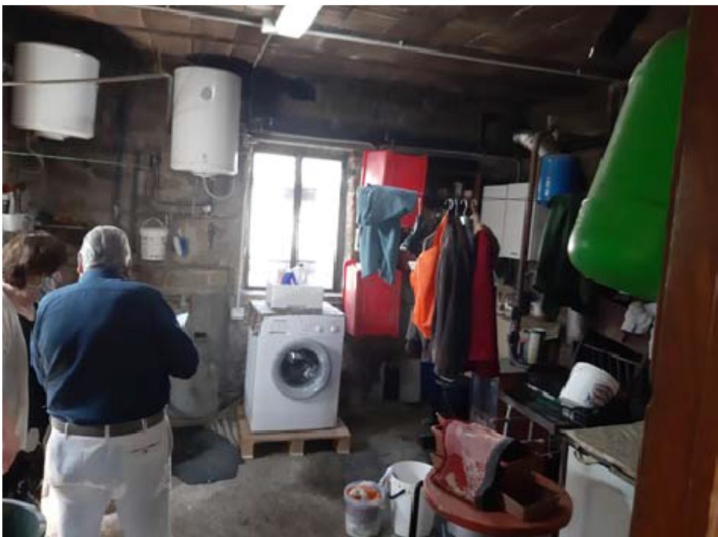
Foto n.7: La centrale termica indivisa dal garage.
