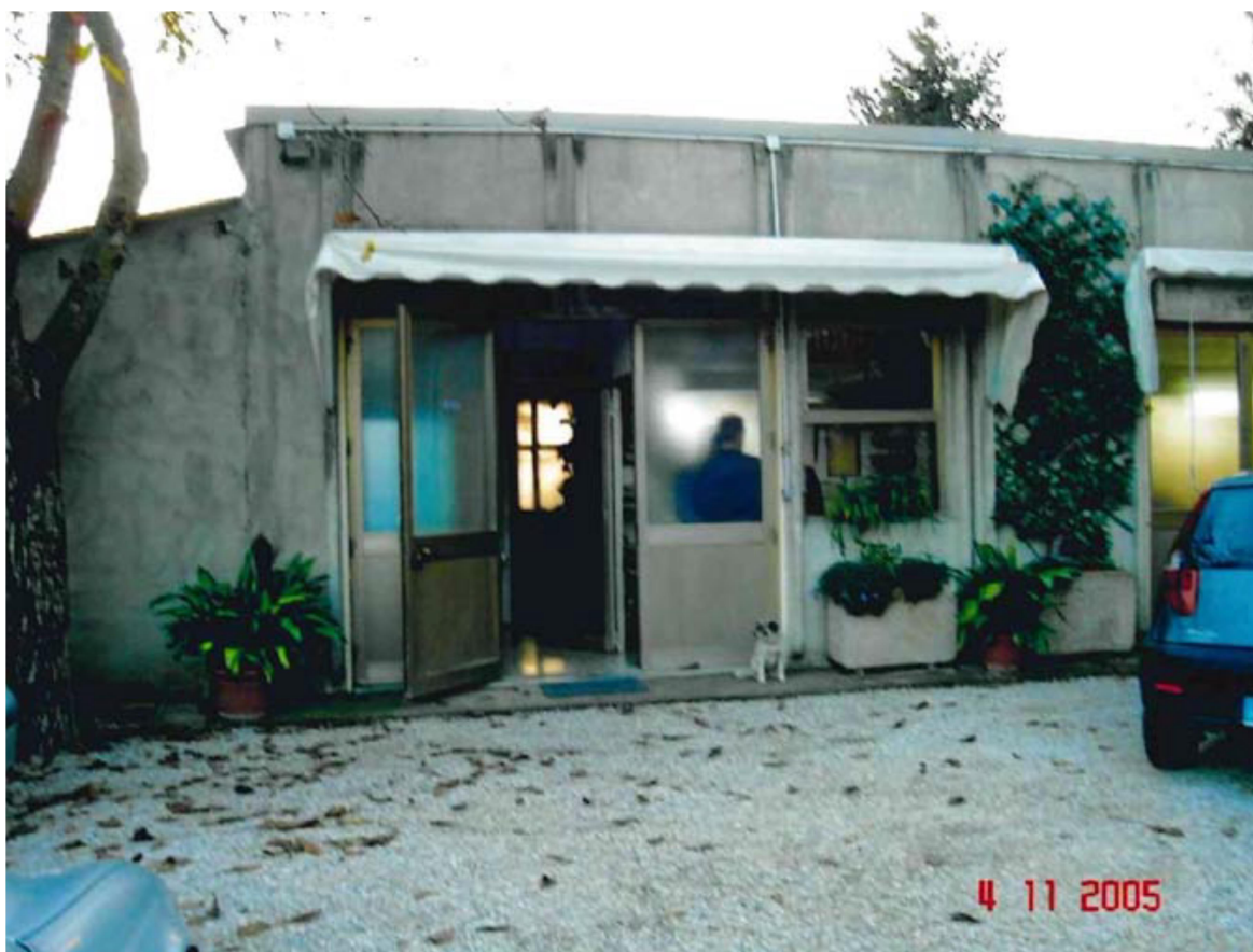
Foto n.10: Ingresso del capannone
