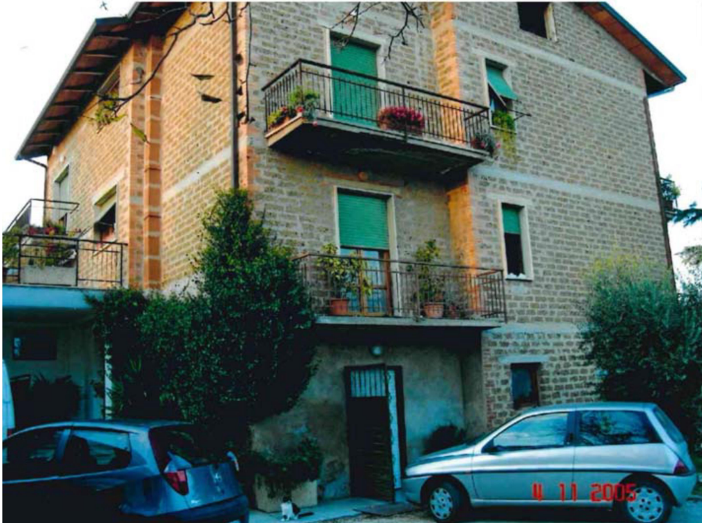
Foto n.1: Vista esterna del fabbricato
