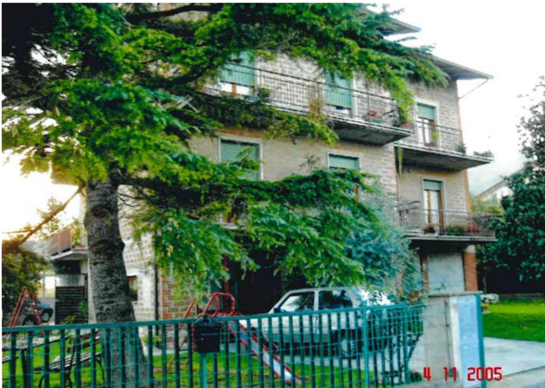
Foto n.9: il fabbricato e la corte comune condominiale.
