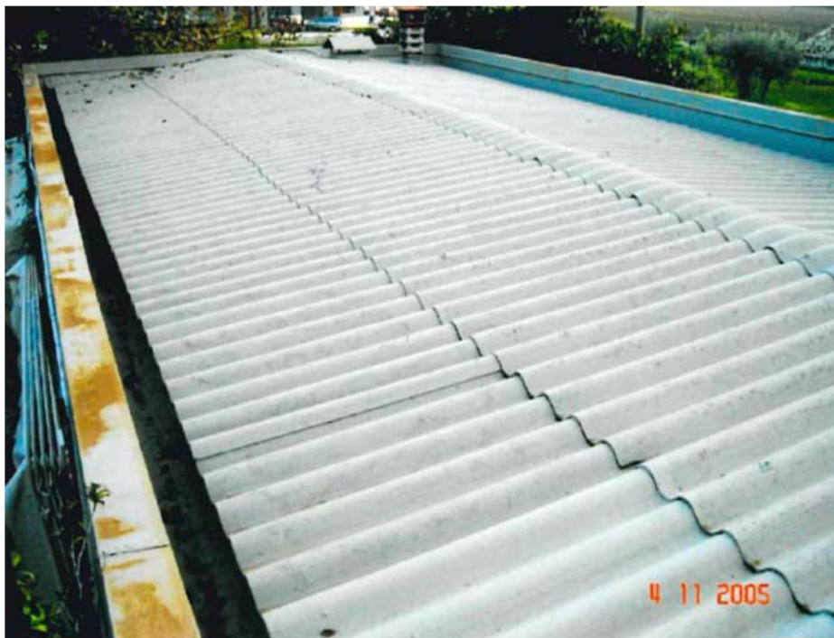
Foto n.12: Copertura del capannone
