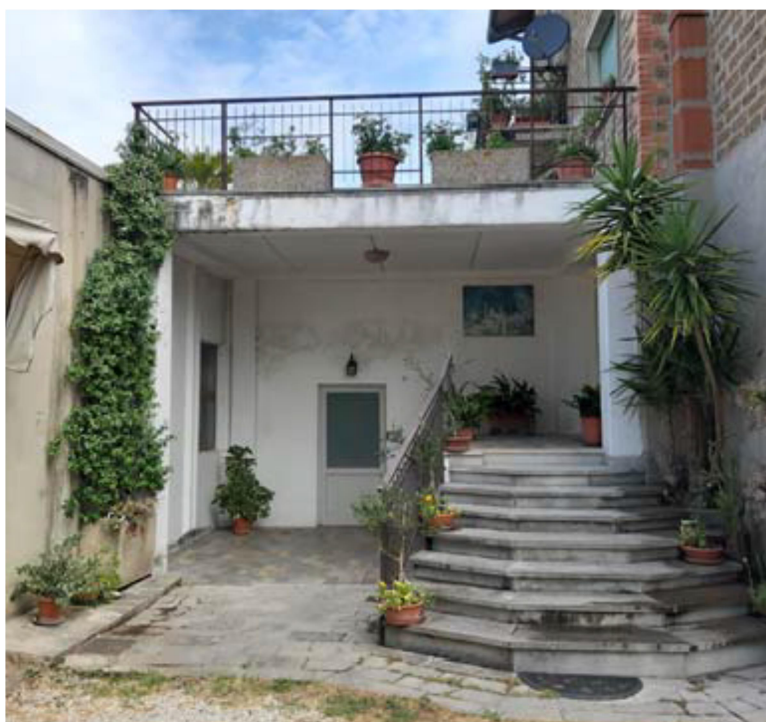
Foto n.14: Magazzino costituente corpo d'unione fra il fabbricato abitativo (a destra) ed il capannone (a sinistra), con soprastante lastrico solare usufruito da ....OMISSIS....
