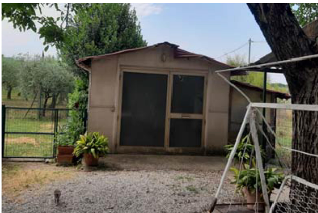
Foto n.13: Magazzino esterno annesso al capannone.
