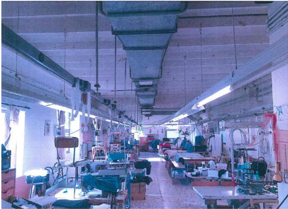
Foto n.11: Ingresso del capannone
