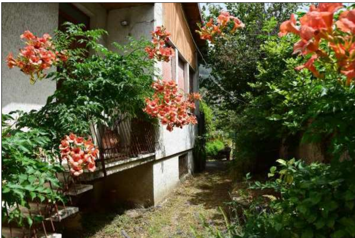
FOTO 4 - Immobile 1 -facciata Sud-Est
